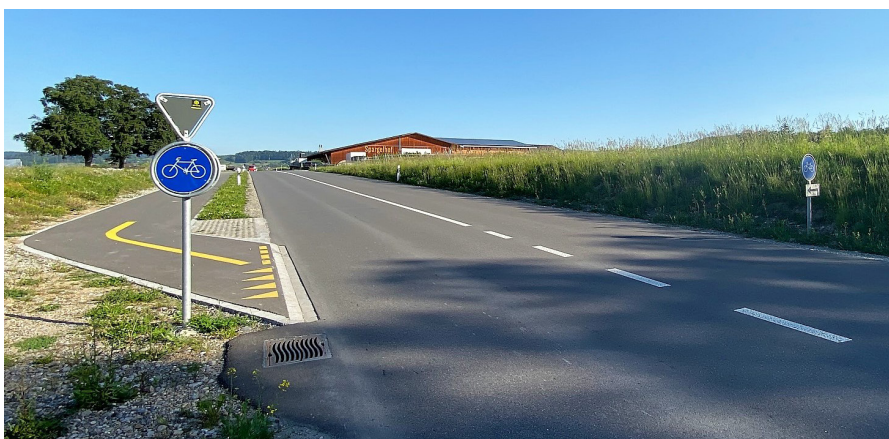
Mehr Sicherheit für den Langsamverkehr: Im Berichtsjahr wurden verschiedene Rad- und Gehwege erstellt, wie z. B. entlang der Rüdlingenstrasse im Rafzerfeld. Foto: Viktoria Herzog
