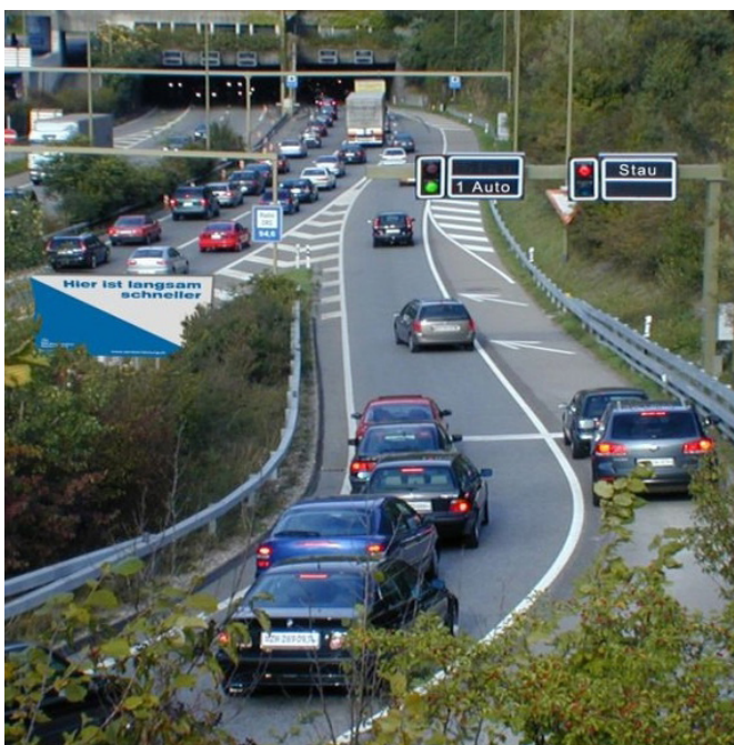
Zur Verkehrslenkung wurde am Gubrist erstmals in der Schweiz ein «Tropfenzähler»-Regelungssystem für die Autobahnzufahrten eingerichtet.
