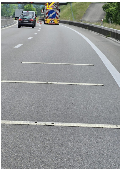
Das TBA des Kantons Zürich war das erste Tiefbauamt, das in der Schweiz auf der Autobahn Andreasschwellen einsetzte, die unachtsame Autofahrende vor Baustellen «aufweckten».
