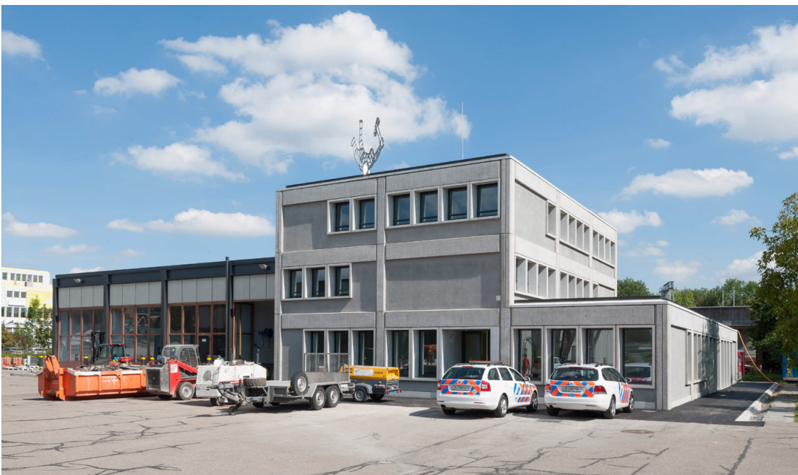
Abschluss der umfassenden Sanierungsarbeiten am Werkhof Glattbrugg. Foto: HBA
