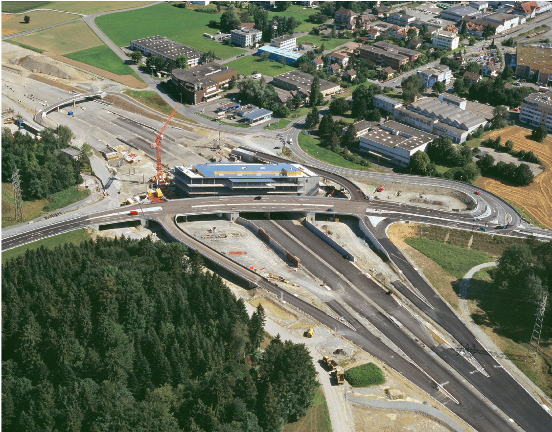
Endspurt: Das Jahrhundertbauwerk Westumfahrung befand sich im Zeitplan und ging mit Riesenschritten auf die Eröffnung zu. Foto: Desair AG
