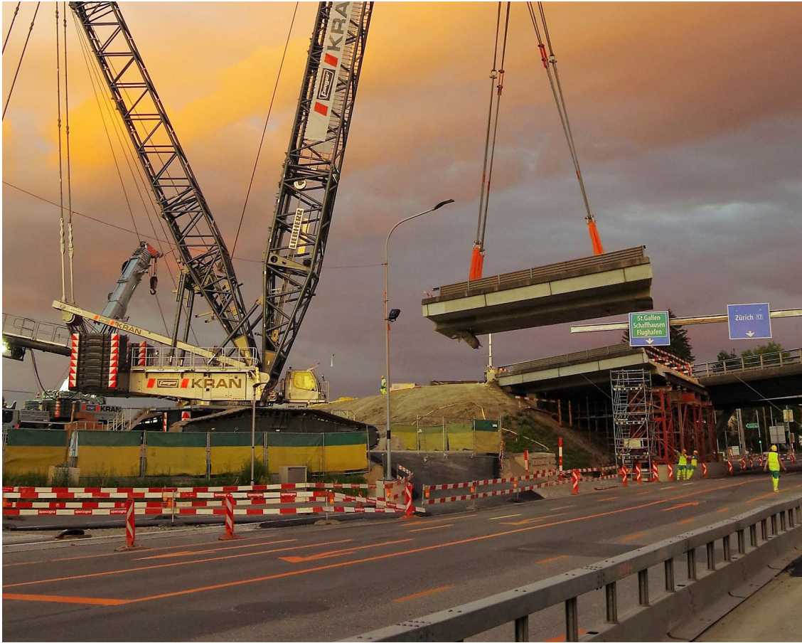
Für den Ausbau der Nordumfahrung wurde die alte Autobahnbrücke über die Wehntalerstrasse in sechs Stücke zersägt und abtransportiert.
