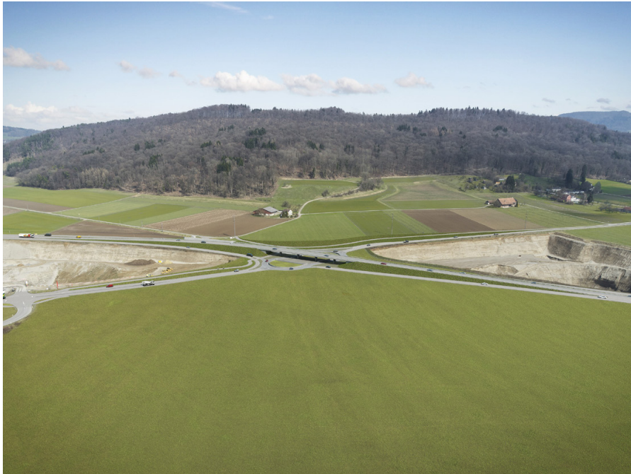
Im Juni setzte der Regierungsrat den Ausbau der Schaffhauserstrasse im Hardwald bei Bülach fest. Die Visualisierung zeigt den Kreisell Chruzstrasse von oben.
