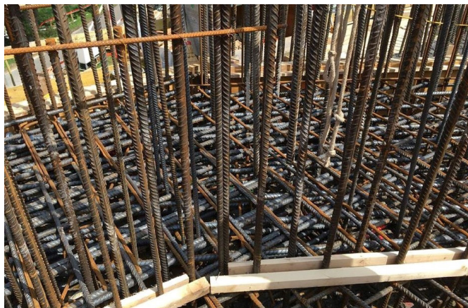
Ausschnitt der Armierung der Widerlagermauer beim Neubau der SBB-Unterführung Schönenwerd.
