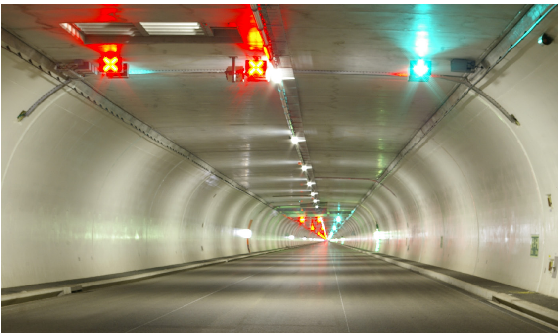
Ausbauarbeiten: In den Tunnels, im Bild der Isisbergtunnel, wurden technische Installationen wie die Lichtsignalanlagen installiert und getestet.
