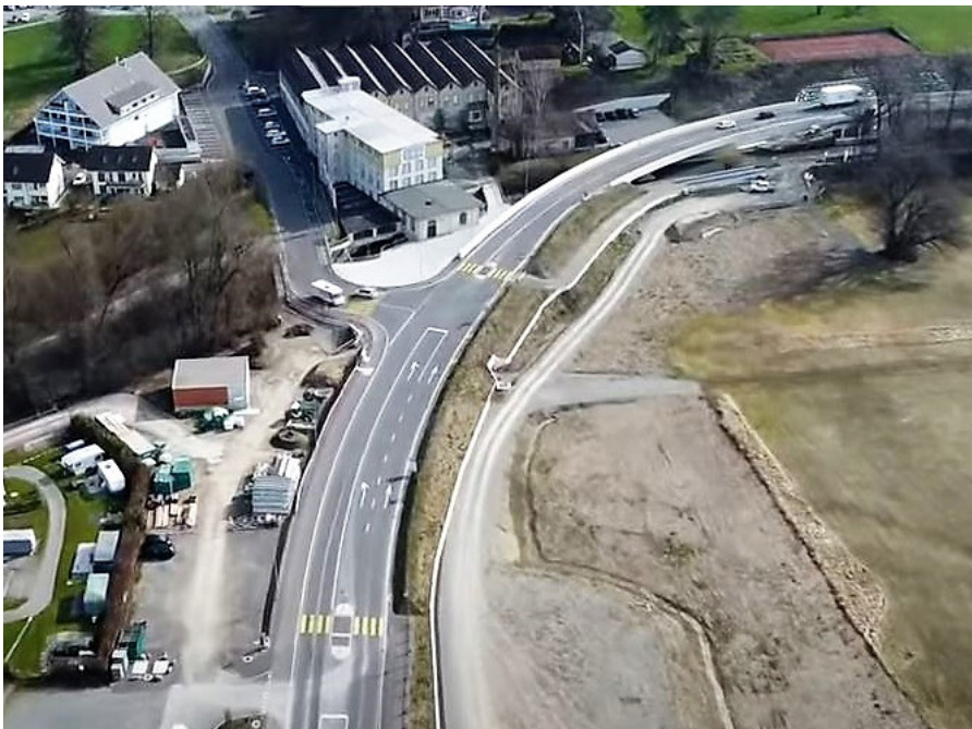
Zeitplan eingehalten: Nach rund dreijähriger Bauzeit wurde der Autobahnzubringer A4 im Mai fertiggestellt.
