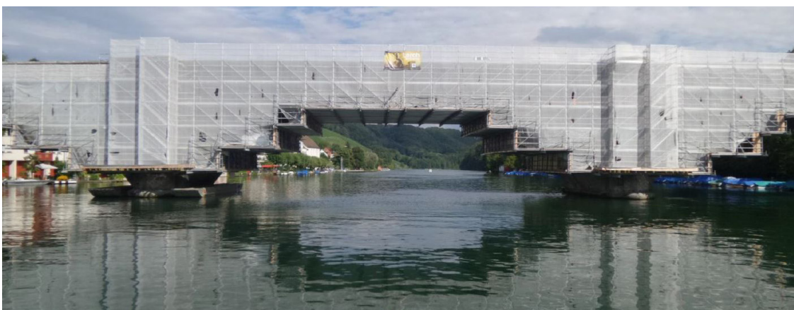
Zwischen März und Mitte Oktober wurde die Rheinbrücke in Eglisau saniert.
