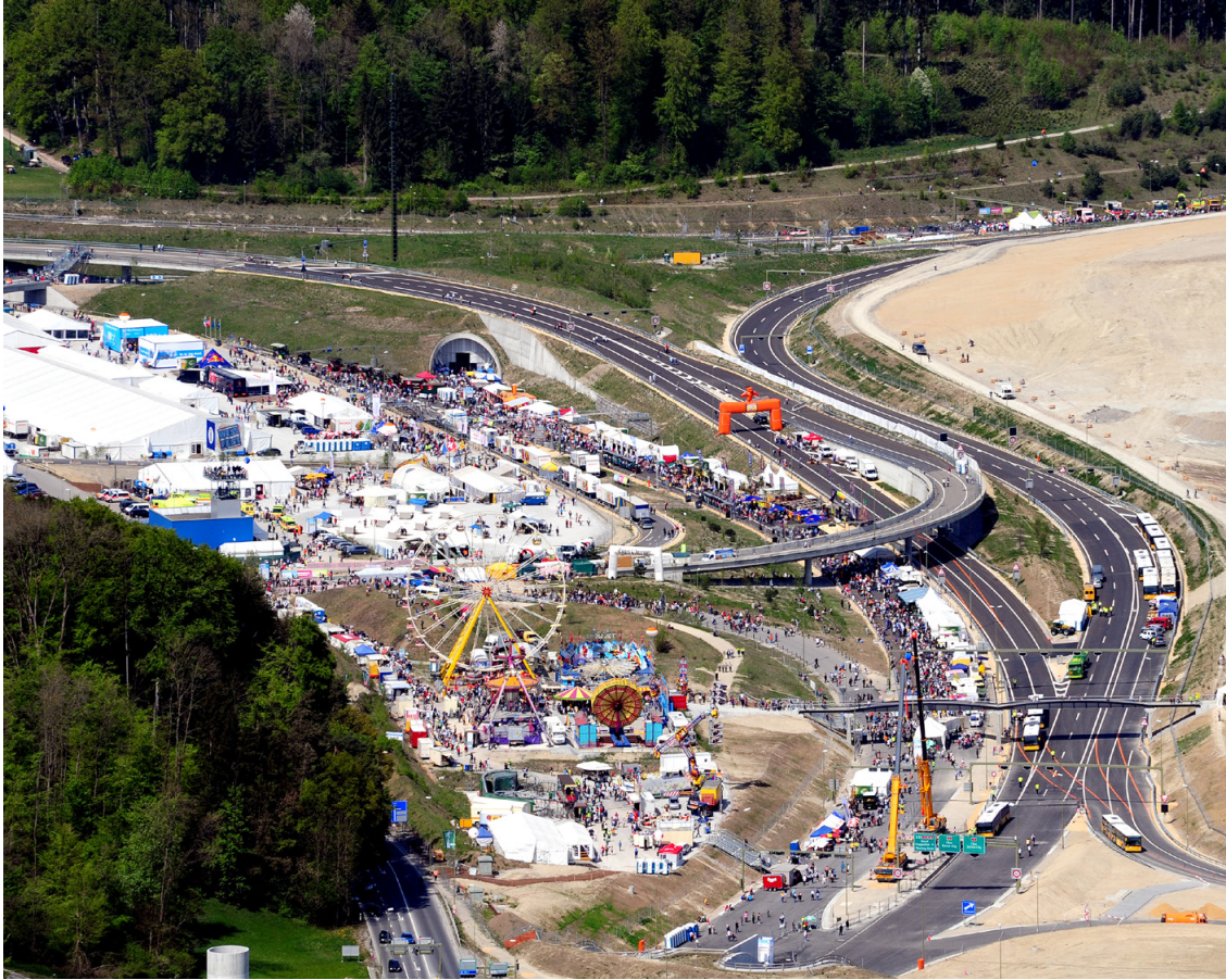
Rauschendes Volksfest: 150000 Personen feierten während drei Tagen die Eröffnung der Westumfahrung.
