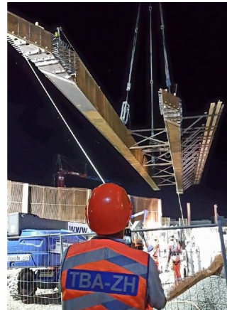
Spektakulärer Ausbau der alten Schönenwerd-Brücke aus den 1930er-Jahren in Dietlikon mit dem grössten Raupenkran der Schweiz.
