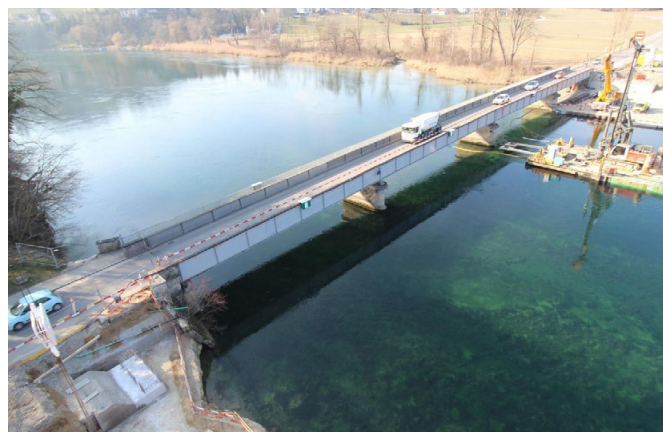
Die Bauarbeiten für die neue Rheinbrücke zwischen Flaach und Rüdlingen begannen Anfang Dezember. Sie dauern rund zwei Jahre.
