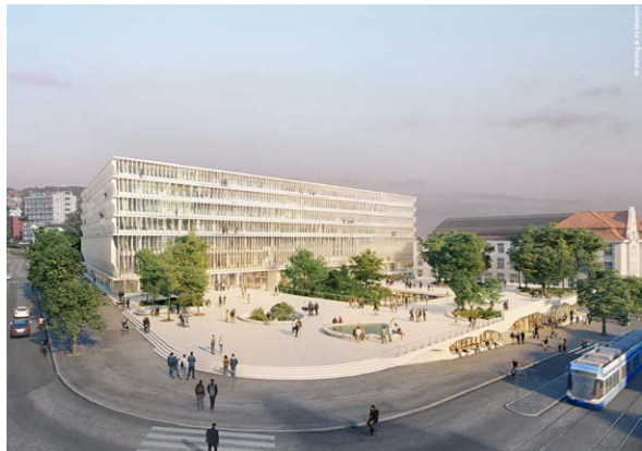
Blick vom Kollegiengebäude der UZH: Es entsteht ein zentraler Platz mit grossen Bäumen im Herzen des Hochschulquartiers. © Herzog & de Meuron
