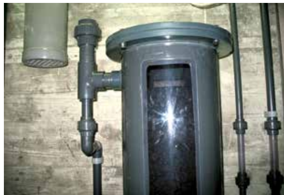
Abb. 7.2.7 Beispiel eines Restozon-Vernichters
