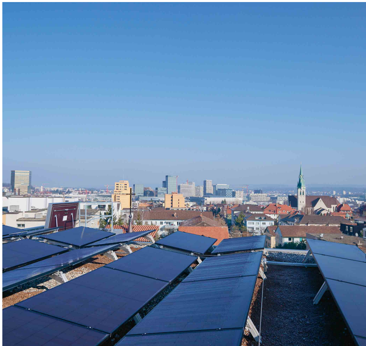
Photovoltaik-Anlage Neubau Dörflistrasse 11 | Foto: Barbara Héritier
