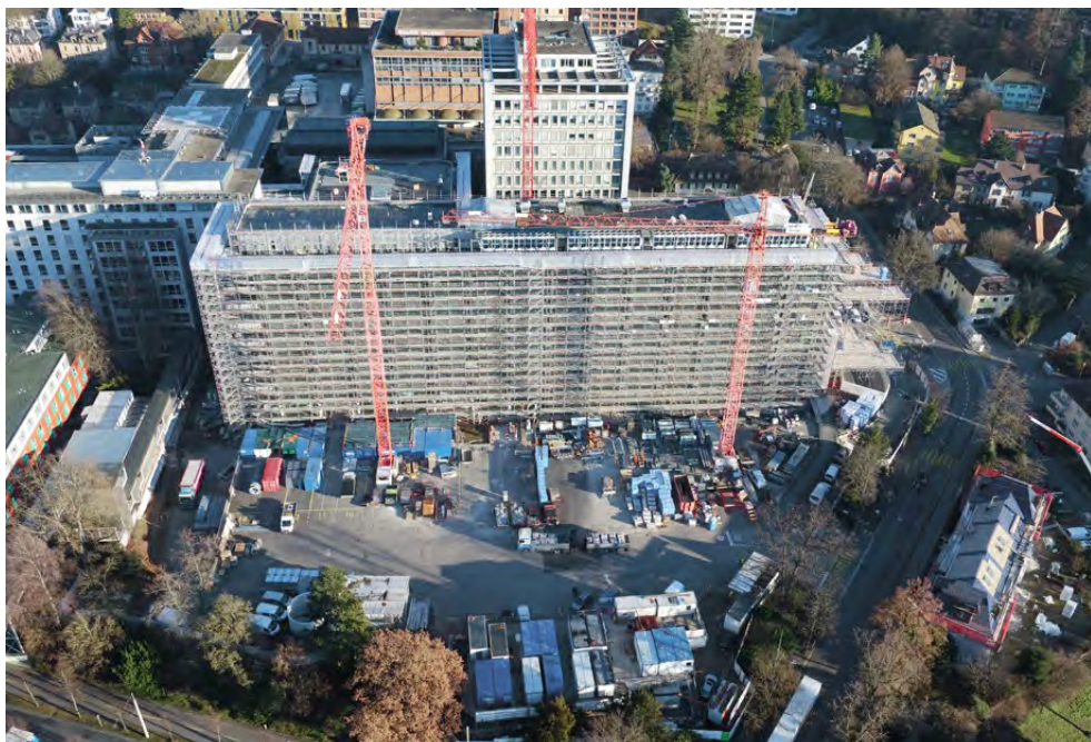
Der Neubau wird das Bettenhochhaus aus den 1960er Jahren ersetzen.
