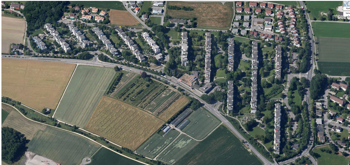
Abb. 3: Schrägluftbild der Siedlung Sonnhalde
