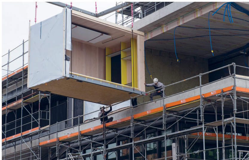
Pilotprojekt Kanton: Einbau eines Moduls in der Forschungsplattform NEST in Dübendorf
