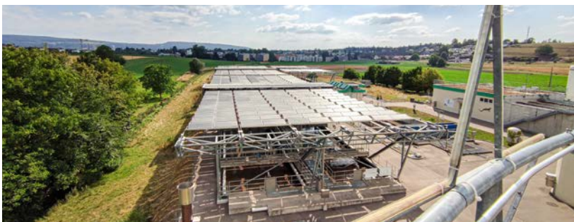
Beispiel einer PV-Anlage über den Klärbecken. Solche Anlagen können Synergien mit bestehender Infrastruktur bilden. Im Bild: ARA Bassersdorf ZH. Quelle: D. Anderegg
