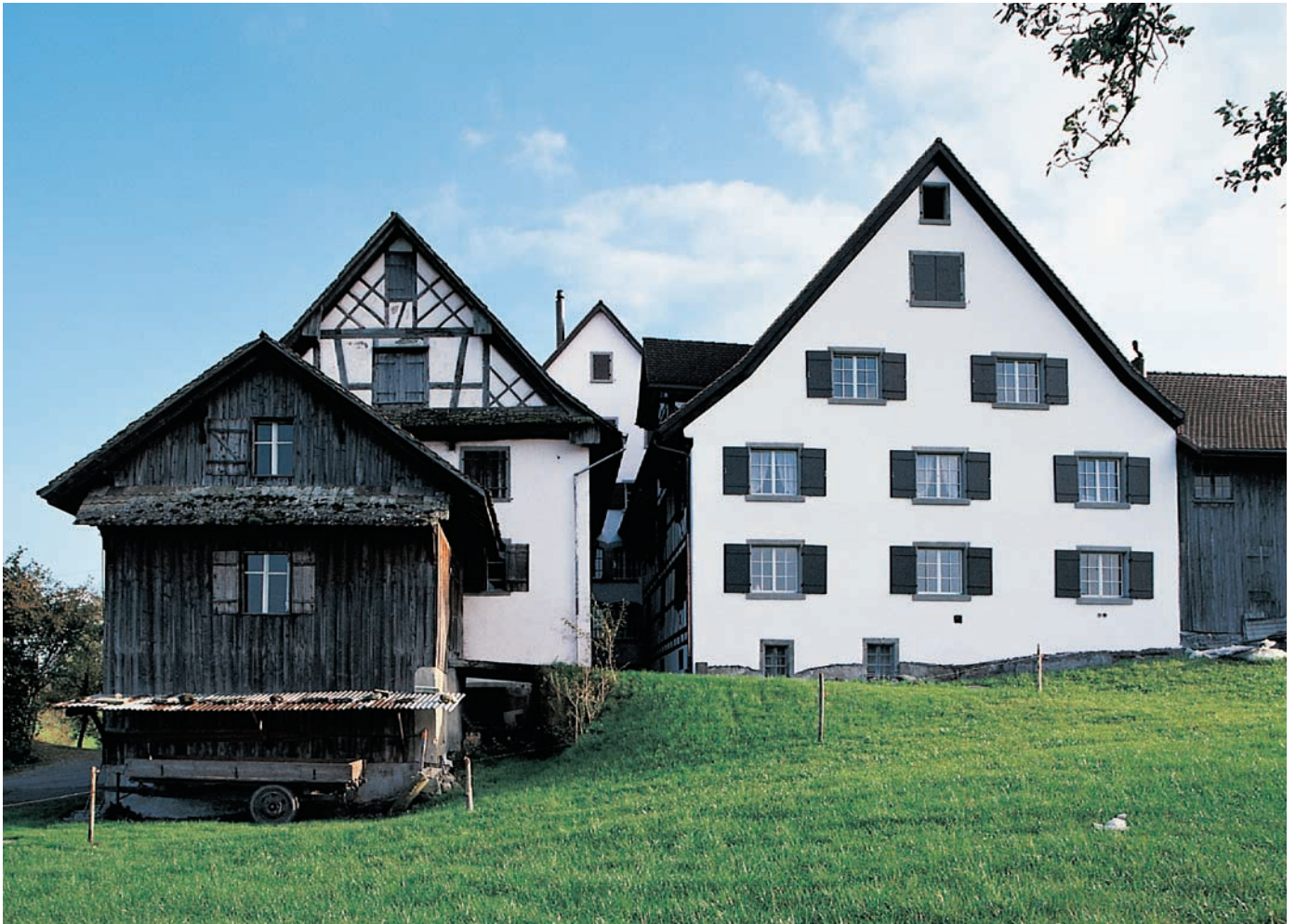
Nordwestliche Giebelseite des Wohnhauses (Mitte hinten) mit den Trotthausanbauten von 1821 (links) und um 1800 (rechts). Im Vordergrund links Schopfanbau.
