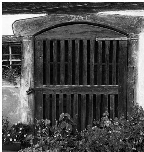
Links: Kellerportal. Holztüre mit Lüftungsschlitzen. Rechts: Eingekerbte Jahreszahl 1654 im schildbogigen Türsturz.
