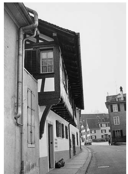
Fassade gegen die Schönenbergstrasse, mit vorkragendem Geschoss.
