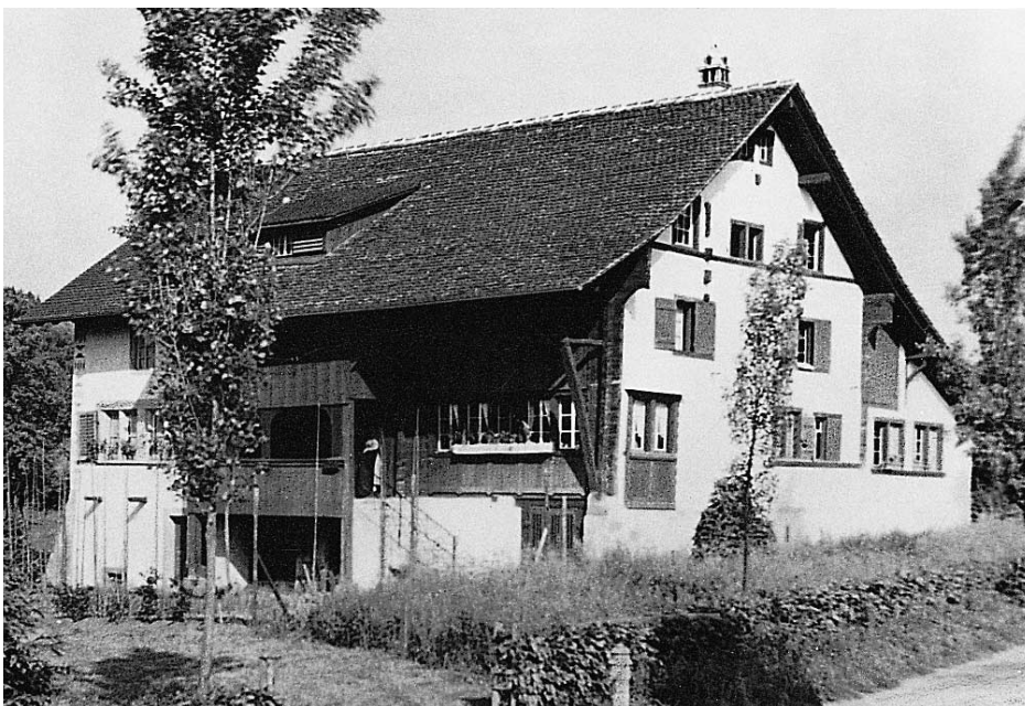
Das Alte Büelenhaus vor der Restaurierung von 1984/85.
