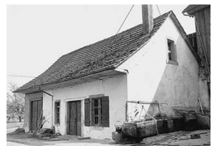
Einstiges Waschhaus mit Brennerei Vers.-Nr. 1600.
