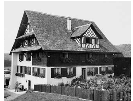
Südliche Giebfassade: Verputz, Bohlen- und Fachwerkwandteile. Fachwerk mit Klebdächern im Giebfeld.
