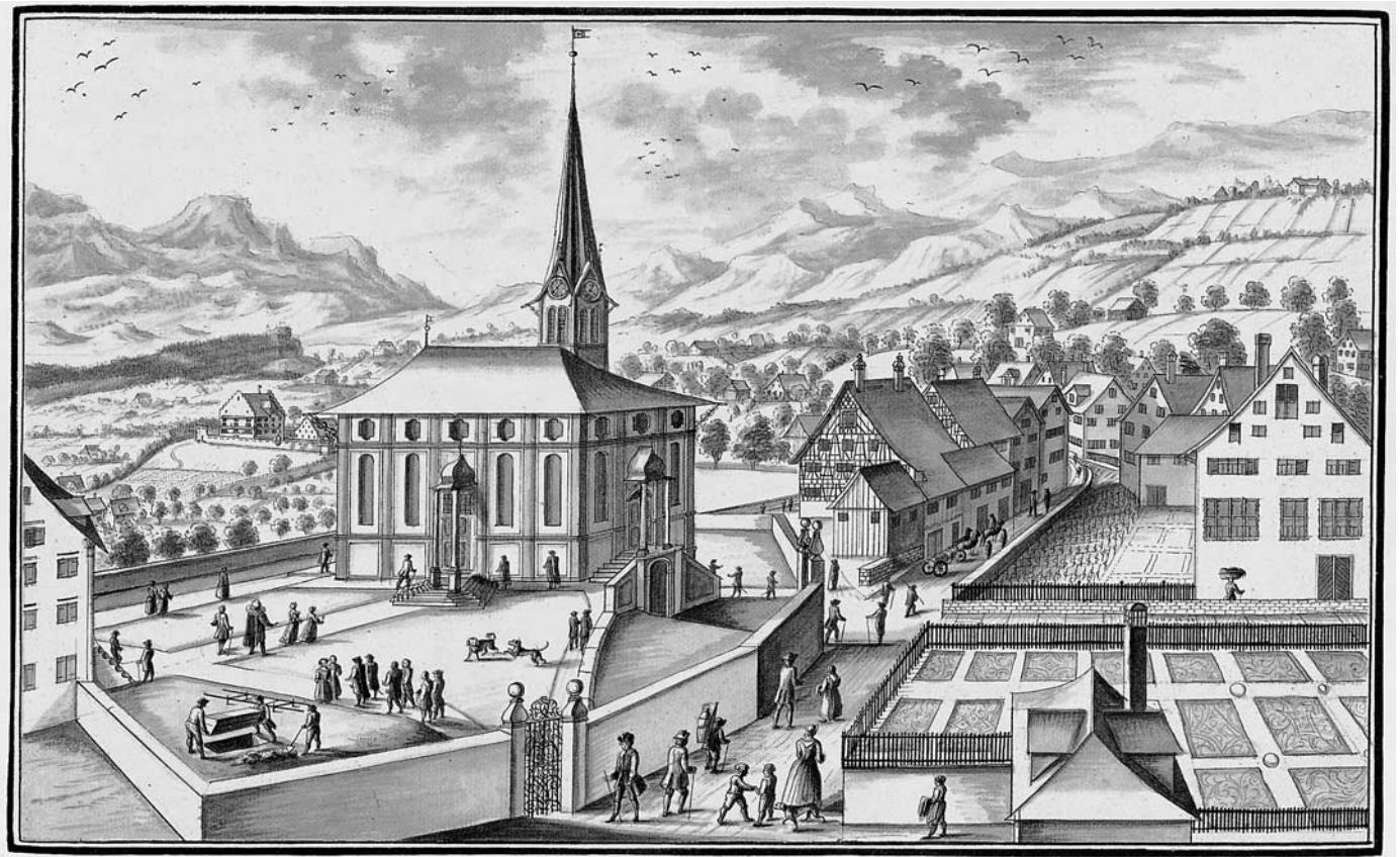
«Prospect von Wädenschweil No. 1» von Johann Jakob Hofmann, 1771. Im Zentrum das spätere Julius Hauser-Haus.
