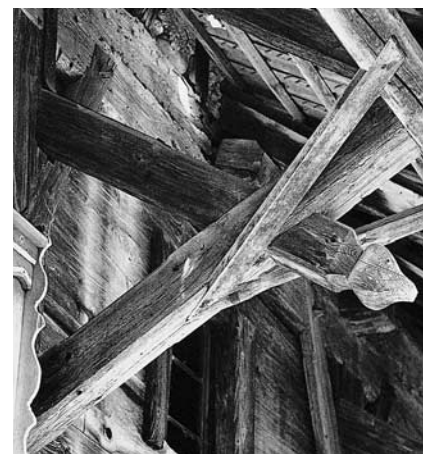
Vordachabstützung mit verziertem Zugband.
