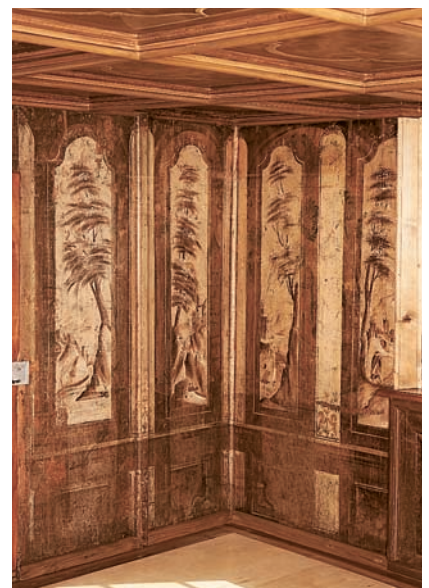
Oben: In der südlichen Eckstube im ersten Obergeschoss wurde 1987/88 figürlich bemaltes Wand- und Deckentäfer freigelegt und restauriert.
