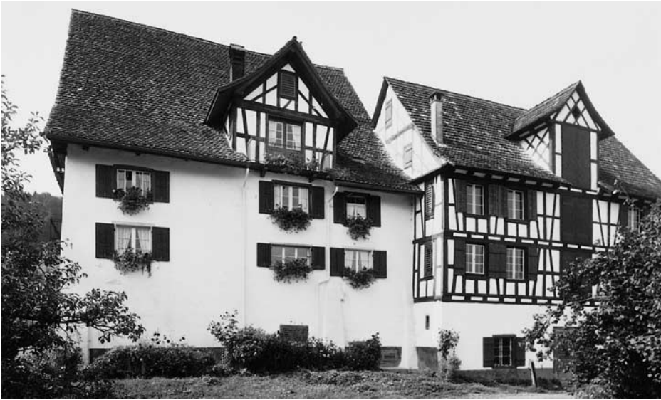
Seeseitige Trauffassade des Wohnhaus- teils, Vers.-Nr. 1465 (links) und 1821 angebautes Trotthaus (rechts).
