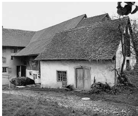
Links: Oberer Meierhof. Waschhaus Vers.-Nr. 107, Ansicht von Westen. Rechts: Unterer Meierhof, Haus Vers.-Nrn. 102/103 von Süden, 1999.
