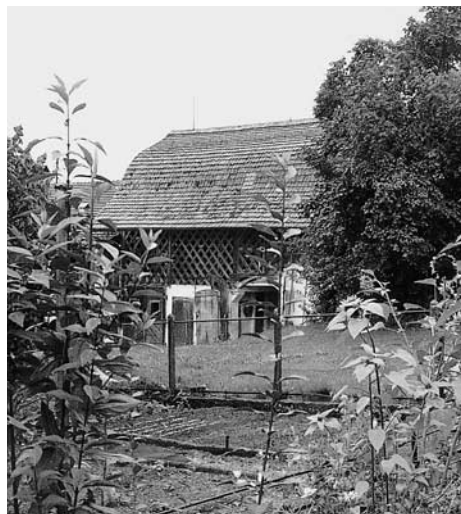
Detail der Scheune Vers.-Nr. 877 mit Vorgarten (links). Stallscheune Vers.-Nr. 885 von 1854.
