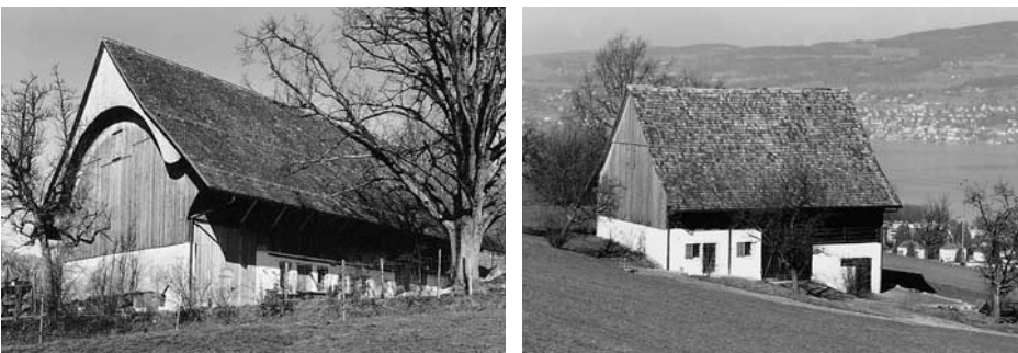
Links: Scheune Vers.-Nr. 1252, erbaut 1875, nach der Renovation von 1988. Rechts: Die 1820/21 erbaute Feldscheune «Mangeli», Vers.-Nr. 1242, am Abhang gegen den Zürichsee.
