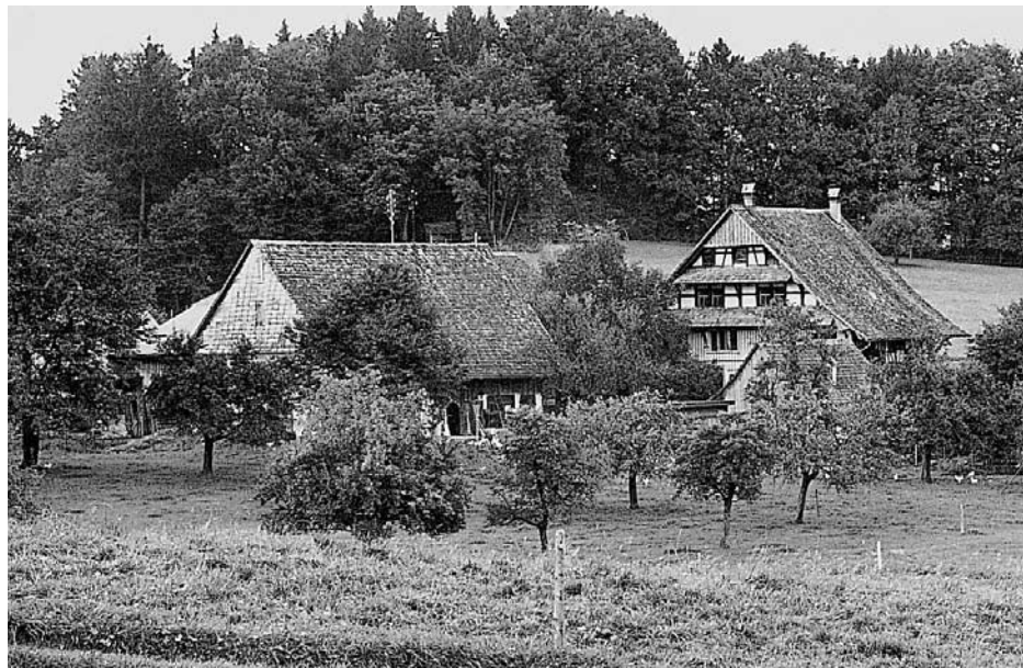
Hof Vordere Rüti. Ansicht von Süden, 1975.
