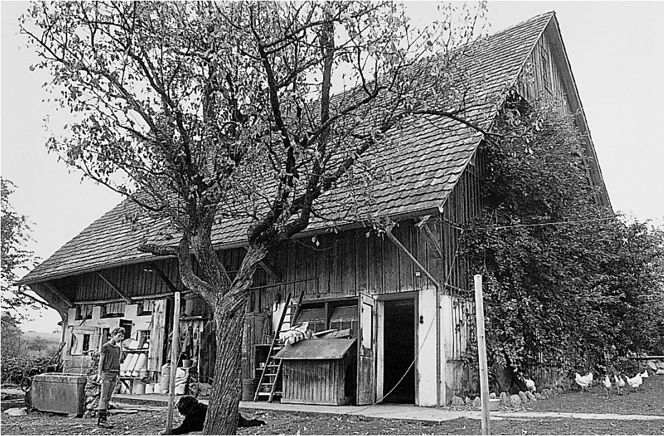
Nordostansicht der Stallscheune Vers.-Nr. 1538.
