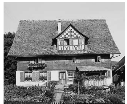
Östliche Traufseite mit Bohlenwand im Obergeschoss.
