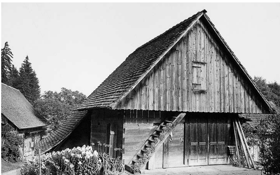
Doppelspeicher Vers.-Nr. 1464 mit schirmartig verbrettertem Ostgiebel. Gezinkter Blockbau über gemauertem Kellergeschoss.
