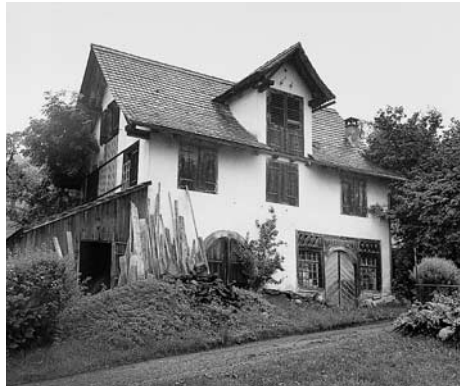
Links: «Lohziger»- und Wagenschopf Vers.-Nr. 884 aus der Zeit um 1895. Rechts: Das Kellergebäude Vers.-Nr. 883 wurde 1983 teilweise renoviert.
