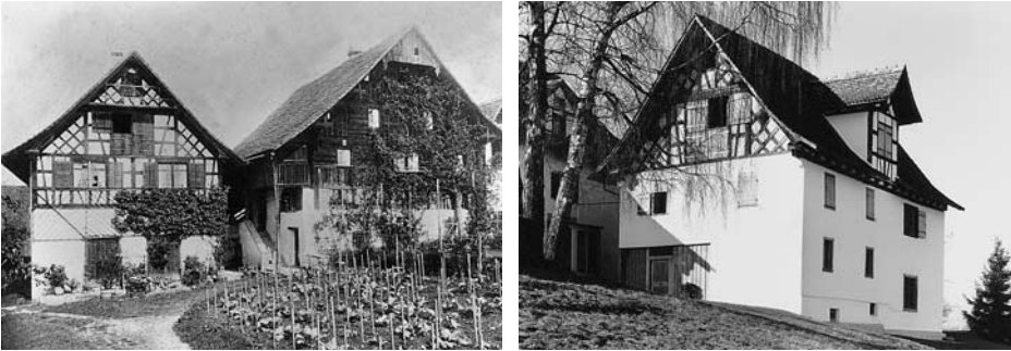
Links: Ehemaliges Trottgebäude vor dem Umbau 1903 (links) und Wohnhaus (rechts). Zustand um 1900. Rechts: Ehemaliges Trottgebäude Vers.-Nr. 1249 aus dem 18. Jahrhundert, seit 1864 Waschhaus.
