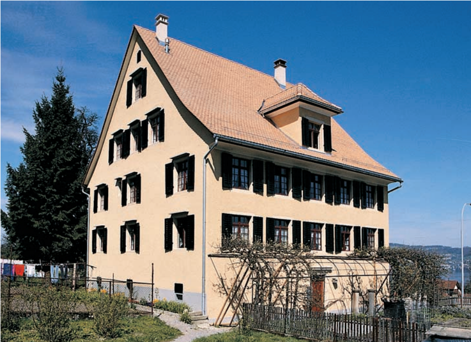
Das 1819 erstellte Bauernhaus Vers.-Nr. 882 auf Rötiboden wurde 1998 restauriert.
