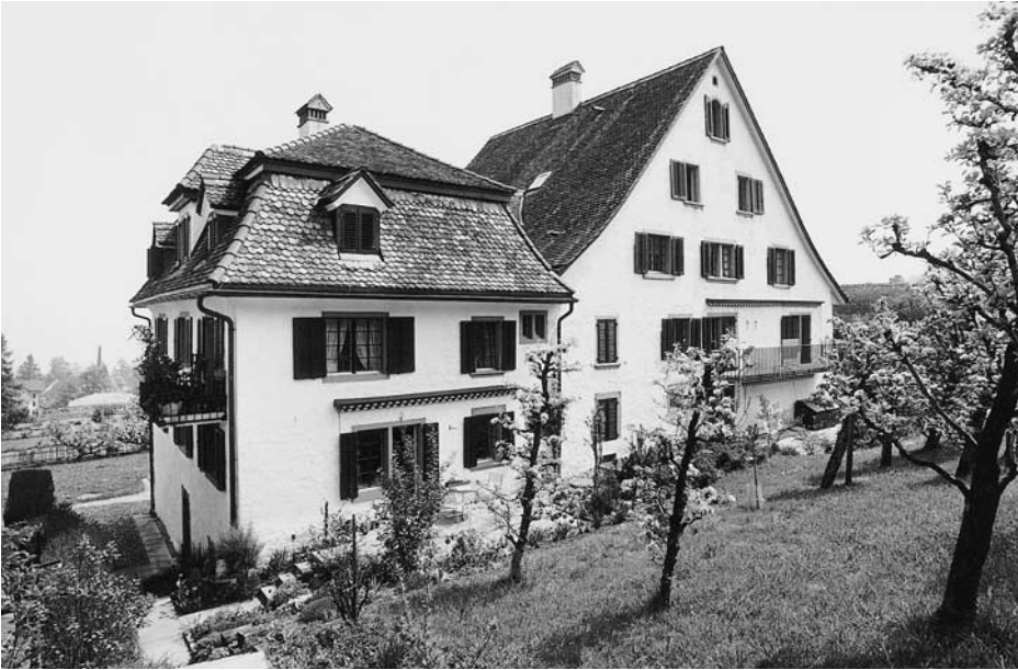
Stammhaus Rötiboden Vers.-Nr. 880. Bergseitige Ansicht, mit ursprünglich als Trotte genutztem Anbau von 1793 unter Mansarddach.
