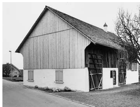
Links: Seeseitige Giebelfassade mit Bretterverschalung, 1997. Rechts: Bergseitige Giebelfassade des Ökonomieteils.
