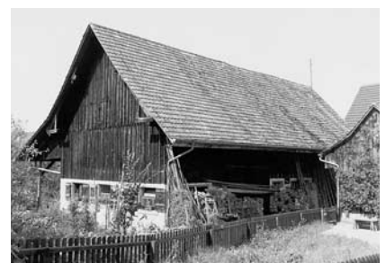
Die 1928 erweiterte Stallscheune Vers.-Nr. 111.
