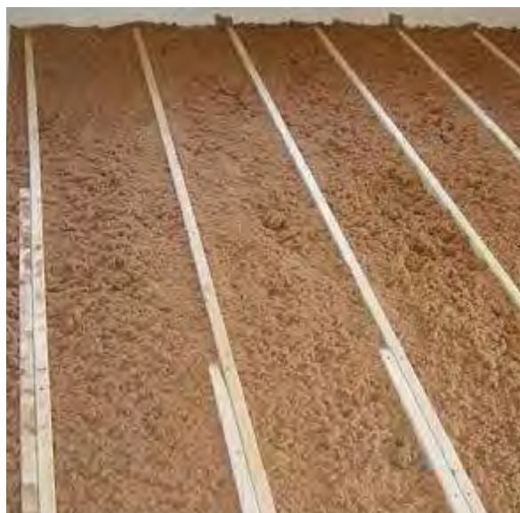
Weiche Dämmung, zwischen Lattung aufgefüllt (Abb. 88)
