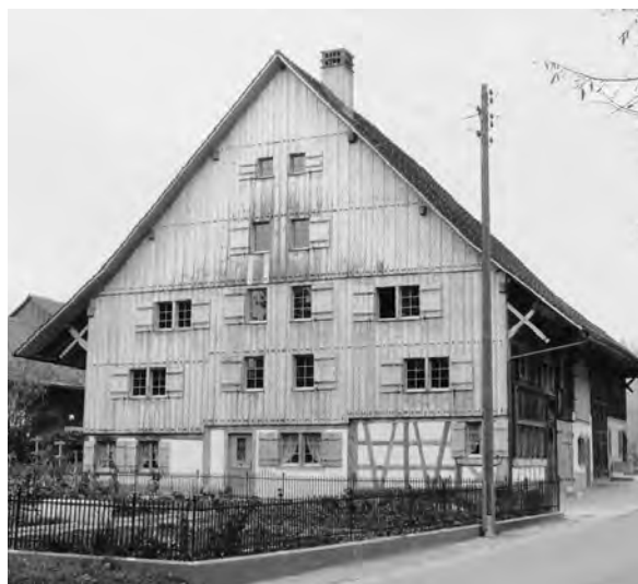
Vielzweckhaus in Horben, Gemeinde Illnau-Effretikon, Partiiel verschalte Wetterseite (Abb. 74)
