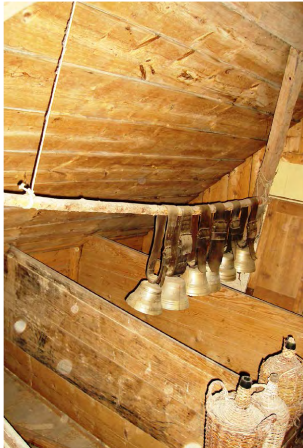
Berner Wohnstock, brettverschalter Dachraum mit Kornkästen (Abb. 84)
