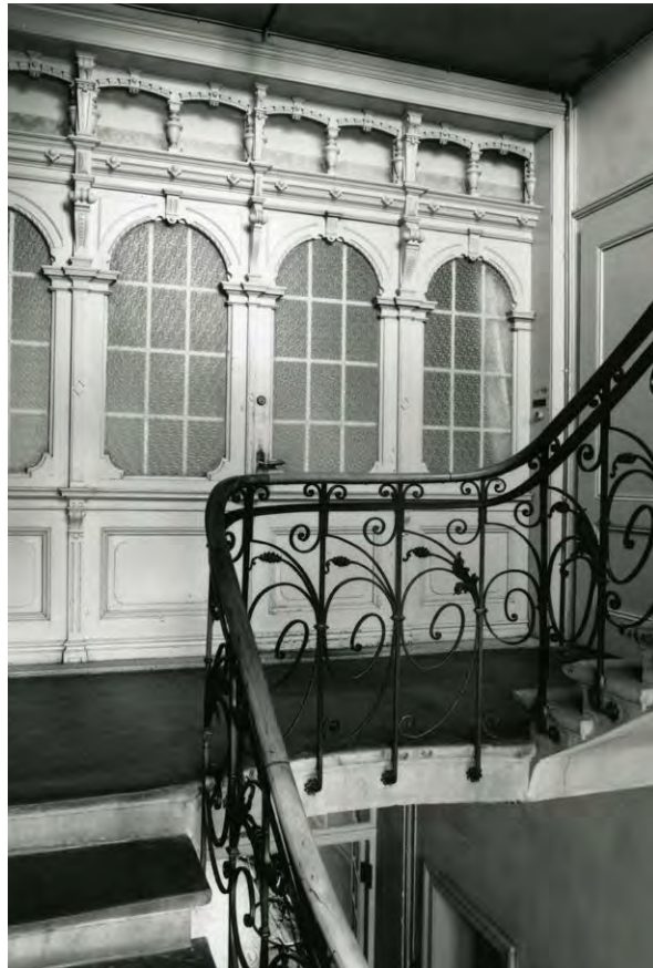
Treppenhaus Wohn- und Geschäftshaus, Fribourg (Abb. 78)
