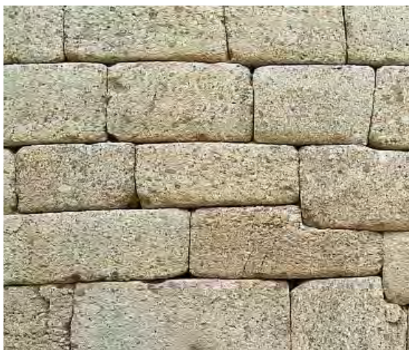
Mörtellos aufgeschichtetes Hausteinmauerwerk, Mykene, ca. 1500 v. Chr. (Abb. 47)
