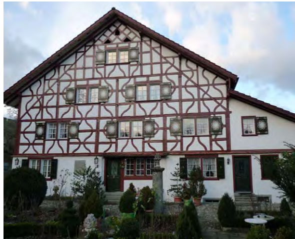
Wila, Gebäude Nr. 471; Fachwerkbau mit hohem Fugenanteil (Abb. 71)
