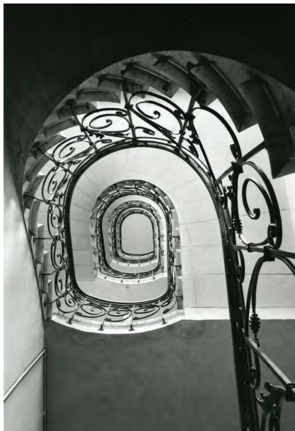
Eingangsfront zu einer Wohnung / Treppenaue (Abb. 79)
