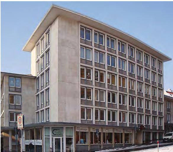
Wohn- und Geschäftshaus in Kassel. Innen gedämmt mit 80 mm kapillaraktivem Dämmmaterial (Abb. 56)
