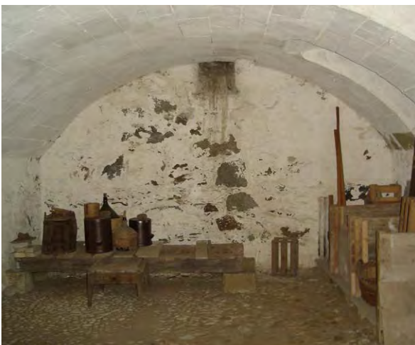
Gewölbekeller eines bernischen Landsitzes aus dem 17. Jahrhundert (Abb. 44)
