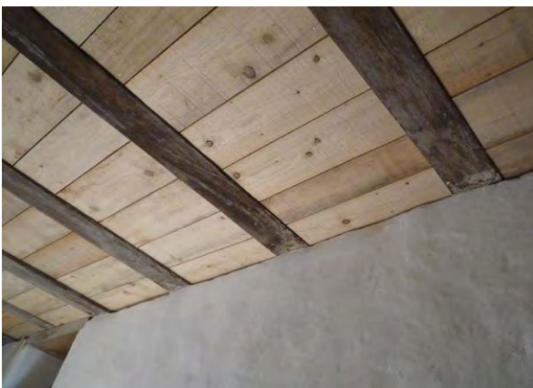
Gossau, Allenwinden, sorgfältig gedämmte Kellerdecke (Abb. 43)
