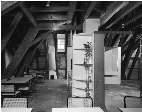
Unterdachschalung, ausgebauter Dachstock Münsterstrasse Bern (Abb. 92)
