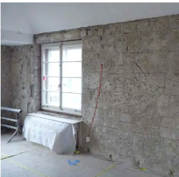
Küsnacht, Villa Rudolph, 1931, originale Vorsatzschale aus Gasbeton, als Dämmung und zur Anhebung der Oberflächentemperatur (Abb. 49)
