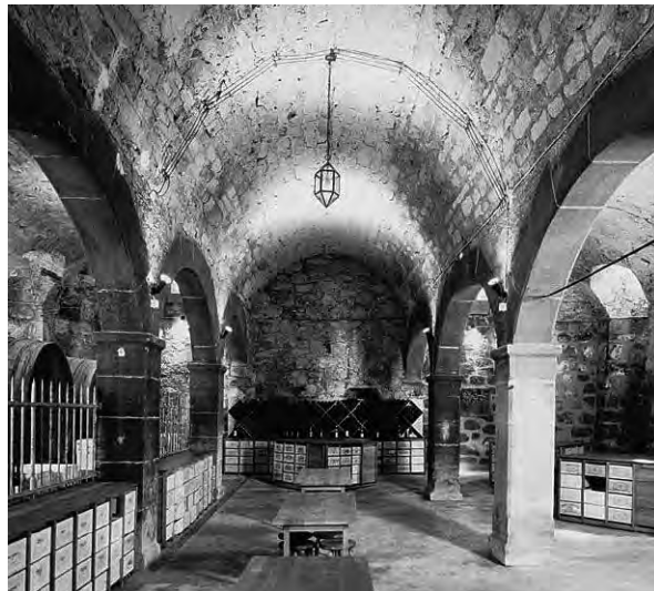
Tonnenüberwölbter Weinkeller Bocken, Horgen, erbaut 1681–1688 (Abb. 45)
