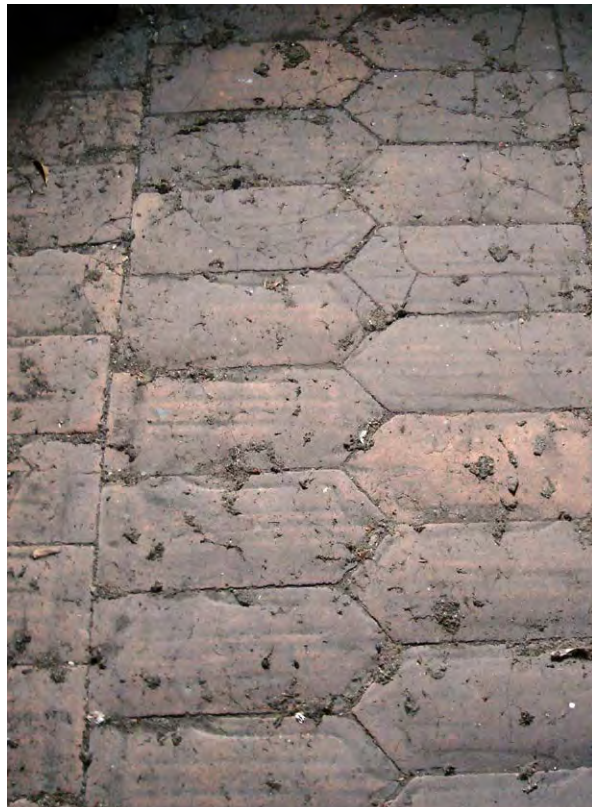
Tonplatten, Dachboden eines herrschaftlichen Wohnhauses, um 1690 (Abb. 85)
