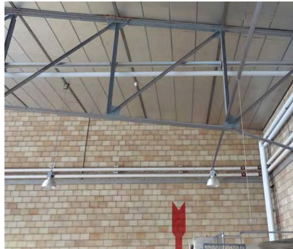
Flugplatz Emmen, Flugzeughalle 1, 1938, bauzeitliche Vormauerung der Betonaussenwand mit Tonisolierplatten zur Vermeidung von Kondensaten (Abb. 50)
