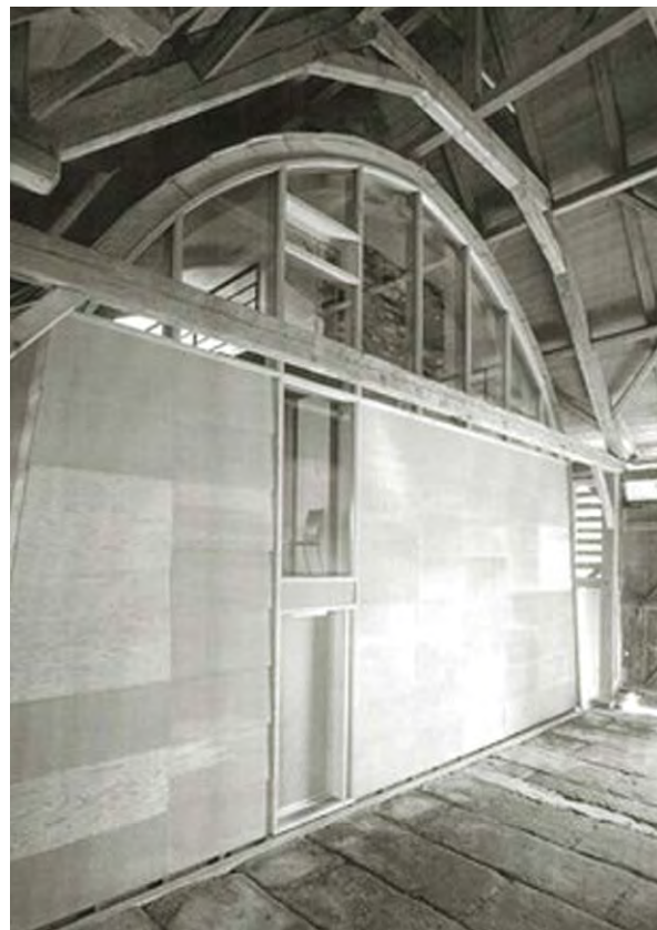
Bauernhaus in Bern. Dachausbau nach dem Konzept «Haus im Haus» (Abb. 91)
