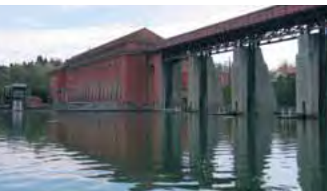
Kraftwerk Eglisau, Rhein
