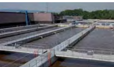
Belüftungsbecken in Abwasserreinigungsanlage
