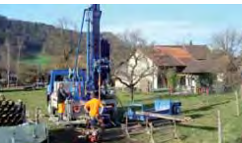
Bohrung zur Grundwassererkundung
