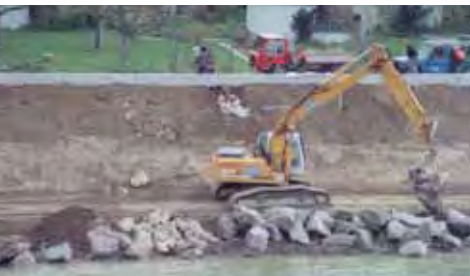
Bau einer Ufersicherung
