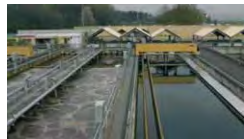
Becken in Abwasserreinigungsanlage
