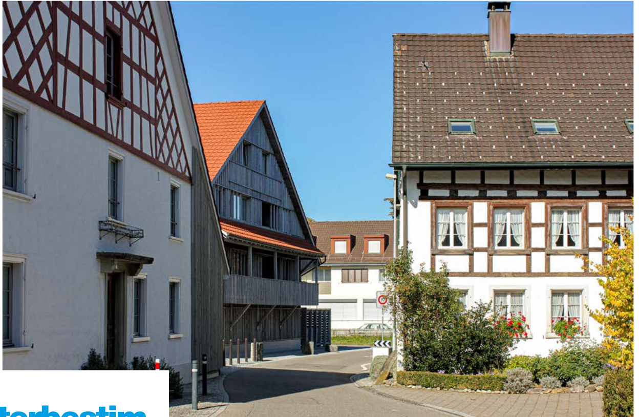
Der Kanton Zürich verfügt über eine Vielzahl von Gemeinden mit historischen Ortskernen. Wiesendangen (im Bild) hat den historischen Bestand mit gut eingepassten Neubauten ergänzt. Quelle: ARE
