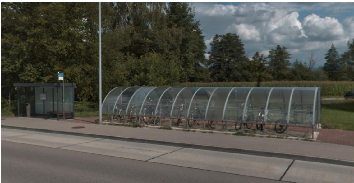
Abb.1 Bike & Ride-Anlage Bushaltestelle Mönchaltorf, Traube (Foto Kanton Zürich, 2021)
