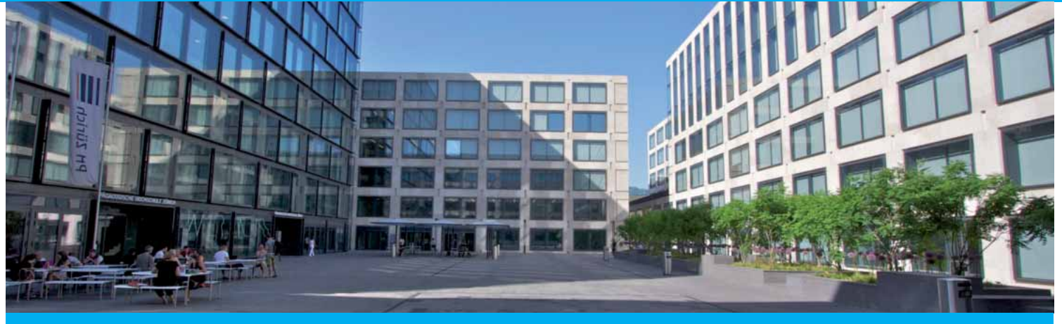
Zürich, Hochschule an der Europaallee
