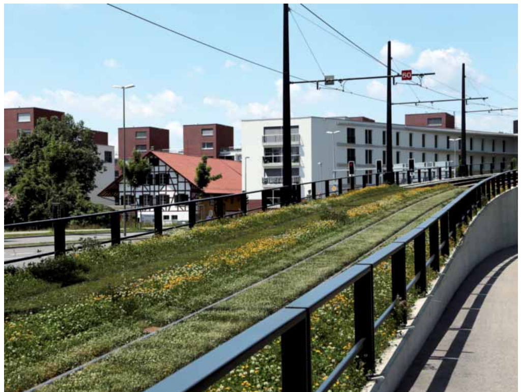
Wallisellen, Geleise der Glattalbahn auf der Höhe des Zwicky Areals
