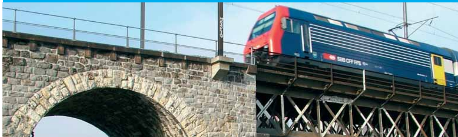
S-Bahn in der Nähe der Hardbrücke
