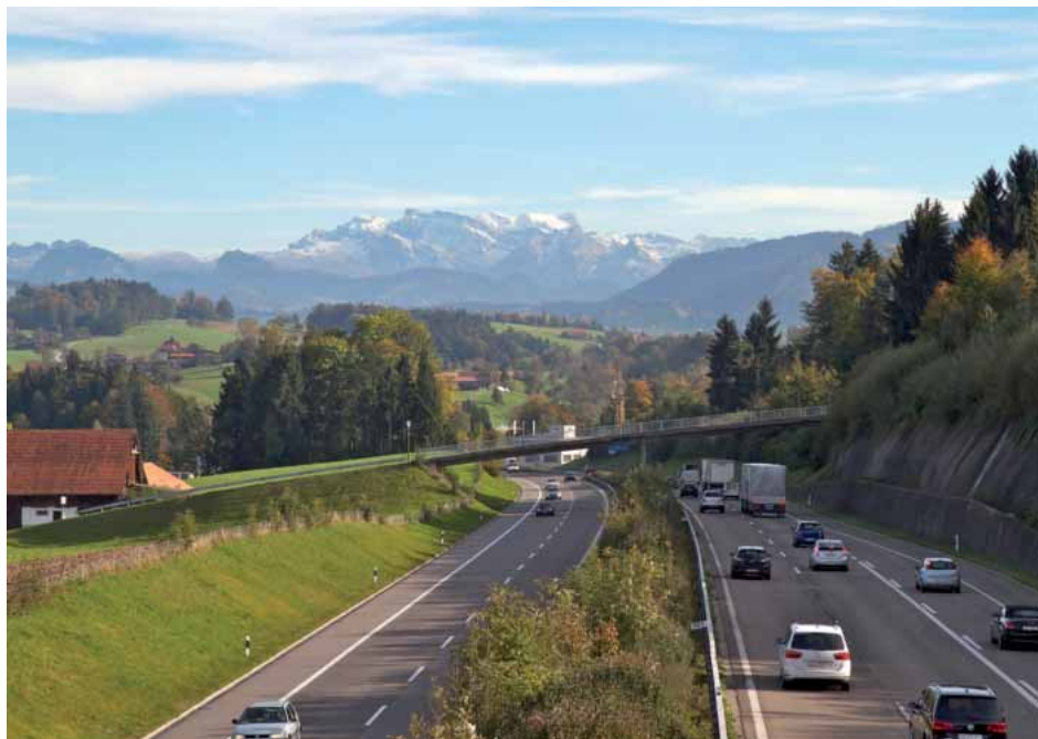
Autobahn A3, Region Zimmerberg, Höhe Horgen
