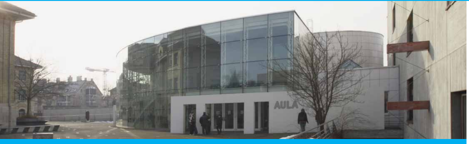
Zürich Oerlikon, Aula der Kantonsschule Zürich Nord
