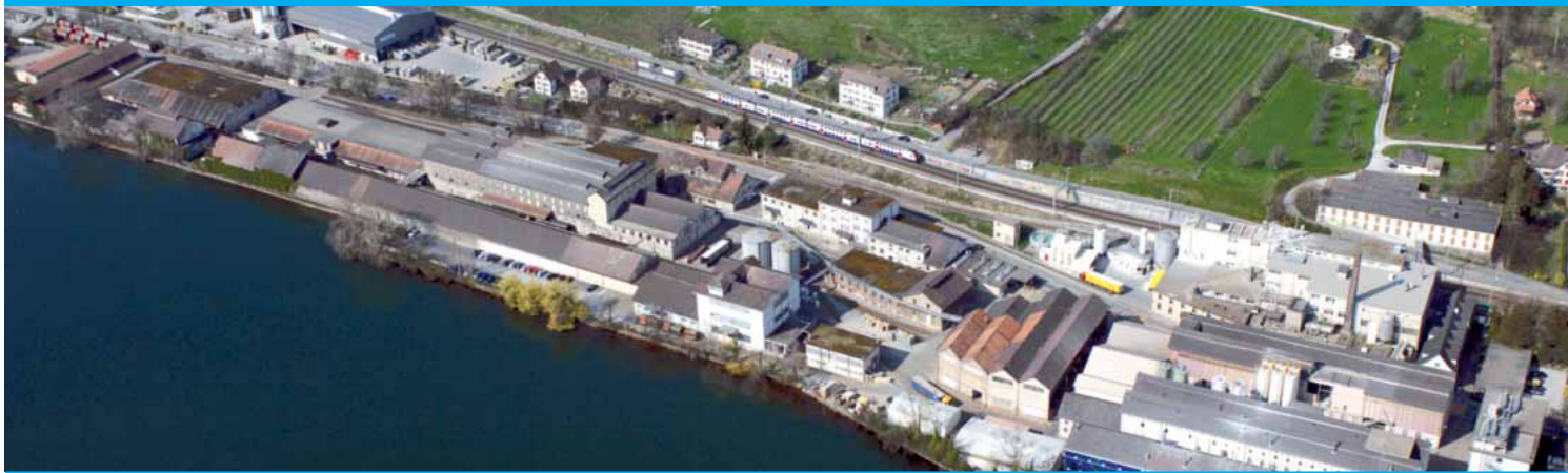
Uetikon am See, Hallenbauten der Chemiefabrik
