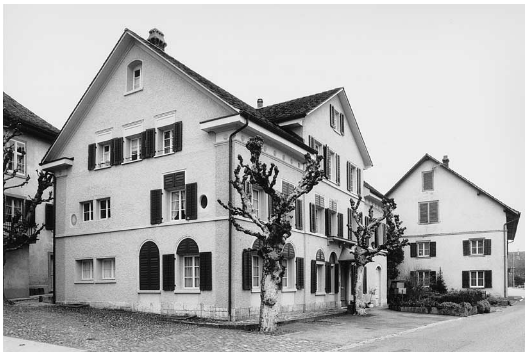
Haus Menzi in Benken, Landstrasse 146, umgebaut 1847 für das Ehepaar Forstmeister Hans Ulrich Meister (1801–1874) und Anna Maria Meister-Vogler (1802–1878), nach der Restaurierung. Zustand 1997. Das mit Bildtapeten ausgestattete Zimmer befand sich hinter dem Doppelfenster im Quergiebel der Strassenfassade.
