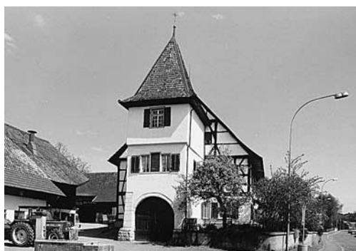
Links: Bauma, Wohnhaus, Arzthaus Vers. Nr. 846, Dorfstrasse 43, nach der Fassadenrenovation 1991/1992.
