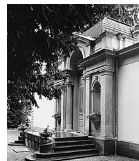
Die Eingangspartie der Orangerie, nach der Renovation. Zustand 1993.
