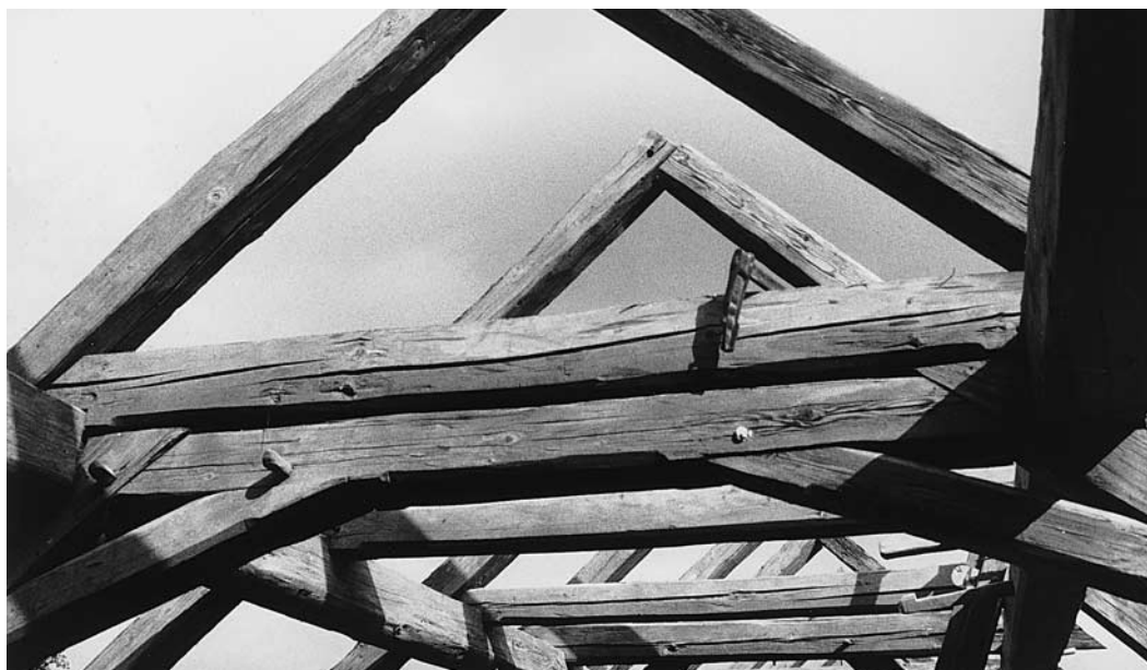
Dachstuhlkonstruktion des Speichers Vers. Nr. 829. Zustand 1992.
