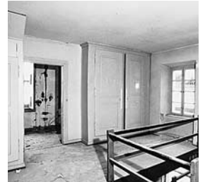
Die hölzerne Treppe im östlichen Gebäudeteil (hier im Obergeschoss), welche aus feuerpolizeilichen und statischen Gründen durch eine Stahl-/Steinkonstruktion ersetzt werden musste. Während der Renovation. Zustand 1992. (Vgl. Bild unten).
