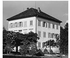
Das um 1780 erstellte und 1841 zum «Neuhof» umgebaute Wohnhaus der Tobelmühle liegt gegenüber der Scheune. Zustand 1970.
