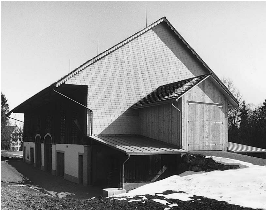
Nordseite (links) und Westseite (rechts) mit Hocheinfahrt nach der Restaurierung. Zustand 1996.
