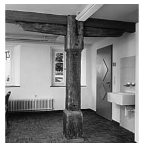
Jochsäule im Untergeschoss. Nach der Renovation. Zustand 1993.
