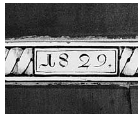
Jahrzahl 1829 (Baujahr des Hauses) am Kachelofen in der südöstlichen Stube des Obergeschosses. Zustand 1994.
