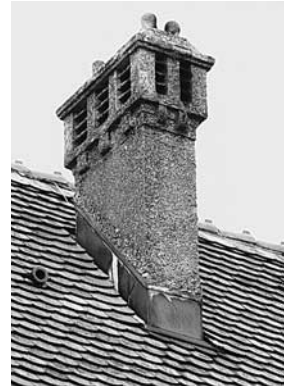
Kamin auf der südlichen Dachfläche. Zustand 1993.
