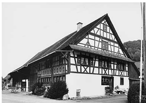
Links: Niederglatt, Wohnhäuser Vers. Nrn. 12/20/22, Kaiserstuhlstrasse 8/12/14, vor dem Abbruch 1991.
