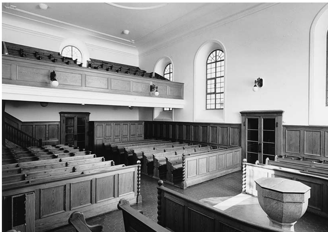
Teilansicht des Innern nach der Renovation. Taufstein, Fenster, Deckenstück sowie Emporen- und hinteres Schiffsgestühl von 1842, übrige Ausstattung von 1916–1917. Zustand 1993.
