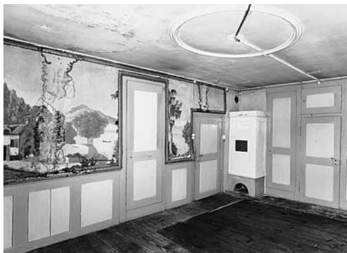
Zwei Ansichten des Dachzimmers im Haus Menzi in Benken vor der Ablösung der Tapeten. Zustand 1985. Im Bild links die Westwand (rechts) und die Ostwand (links). Zustand 1992.
