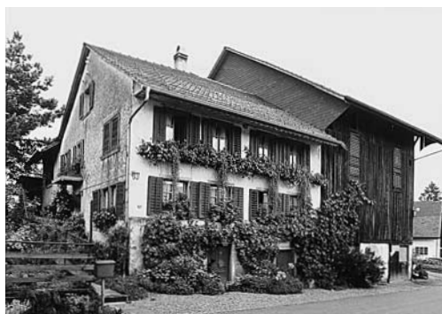
Links: Hombrechtikon, altes Schützenhaus Vers. Nr. 460, Hof Breitlen, nach der Dachsanierung 1991–1992.
