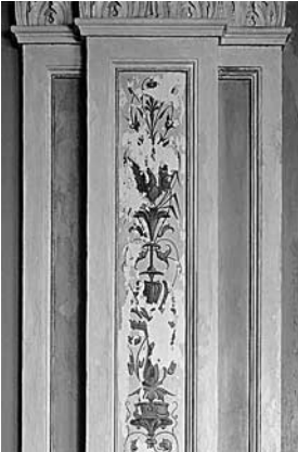
Wandpilaster mit pompejanischen Motiven in der Orangerie, nach der Restaurierung. Zustand 1992. Die fehlenden Teile wurden nicht ergänzt, sondern grundtonfarben retuschiert.
