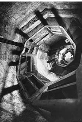
Das Innere des Kirchturms. Zustand 1997.
