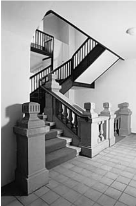
Treppenhausgestaltung 1. Obergeschoss von 1883–1884. Zustand 1992.
