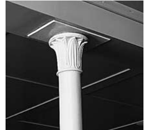
Kapitell der originalen Gusseisensäule im Erdgeschoss-Saal (ehem. Schulzimmer). Zustand 1993.
