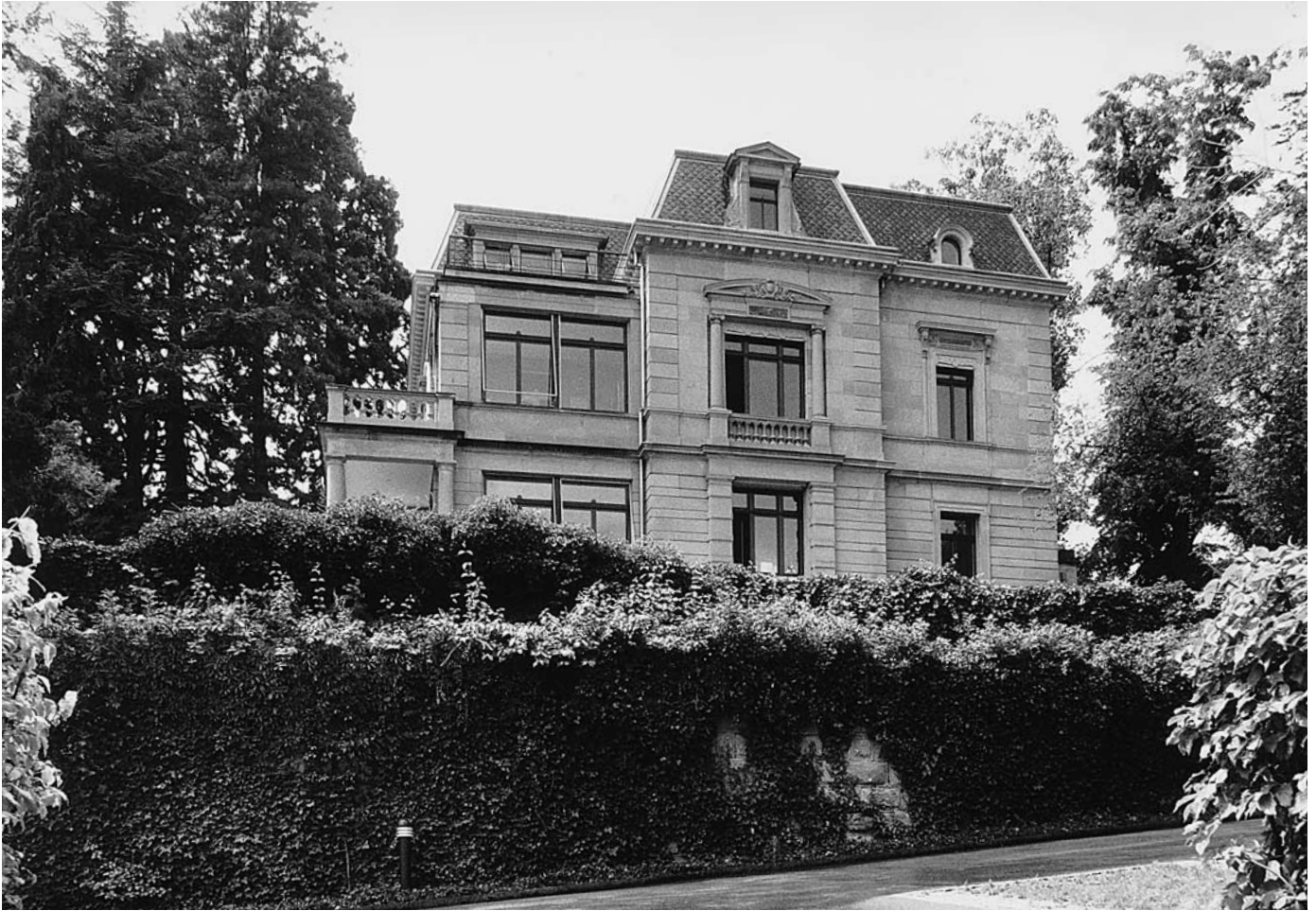
Oben: Ansicht der Villa nach der Renovation. Zustand 1993.
