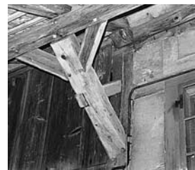
Vordachabstützung an der Westfassade zwischen Wohn- und Tennbereich. Vor der Renovation. Photo Isabell Hermann 1989.
