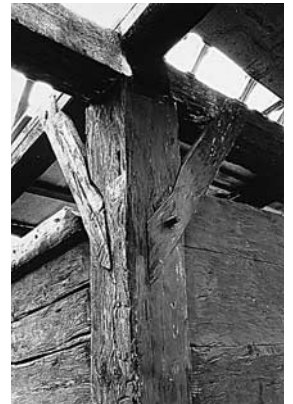
Eckpartie des Nordwestzimmers im 2. Obergeschoss des Kernbaues, vom Mittelgang aus gesehen. Zustand während des Umbaus, September 1988.
