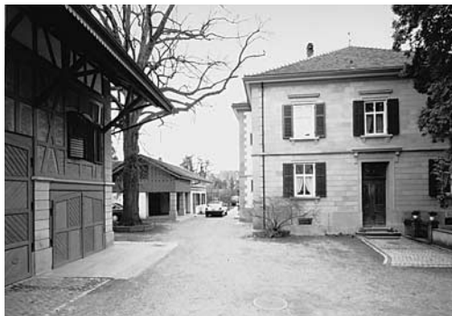
Ansichten des Hof- und des Gartenraums mit Villa, Waschhaus und Stallge- bäude nach der Restaura- tion. Zustand 1992.
