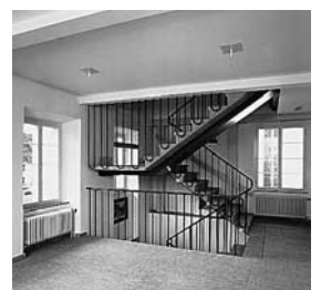
Das Treppenhaus im östlichen Gebäudeteil (hier im Obergeschoss) mit neuer Treppe in Stahl-/Steinkonstruktion, die vom Untergeschoss bis ins neu ausgebaute Dachgeschoss führt. Nach der Renovation. Zustand 1993. (Vgl. Bild oben).
