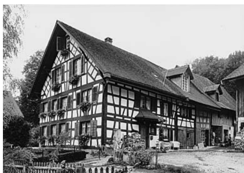
Links: Oberrieden, ehem. Bauernwohnhaus Vers. Nr. 686, Bleierstrasse 3, nach der Renovation 1991–1992.
