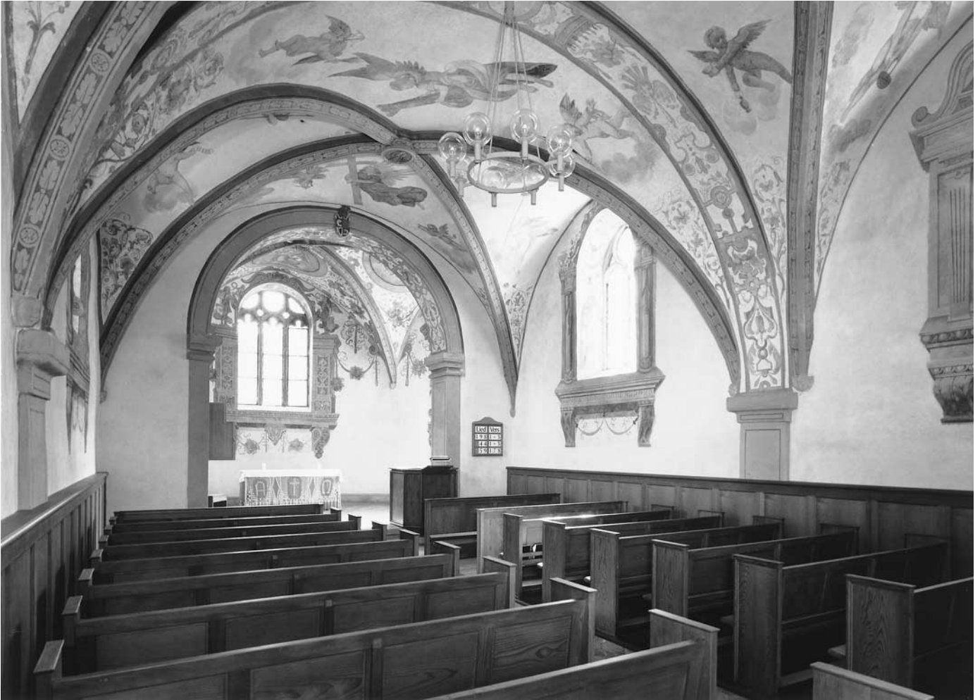
Oben: Teilansicht der Spitzkirche gegen den Chor, nach der Restaurierung. Zustand 1992. Die um 1612 entstandene Ausmalung wurde 1930–1931 freigelegt.
