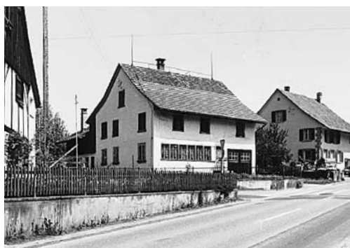
Links: Uster, Flarzhäuser Vers. Nrn. 2477–2480, Kirchuster, Zimikerstrasse 3–5, vor dem Abbruch 1994.
