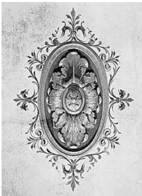
Gemaltes Mittelmedaillon der Decke im Korridor des Erdgeschosses. Zustand 1993.
