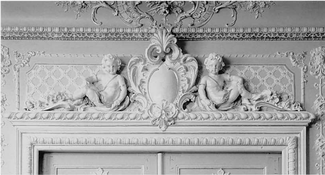
Putto-Paar und Kartusche über der Türe zwischen den Räumen 2.6 und 2.7 in der Beletage (2. Obergeschoss). Zustand 1993. Die Stuckierungen von 1860 im «Warteck» gehören zu den frühesten Neurokoko-Ausstattungen im Kanton Zürich. Die Entwürfe bzw. Modelle stammten wahrscheinlich aus Paris. Die Ausführung besorgte wohl Stukkateur Georg Hörbst (1822–1876) in Zürich, vgl. Anm. 5.
