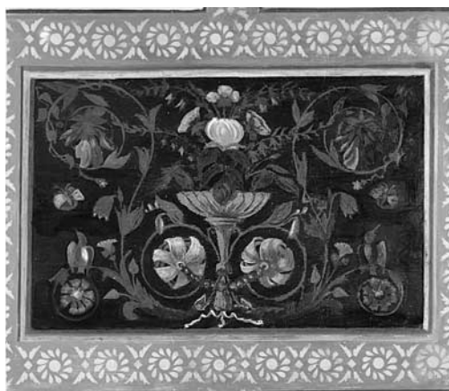
Detail der Deckenmalerei in der Halle (Raum 0.2) im Erdgeschoss, vor und nach der Restaurierung. Zustand 1984 und 1993.
