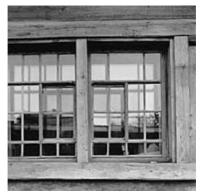
Das erhaltene Doppelfenster an der rückseitigen Bohlenständerfassade wurde zum Kastenfenster ergänzt. Zustand 1992. (Vgl. Bild oben).
