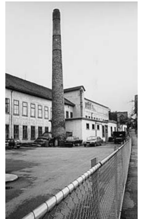
Nordfassade der Fabrikanlage mit Maschinen- und Dampfkesselhaus sowie Hochkamin. Zustand 1980.
