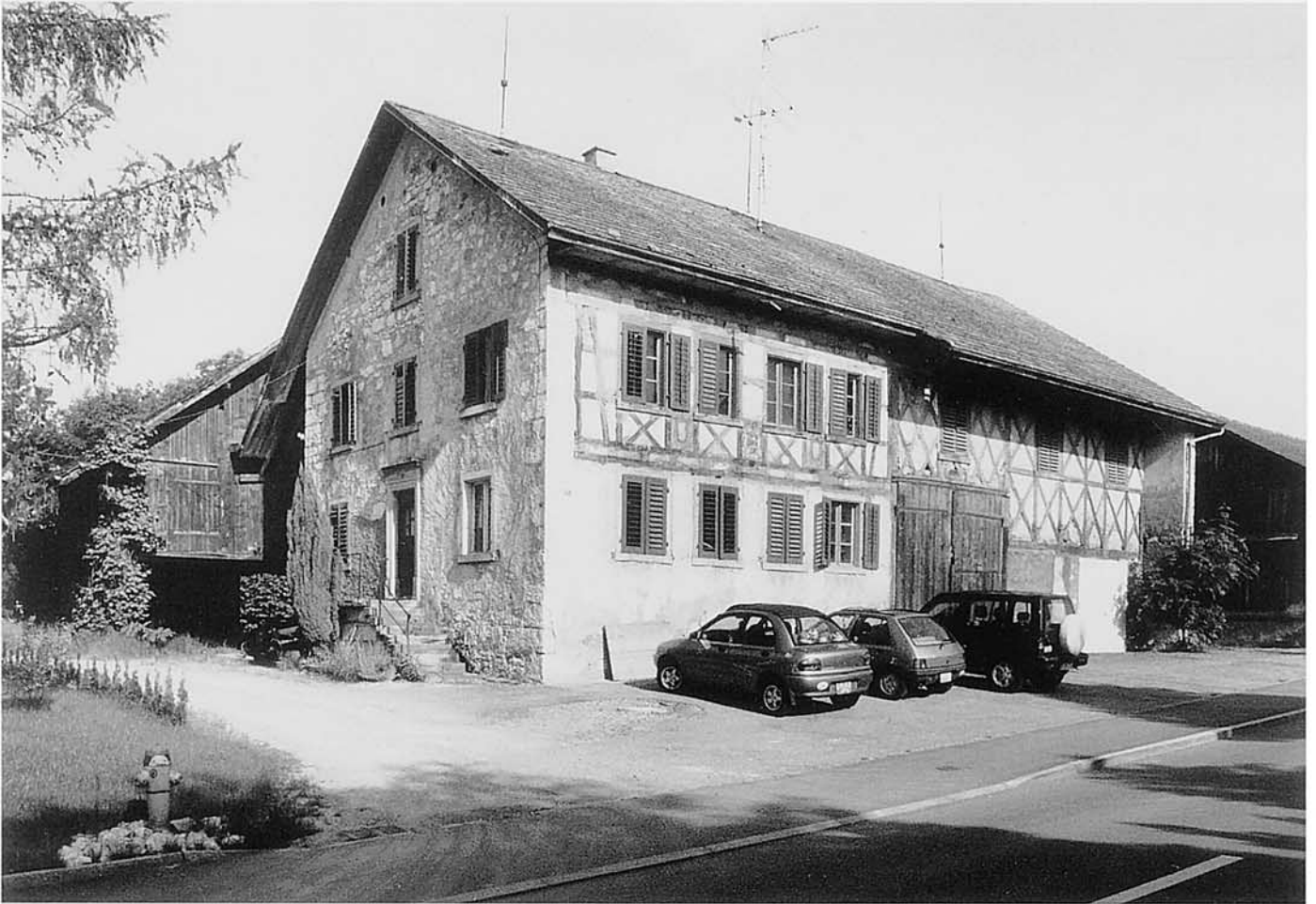
Oben: Ansicht von Südosten. Zustand 1994. Im Hintergrund links der Schopf, welcher 1936 mit dem Wohnhaus durch die Überdachung des Zwischenraums verbunden wurde.
