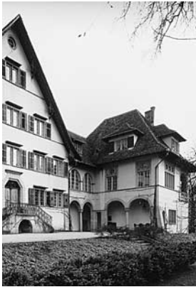
Die Nordwestecke des Nebentraktes von 1911–1913 mit der offenen Sommerloggia. Zustand 1980. (Zustand nach der Renovation vgl. Bild unten).
