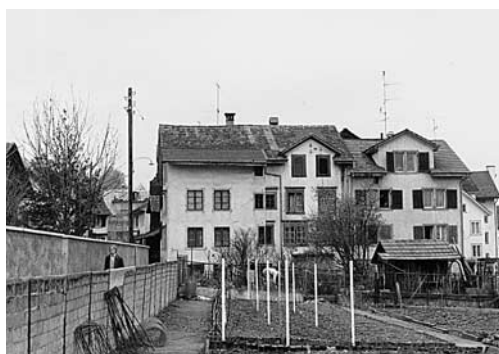
Links: Rheinau, Gasthof «Salmen» Vers. Nr. 43, Schwaderloch, Zollstrasse 18, nach der Aussenrenovation 1990–1991.
