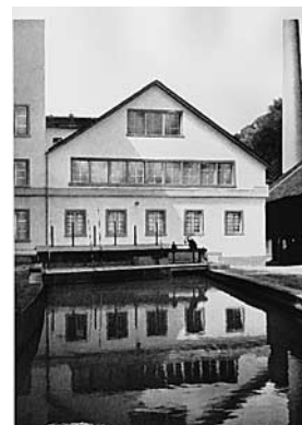
Das Vorwerk- und Turbinengebäude Vers. Nr. 30, im Vordergrund der Oberwasserkanal mit der Rechenanlage. Zustand um 1950. Bild aus Dok. 15.
