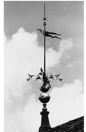
Der Blitzableiter wurde restauiert und nach Befund mehrfarbig gefasst. Vor der Restaurierung. Zustand 1989.
