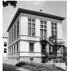
Südostfassade des Gemeindehauses mit neuer Aussentreppe. Zustand 1998. Vgl. Seiten 308–313.
