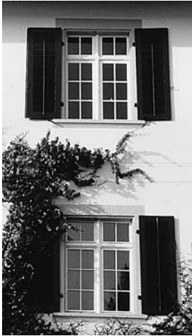
Detail der Seefassade. Ursprüngliches Fenster im 2. Obergeschoss sowie nach diesem Vorbild neu-geschaffenes Fenster von 1991 darunter im 1. Ober-geschoss. Zustand 1991.
