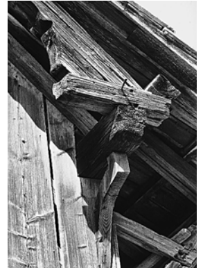
Flugsparrendreieck an der Nordostecke der Stallscheune, errichtet um 1736, vor der Rekonstruktion. Zustand 1992.
