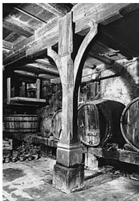
Kellerstud, dendrodatiert 1683/1684 mit Datum 1814 am Sockel. Zustand 1960.
