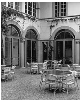
Ehem. Sommerloggia mit verglasten Flügeltüren. Durch den Abbruch der Trennwand hinter den Arkaden entstand ein Speisesaal für das Schulungszentrum. Zustand 1994. (Vgl. Bild oben).
