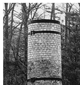
Oberteil des 1891 erstellten Hochkamins mit der 1992 neu aufgemauerten, helleren obersten Partie.
