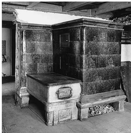
Rechts: Teilansicht der Bohlenbalkendecke im oberen Hausteil, um 1535. Zustand 1981.
