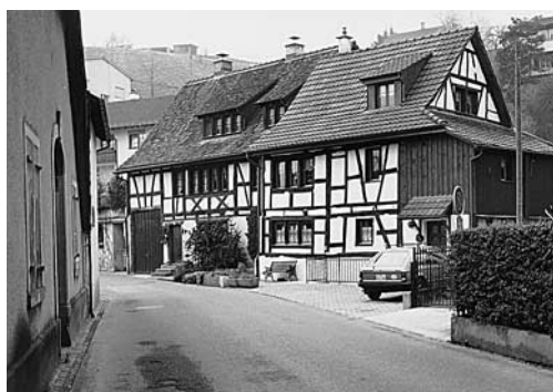
Links: Kyburg, Reihenhaus Vers. Nr. 335, Im Chratz, nach der Aussenrenovation 1993.
