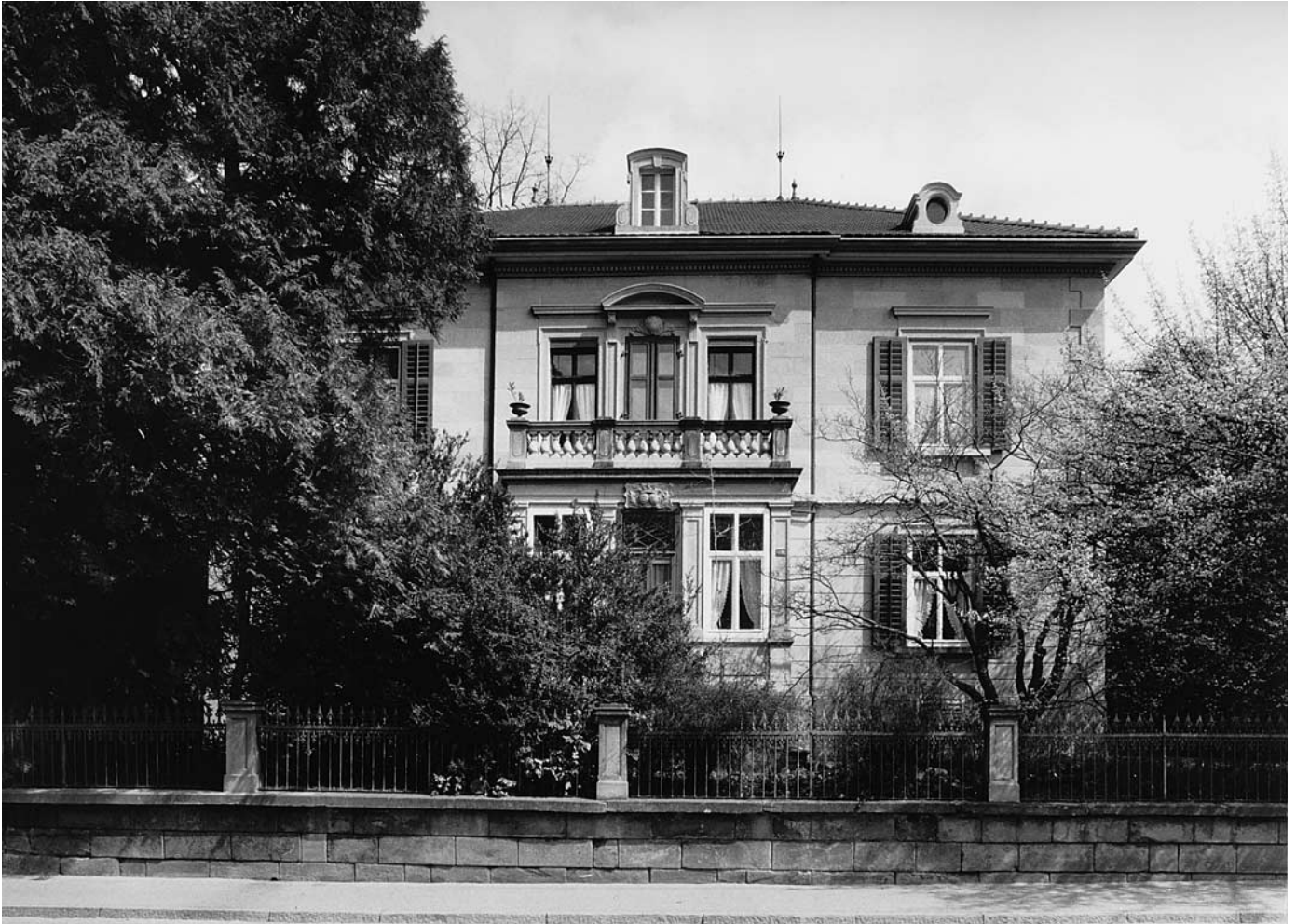
Oben: Strassenfassade der restaurierten Villa. Zustand 1996.
