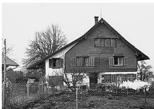
Links: Wald, ehem. Kleinbauernhaus Vers. Nr. 298, Beizi, nach der Fassaden- und Fenstersanierung 1991.
