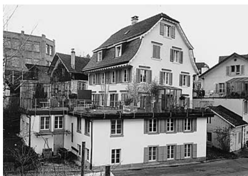
Links: Horgen, sog. Agentenhaus Vers. Nr. 334, Seestrasse 175, nach der Aussenrenovation 1990–1991.
