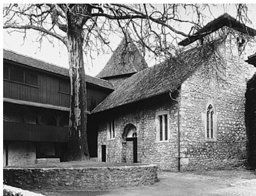
Die Schlosskapelle in der Nordwestecke der Burganlage. Zustand 1891 (links, aus Dok. 8, 3. Auflage) und 1928 (rechts). Wohl um 1900 wurde der klassizistische, hölzerne Ökonomietrakt teilweise abgebrochen und die Ostseite der Kapelle freigelegt, was zu Feuchtigkeitsschäden im Innern führte. 1927 wurde der Aussenverputz des Gebäudes entfernt.
