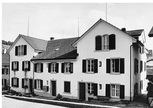
Links: Weisslingen, Wohnhaus mit ehem. Fabriktrakt Vers. Nr. 595, Chilegass 5, vor dem Abbruch 1992. Im Hintergrund die reformierte Kirche.
