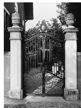
Schmiedeeisernes Tor an der Südostecke. Auf dem Medaillon die Initialen des Bauherrn E(rnst) G(öhner). Zustand 1926. Die beiden Tore am «Goldbacherhof» befanden sich ursprünglich in der Baugruppe Mies, Stäfa, und wurden, wie die Portale am «Zieglerhof», Männedorf, vgl. S. 206, in den 1920er Jahren verkauft. (Dok. 34)
