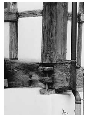
Schwellenschloss an der Südostfassade des Wohnhauses nach der Renovation. Zustand 1994.
