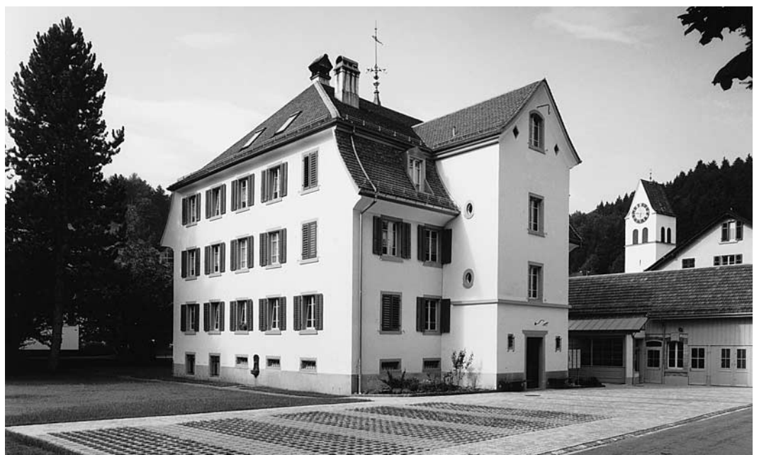
Rechts: Ost- sowie Nordfassade (Rückfassade). Im Risalit befinden sich Trep-podeste und die Abortanlagen. Rechts das ebenfalls renovierte Nebengebäude. Zustand 1994.
