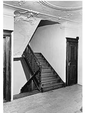
Treppenhaus und Korridor im 1. Obergeschoss. Zustand 1971.
