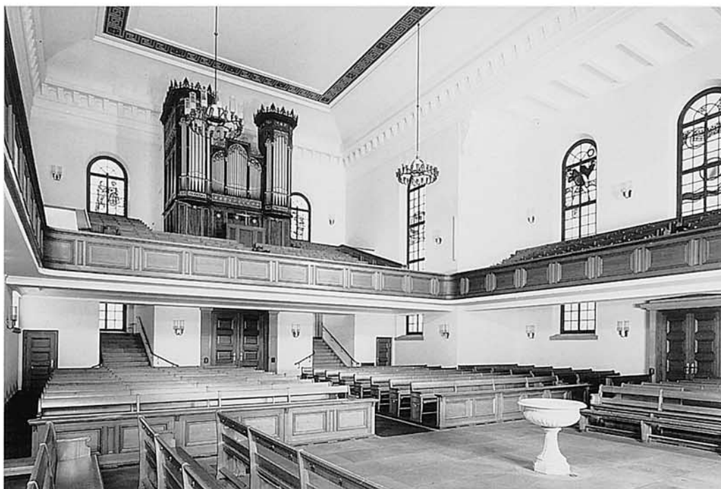
Ansicht der renovierten Kirche. Zustand 1998. Auf der Rückempore die wieder eingebaute, restaurierte Orgel von 1864–1865.
