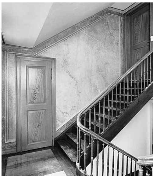
Links: Treppenhaus mit Wandmarmorierung zwischen 2. Obergeschoss und Dachgeschoss. Zustand 1993.
