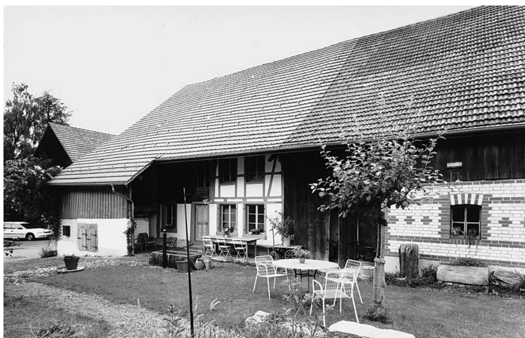
Nordostseite nach der Renovation. Zustand 1997. Ganz links der ehemalige Schweinestallanbau von 1835, ganz rechts der ehemalige Stallteil um 1900.
