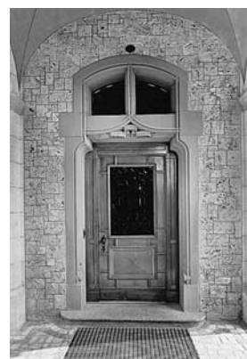
Haupteingang, am Spruchband bezeichnet «Rosenmatt 1899». Sandstein-Türgewände, Tuffsteinwand. Zustand 1990.
