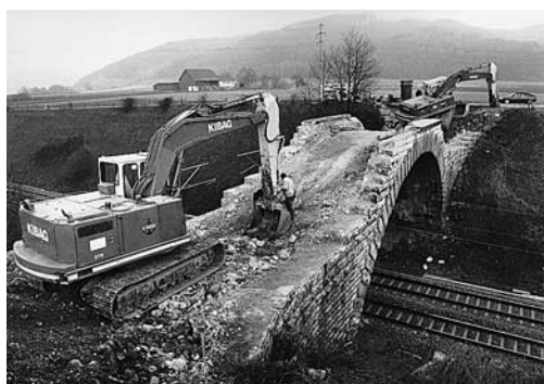
Links: Die Brücke zu Beginn der Abbrucharbeiten Anfang Dezember 1993.
