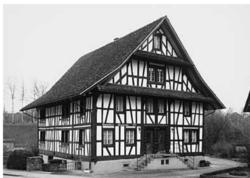
Links: Marthalen, altes Schützenhaus Vers. Nr. 266, Lindenhof, nach der Renovation 1991.
