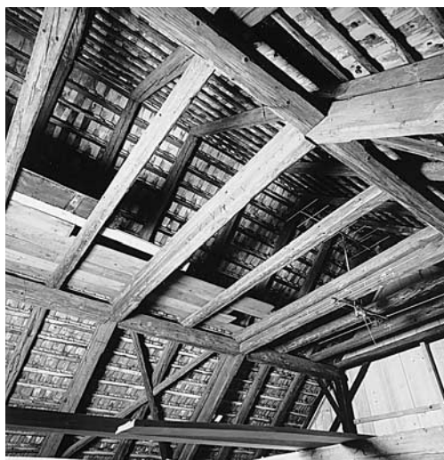
Links: Neue Ostwand im «Treppenhaus» des 1. und 2. Obergeschosses (vgl. Bilder linke Seite).
