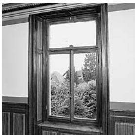
Fenster im Südostzimmer des 1. Obergeschosses. Zustand 1993. Ursprünglicher Zustand, Rahmen und Täfer maseriert.
