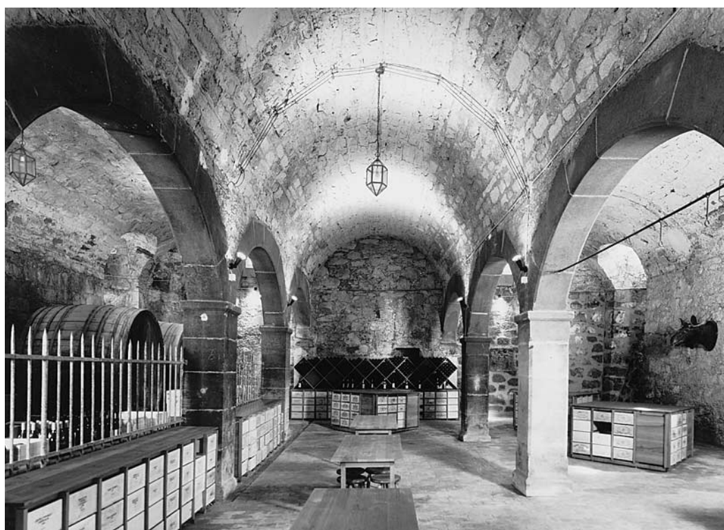
Der grosse Weinkeller (Raum Nr. –1.1) blieb unverändert und dient der alten Aufgabe. Zustand 1994.
