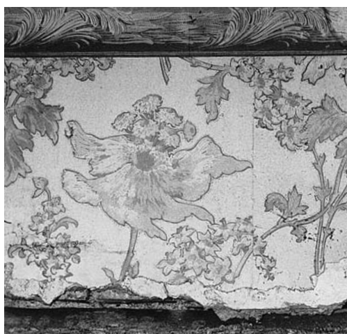
Links: Eckpartie der um 1875 geschaffenen Deckenmalerei im mittleren saalartigen Balkonzimmer im 1. Obergeschoss. Nach der Restaurierung. Zustand 1993.
