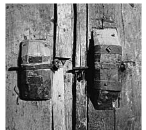
Hölzerne Schloss-Kästen innen an der Tür im Obergeschoss des Speichers. Zustand 1997.
