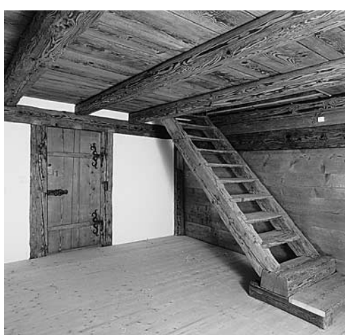
Links: Türrahmen mit Kielbogen und Bohlenwand in einer ehemaligen Kammer im 1. Obergeschoss. Zustand 1992.
