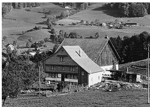
Links: Wald, Bauernhaus Vers. Nrn. 55/56, Hirschacher/Hüebli, nach der Sanierung der Westfassade 1992–1993.
