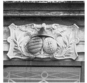
Allianzwappen über der Gartentüre des Mittelsalons im Erdgeschoss. Zustand 1987. Die Bedeutung der Wappen – es sind nicht jene des Bauherrn und seiner Frau – konnte noch nicht geklärt werden.
