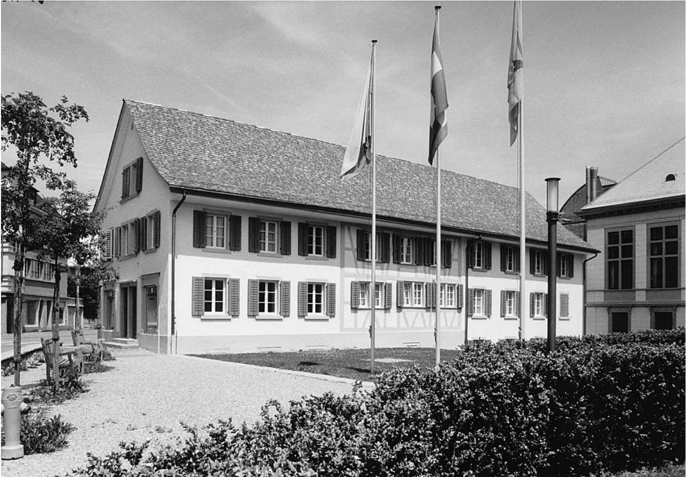
Oben: Der «Blumenhof» nach der Restaurierung. Zustand 1998. Links (mit Ladeneinbau von 1897) und Mitte (mit Fachwerk) die ältesten Hausteile; rechts der Anbau von 1848. Ganz rechts das 1897–1898 errichtete Gemeindehaus.
