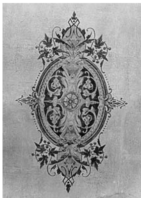
Freigelegte Mittelrosette an der Decke im Erdgeschoss-Korridor nach der Restaurierung. Zustand 1994.
