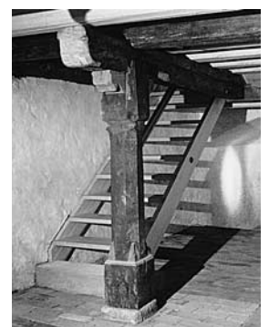
Holzpfiler im Kellergeschoss nach der Renovation. Zustand 1994.
