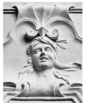
Detail der Deckenstukkatur im Korridor des 2. Obergeschosses. Zustand 1982.
