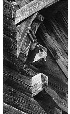
Pfettenkonsole an der Südostfassade, mit schräg laufenden Doppelwülsten, einem volkstümlichen Dekorationselement des mittelalterlichen Holzbaues. Zustand 1981.
