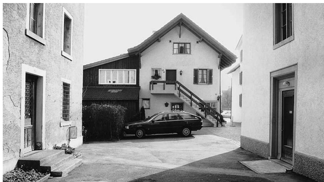
Die Eingangsportale von Bezirks- und Gerichtsgebäude (rechts) und Gefängnis (links) liegen einander gegenüber. Zustand 1996.
