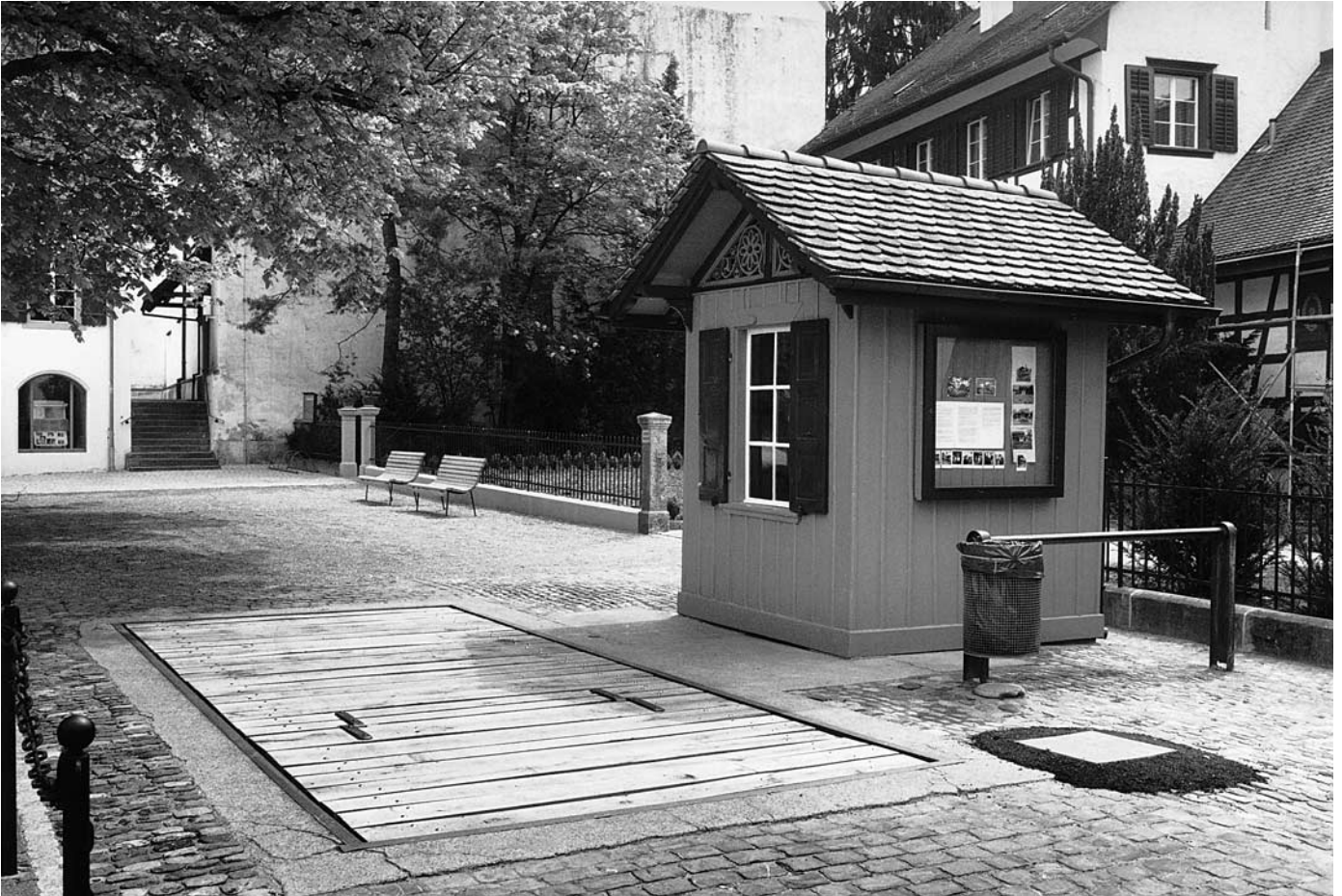
Oben: Waaghäuschen und Brückenwaage nach der Renovation und Instandstellung. Zustand 1995.
