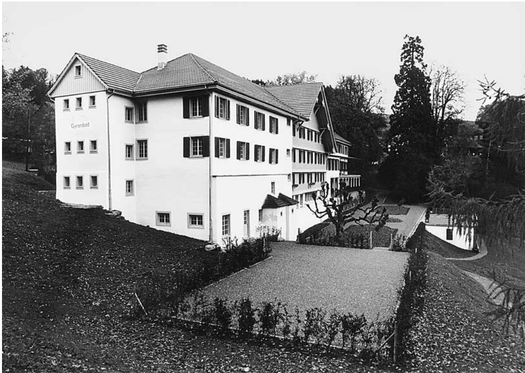
Gesamtansicht nach der Restaurierung. Zustand 1992. Im Vordergrund der 1826 ff. erbaute Westtrakt. Vor der Südwestecke (im Bild vorne) befand sich das 1977 abgebrochene Badehaus, vgl. Bild unten.
