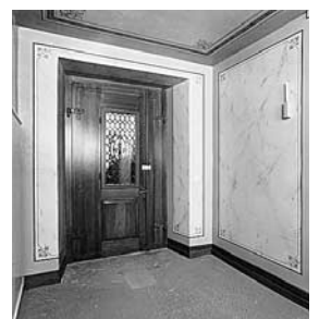
Korridor im Erdgeschoss nach der Renovation. Zustand 1994. Nachdem grosse Teile der Wandoberflächen beschädigt worden waren, so dass auf eine Freilegung verzichtet werden musste, wurde die Marmorierung der Wände – ausser einem freigelegten Referenzfeld – neu angebracht.
