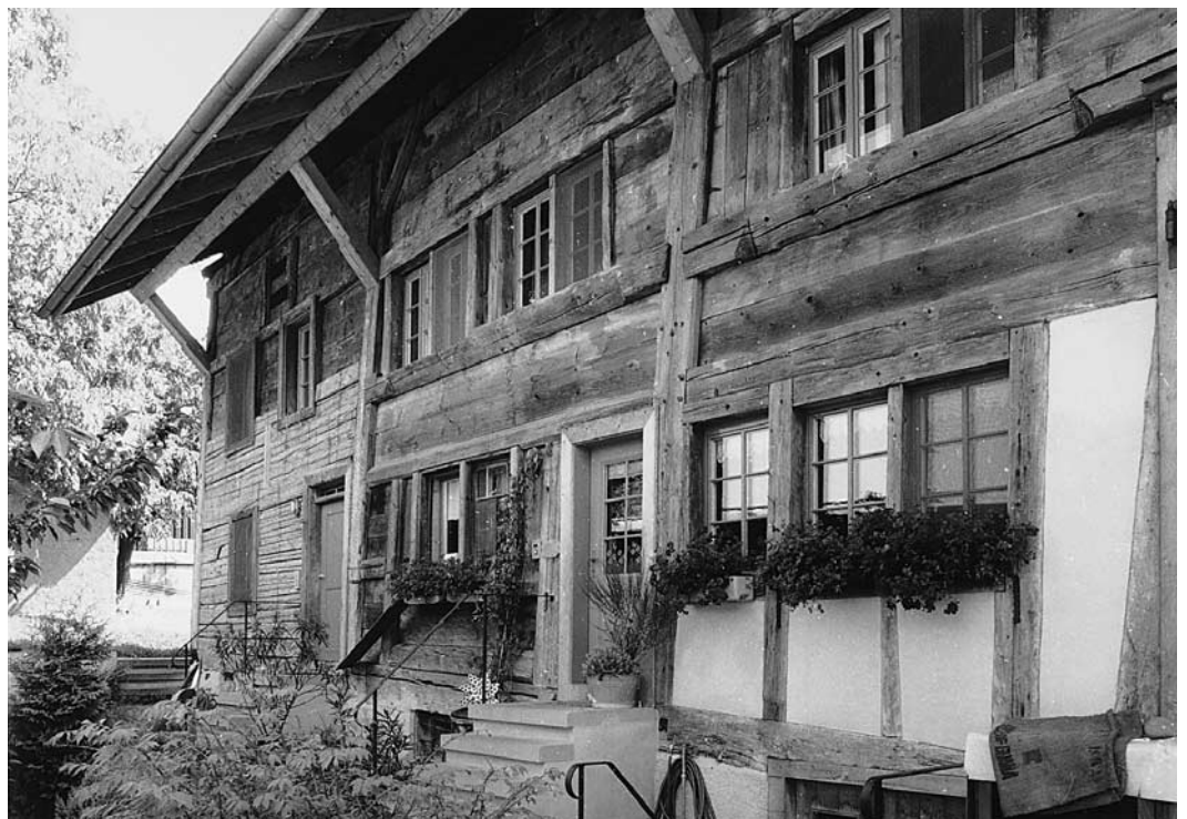
Rechts: Die rückseitige Bohlenständerfassade war vor der Renovation durch ein Vordach vor allem im Bereich des Obergeschosses und des Kniestocks vor Witterungseinflüssen geschützt. Zustand 1996.
