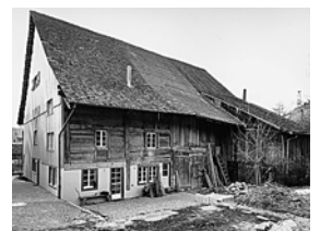
Die Nordfassade in Bohlenkonstruktion nach der Renovation. Zustand 1992.
