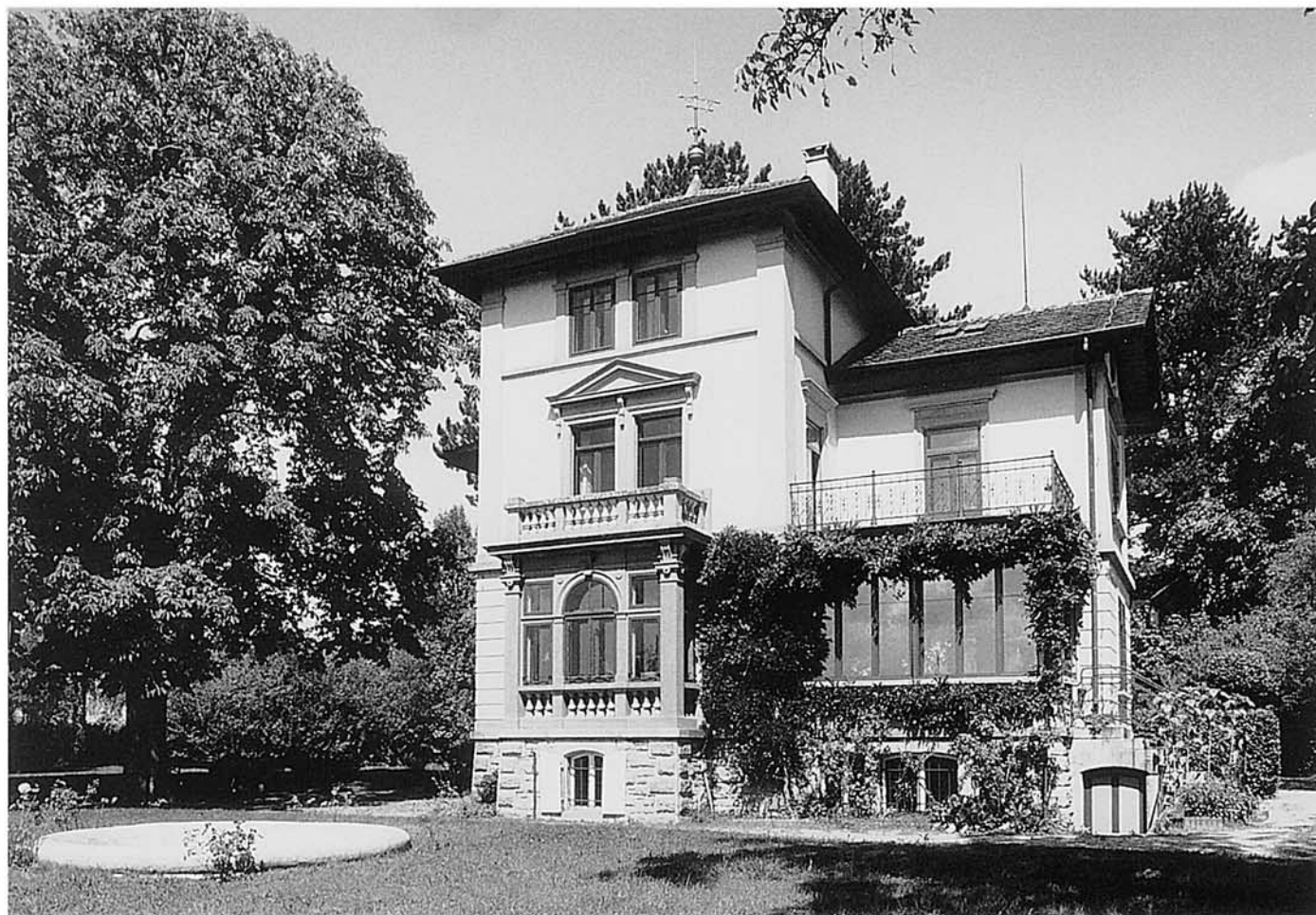
Oben: Ansicht von Südosten. Zustand 1998.
