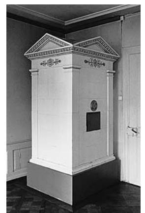
Einer der erhaltenen klassischen Kachelöfen in den Häusern Nrn. 7 und 9. Zustand 1989. Photo BAZ.
