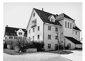
Der «Zieglerhof» 1972 (oben) und 1998 (unten, im Hintergrund). Verlust der landschaftlich adäquaten Umgebung, Bedrängung durch voluminöse Neubauten in fragwürdiger formaler «Angleichung».
