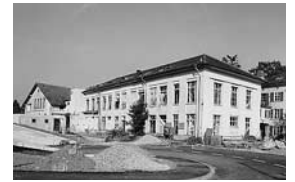
Das 1912–1914 erstellte zweite Seidenfabrikgebäude, links die 1888–1889 erstellte Bleicherei. Zustand 1985. Die beiden von der KDK 1985 zur Erhaltung empfohlenen Bauten wurden abgebrochen. (Vgl. Text links und folgende Seite).
