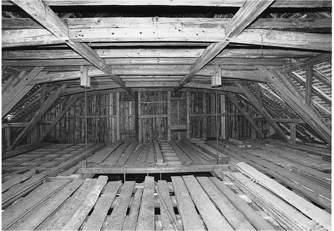
Ansicht des Dachgeschosses vor der Renovation. Zustand 1995.
