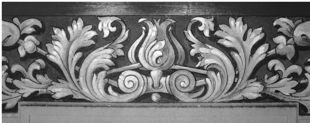
Detail des Dachfrieses an der Westfassade nach der Restaurierung. Zustand 1994.
