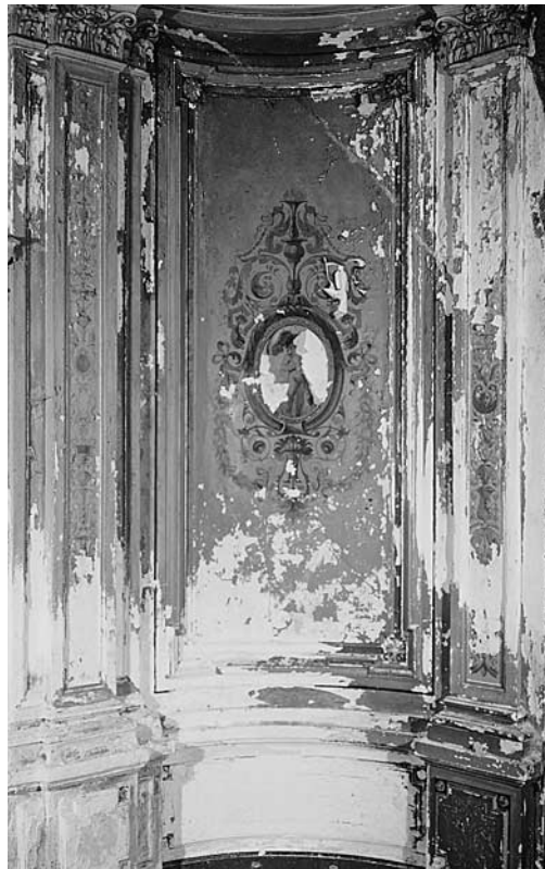
Links: Die teilweise zerstörte südliche Ecke des Orangerie-Innenraums, vor der Restaurierung. Zustand 1989. Medaillon mit figürlicher Jahreszeitendarstellung und Pilaster mit pompejanischen Ornamenten.
