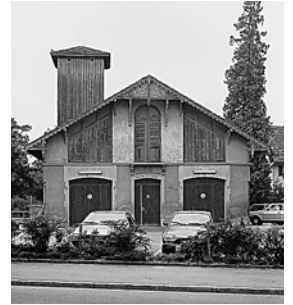
Südostfassade vor der Restaurierung. Zustand 1988. Photo J. und I. Kurtz, Üerikon.
