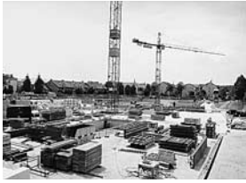
Das Areal der Werksiedlung nach dem Totalabbruch. Zustand 1994.
