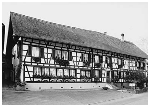
Links: Waltalingen, altes Gemeindehaus Vers. Nr. 69, Stammerstrasse/Guntalingerstrasse, nach der Renovation 1991–1993.
