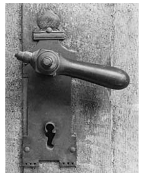
Detail vom Eingangsportal. Zustand 1992.
