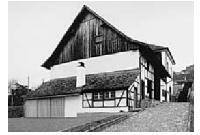
Scheune und Trotte nach der Renovation. Zustand 1998.
