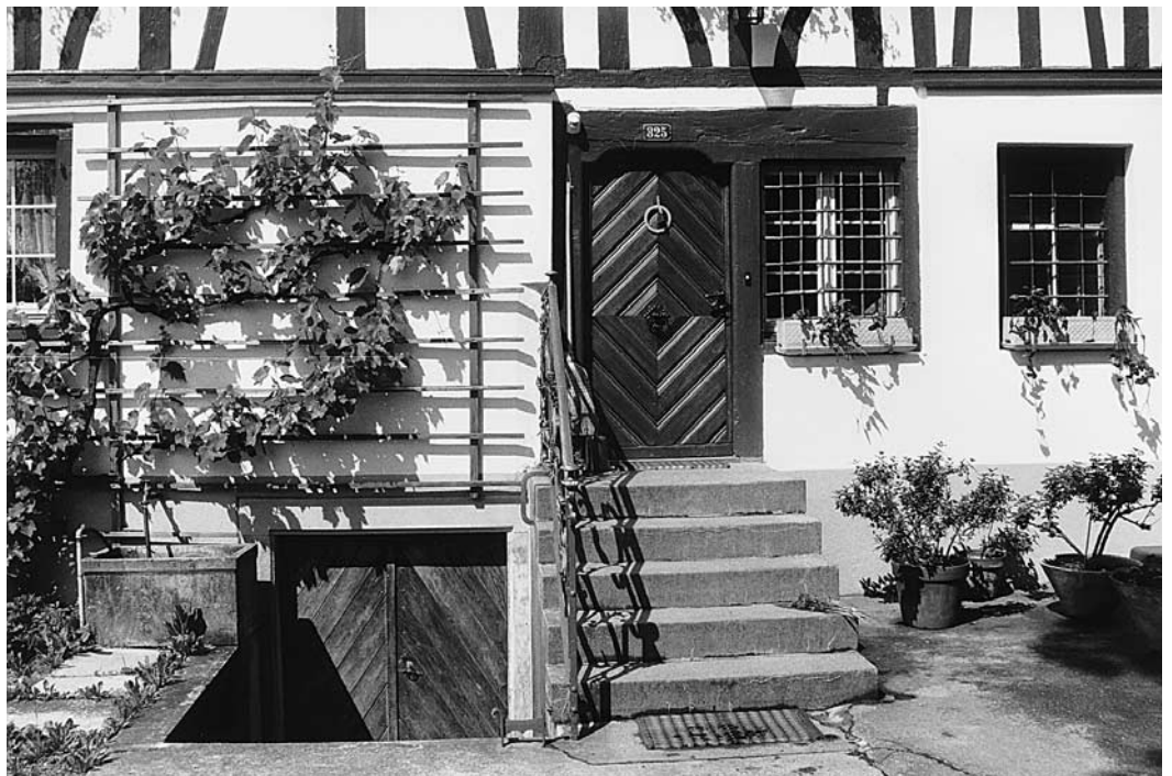
Rechts: Eingangspartie am Haus Vers. Nr. 826 mit rekonstruiertem Türblatt. Zustand 1993.
