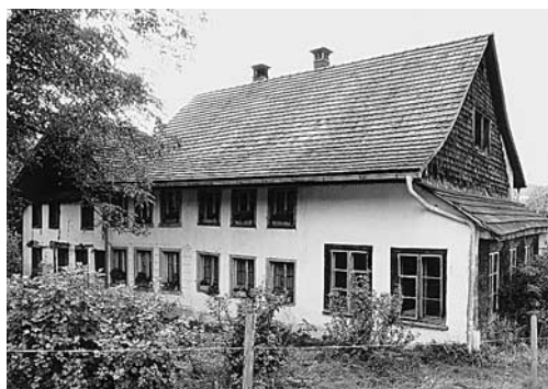
Links: Fehraltorf, Gemeindehaus, ehem. Pfarrhaus Vers. Nr. 124, Kempptalstrasse 54, nach der Fassadenrenovation 1991.
