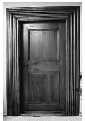
Die barocke Nussbaumtüre zwischen den Räumen 2.13 und 2.14 im 1. Obergeschoss ist wohl ein Zeuge des 1748 vorgenommenen Umbaus. Zustand 1989.
