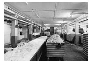
Hauptgebäude, Erdgeschoss. Spinnsaal mit Steinstützenkonstruktion von 1827–1829. Zustand 1983.
