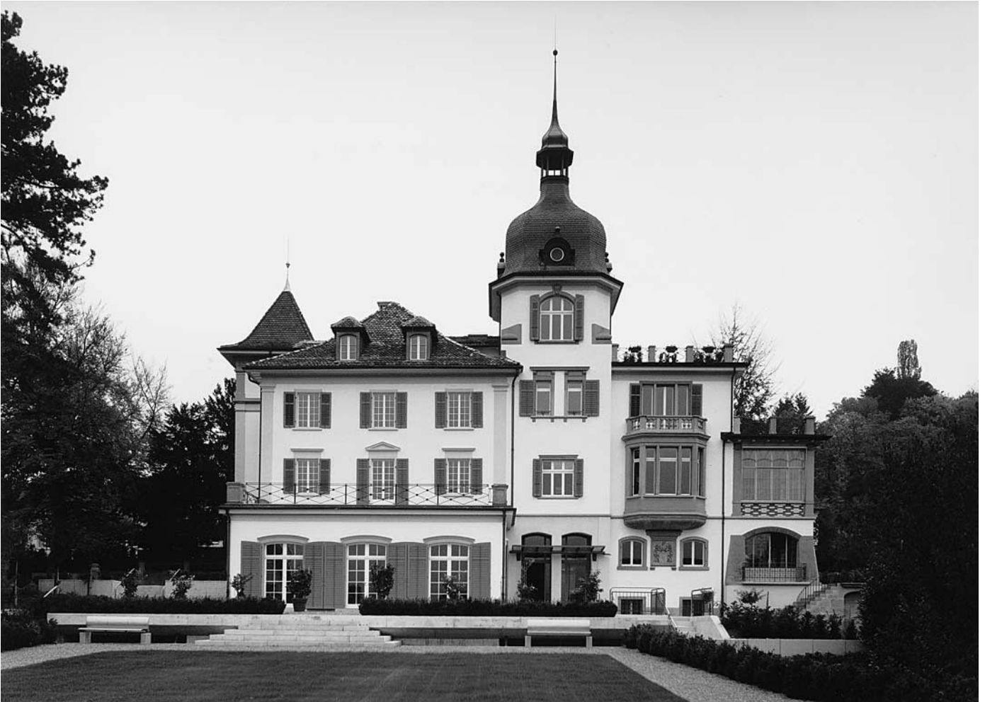
Oben: Zustand 1994, nach der Renovation. Der neue Haupteingang im Sockelgeschoss des Turmtrakts und die Terrasse vor dem Gartensaaltrakt mit Trep- penabgang zum Rasenpar- terre im Vordergrund haben die Seefassade zur Hauptfassade gemacht.
