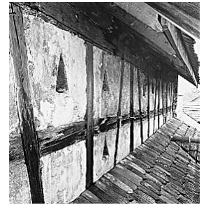
Fassadendetail mit dreieckigen Lüftungsöffnungen an der Südwestseite im 2. Obergeschoss. Zustand 1991.
