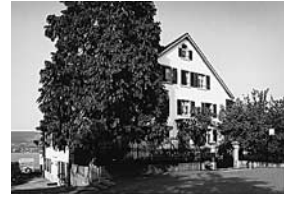
Das 1850 erstellte Bauernwohnhaus «Grünau» nach der Renovation. Zustand 1998.
