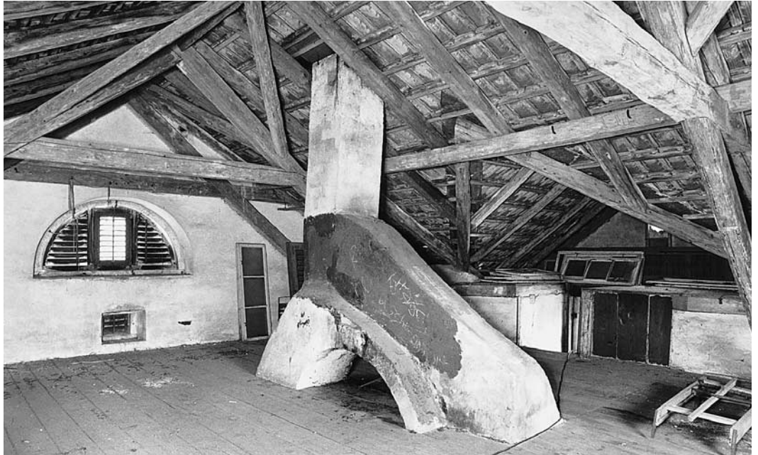
Dachgeschoss, Blick gegen den Südwestgiebel. Zustand 1992.
