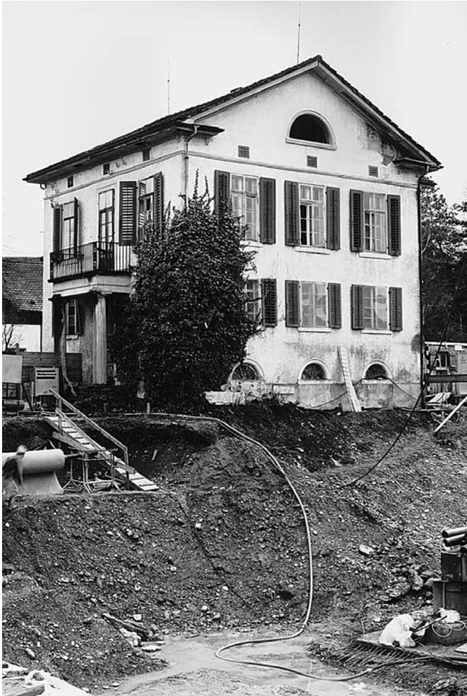
Oben: Das 1837–1838 erbaute klassizistische sog. «Bertahaus» während der Bauarbeiten an der angrenzenden Tiefgarage 1992; rechts nach dem Einsturz der Ostecke am 25. Mai 1992.
