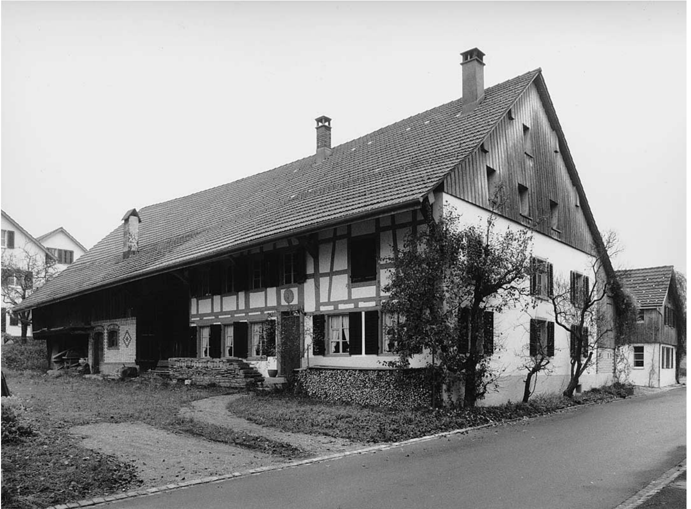
Oben: Westfassade mit Hauseingang und strassen- seitige Südfassade, nach der Renovation. Zustand 1996.
