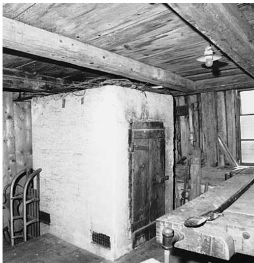
Dachgeschoss vor (links) und nach (rechts) der Renovation. Zustand 1989 (Photo Isabell Hermann) und 1997. Die Rauchkammer (links sichtbar) wurde beseitigt.
