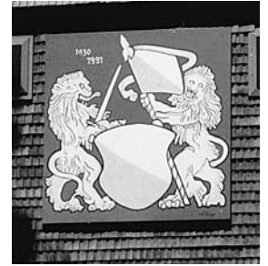
Das Kantonseblem an der Hauptfassade, bezeichnet «1930 1991». Zustand 1997.
