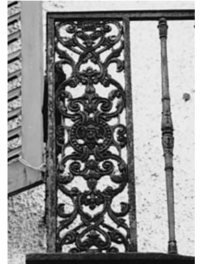
Detail des Balkongeländers in Gusseisen, wahrscheinlich von Gebr. Sulzer, Winterthur. Zustand 1992.
