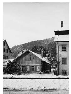
Südfassade des Nebenge-bäudes. Rechts angeschnit-ten das Hauptgebäude. Vor der Renovation. Zustand 1986.
