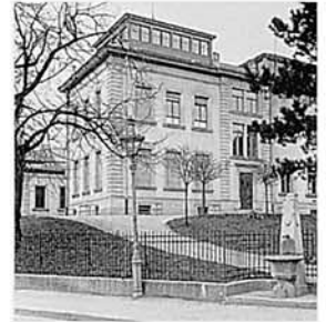
Der 1899–1901 erstellte Osttrakt an der Gloriosastrasse enthielt einen Mikroskopier- und Präpariersaal, einen topographischen Hörsaal und das Direktionsbüro. Photo des HBA-Photographen Emil Gujer. Zustand 1911.
