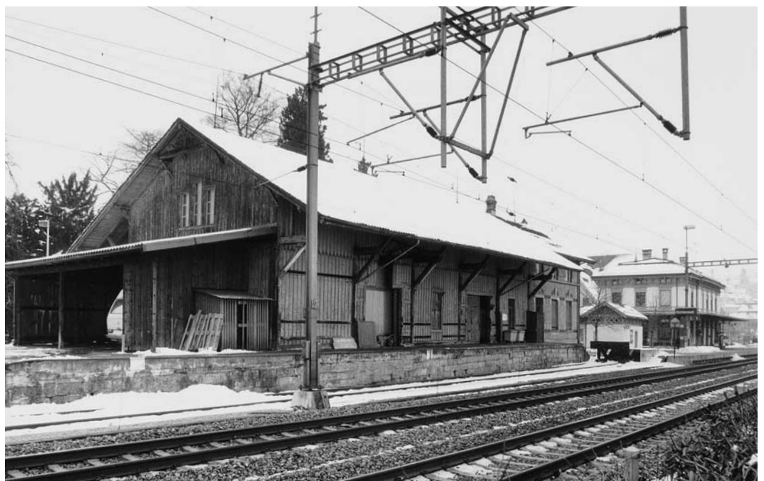
Rechts: Güterschuppen, Kiosk und Stationsgebäude liegen in einer Reihe am Bahntrasse. Zustand 1997.
