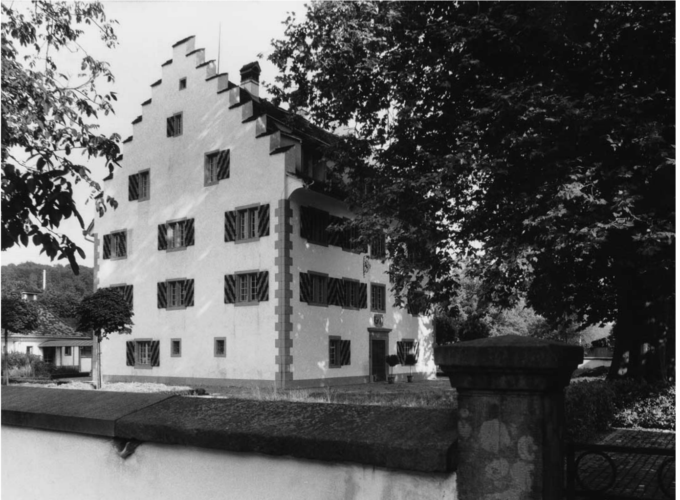
Oben: Nordwest- und Südwestseite nach der Restaurierung. Zustand 1991.
