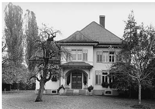
Links: Greifensee, Bauernhaus Vers. Nr. 44, Dorfstrasse 44, vor dem Abbruch 1987.
