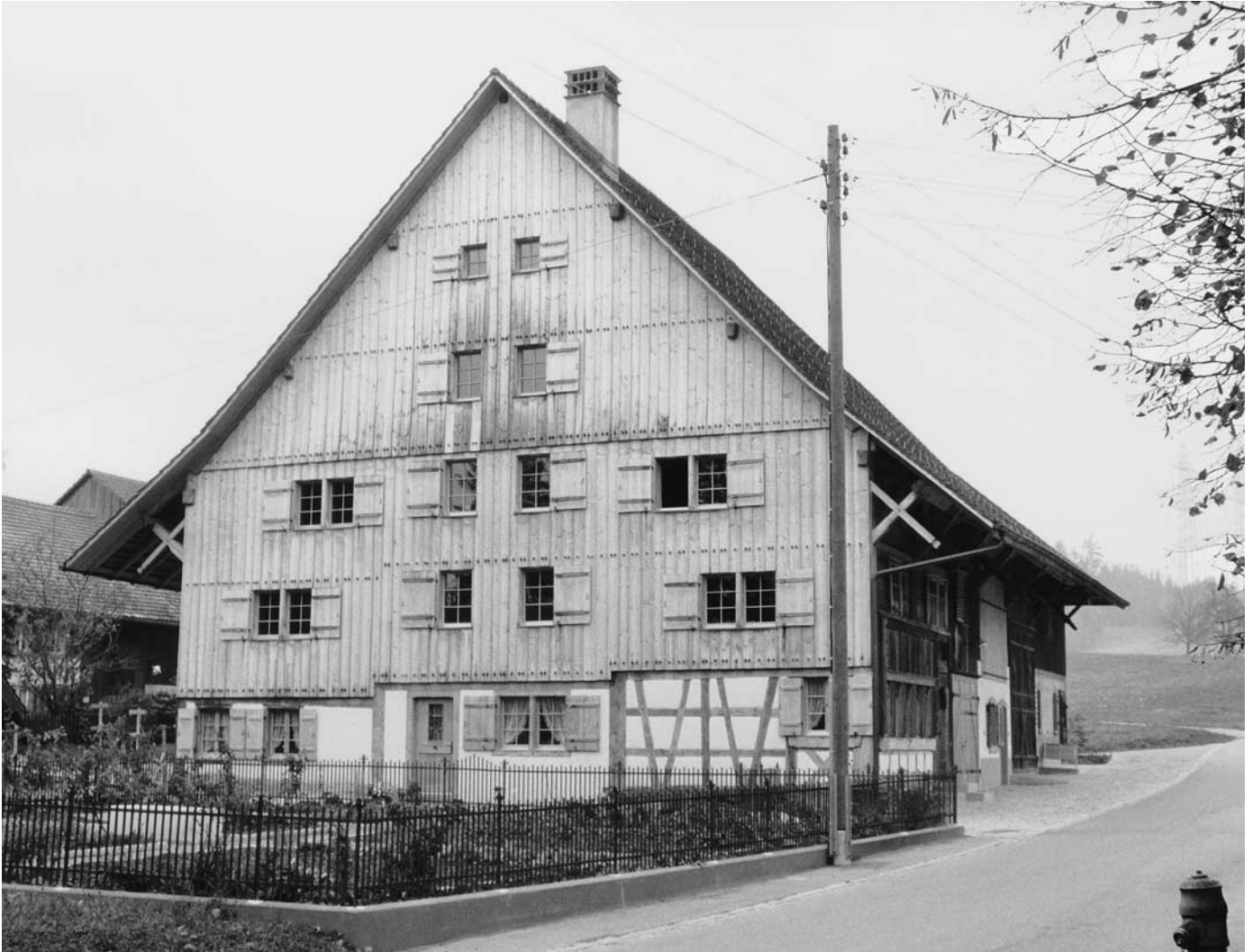
Oben: Südwestliche Giebfassade mit neuer Bretterschalung und Befensterung. Zustand 1988.
