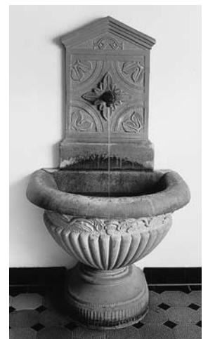
Wandbrunnen aus Sandstein im Erdgeschosskorridor des Seminargebäudes, errichtet wohl 1840. Zustand 1990.
