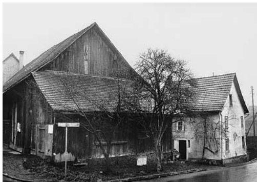
Links und rechts: Situation vor und nach der Erstel- lung des neuen Wohntrakts. Abgebrochene Bauten: Scheunentrakt des «Bertha Peter-Hauses» und Wohn- haus Vers. Nr. 193. Zustand 1977 und 1996.
