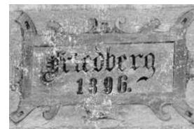
Kartusche mit Inschrift an der Südfassade. Zustand 1987.
