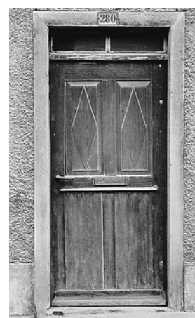
Türe des östlichen Haus- teils, um 1830. Zustand 1987.
