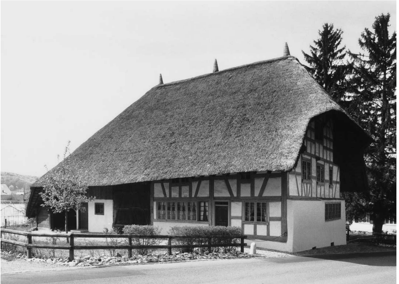
Oben: Ansicht von Südosten. Zustand 1996.
