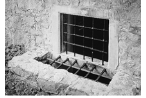
Kellerfenster mit Lüftungsöffnung.
