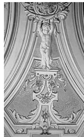
Detail der Stuckdecke im Ausstellungssaal im Parter- re des Erweiterungstraktes. Nach der Renovation. Zustand 1990.
