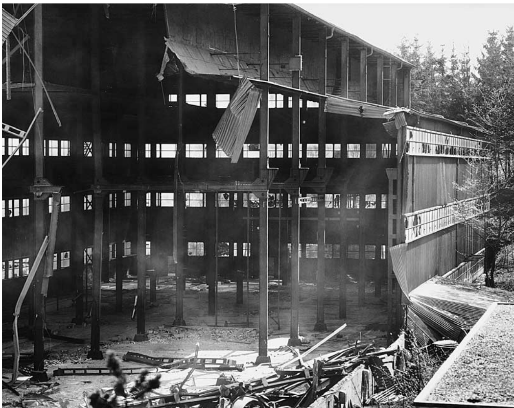
Abbruch des NOK-Unterwerks II, Ansicht von Nordwesten. Im Vordergrund das 135/150 kV-Schaltheus. Zustand am 1. April 1989.
