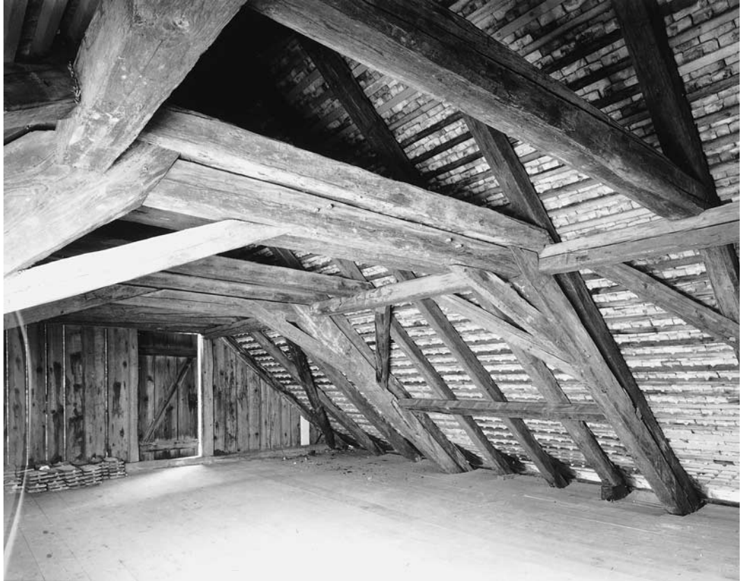
Dachstuhl mit verbretterter Giebelrückwand und Tor. Zustand nach der Renovation 1987.
