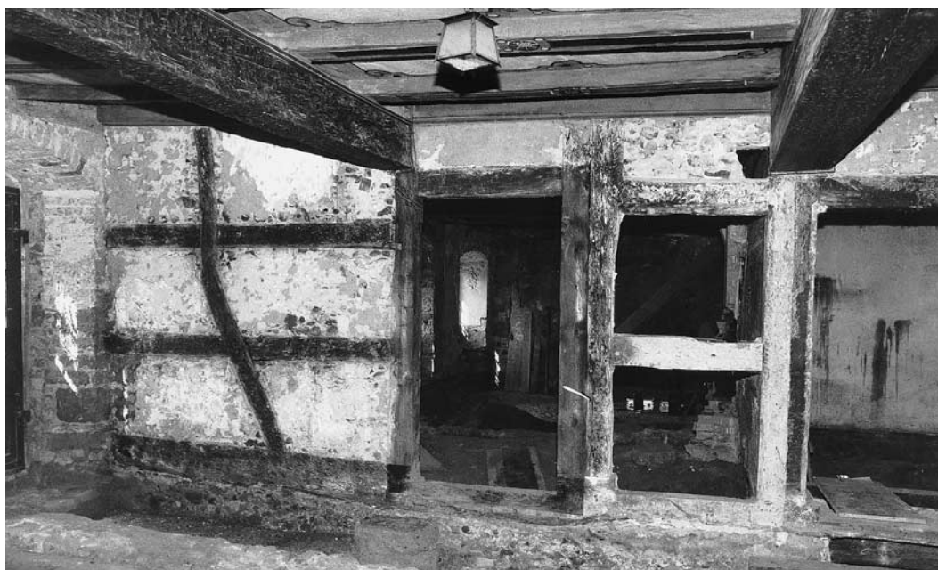
Die Erdgeschosshalle während der Freilegung 1986.
