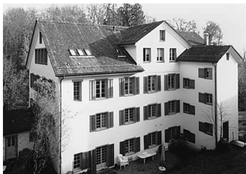
Links: Maur, Flarz, sog. «Schläflihaus» Vers. Nr. 268, Oberdorf, Burgstrasse 2, nach Umbau und Gesamtrenovation 1985–1990.
