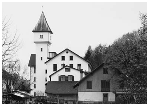
Links: Wald, Molkerei, ehem. Wirtshaus «Zur Krone» Vers. Nr. 1752, Dorfplatz; Wirtshausschild mit Krone nach der Restaurierung 1990.
