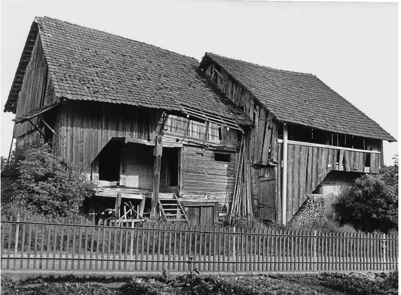
Oben: Der Speicher am ursprünglichen Ort in Tagelswangen. Nordwestseite. Zustand 1972.
