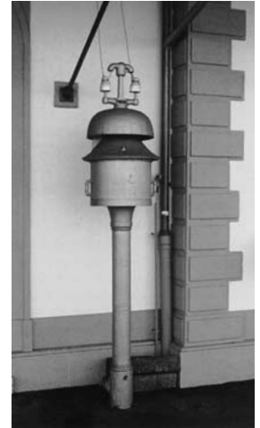
Auch die Signalglocke blieb erhalten. Zustand 1992.
