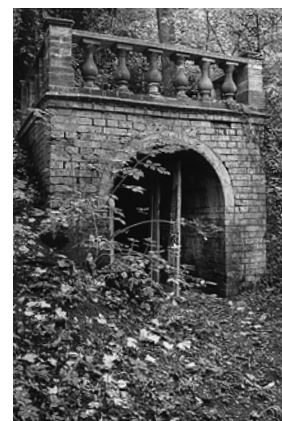
Villa Stünzi, Park. Backsteinpavillon mit Terrasse über dem Eingang zu einem Stollen des Kohlebergwerks Käpfnach. Zustand 1976.
