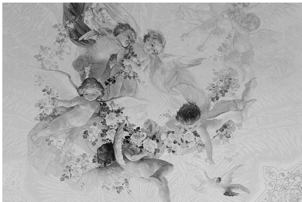
Detail der Deckenmalerei im Ausstellungssaal im Par- terre des Erweiterungstrak- tes. Nach der Renovation. Zustand 1990.
