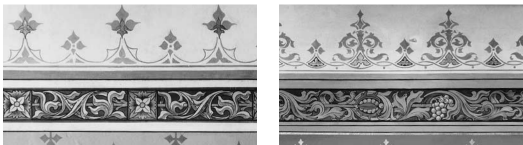
Verschiedene Ornamentfriese (Details) im Schiff (links) und Chor (rechts), nach der Renovation. Zustand 1991.
