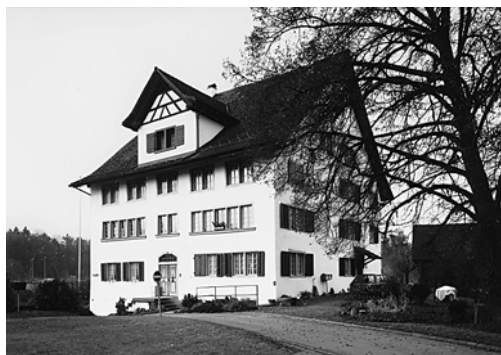
Links: Russikon, Mühlescheune Vers. Nr. 223, Bläsimühle, Madetswilerstrasse, nach der Gesamtrenovation 1988–1989.
