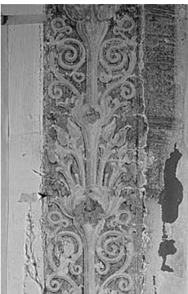
Aula im 2. Obergeschoss. Partie der ursprünglichen Wanddekoration nach der Freilegung, erster Pilaster von Westen an der Südwand. Zustand 1986. Einheimische Kürbisblätter und -ranken als dekorative Elemente. Entwurf von Diebold, Karlsruhe, Ausführung 1842 durch Erber, Zürich.
