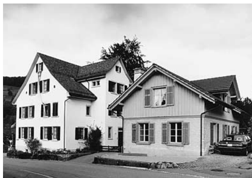
Links: Bauma, Reihenwohnhäuser Vers. Nrn. 335–338, Widen, vor dem Abbruch 1989.
