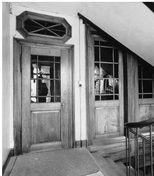
Rechts: Treppenhaus mit Wohnungsabschluss aus der Bauzeit 1844 und Aus-senverglasung um 1900. Zustand 1989.
