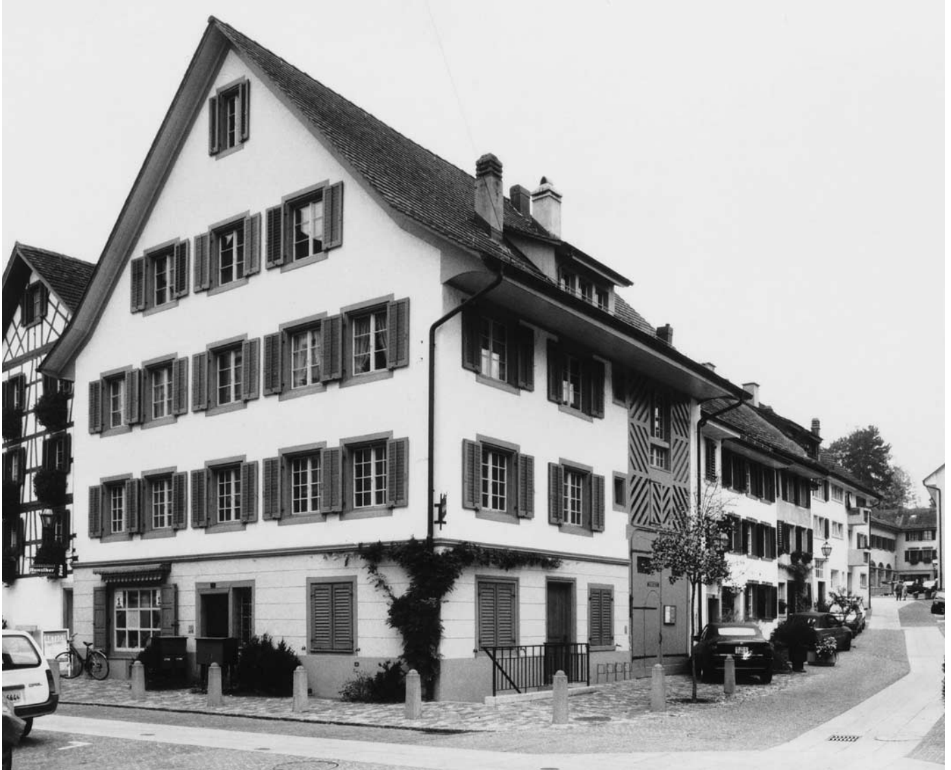
Ostecke des Hauses vor (unten) und nach (oben) dem Umbau und der Renovation. Zustand 1988 und 1995.
