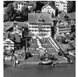
Der Landsitz «Seehof» mit Garten aus der Vogelperspektive. Zustand 1995. Photo Swissair, Zürich.
