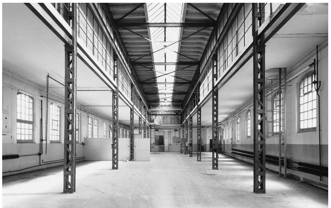
Rechts: Fabrikations- und Magazingebäude Vers. Nr. 760 (Ersatzbau von 1904), Gesamtaufnahme: Eisenskelett-Tragwerk und Laufkran (im Hintergrund) bestimmten das Bild. Zustand 1986.
