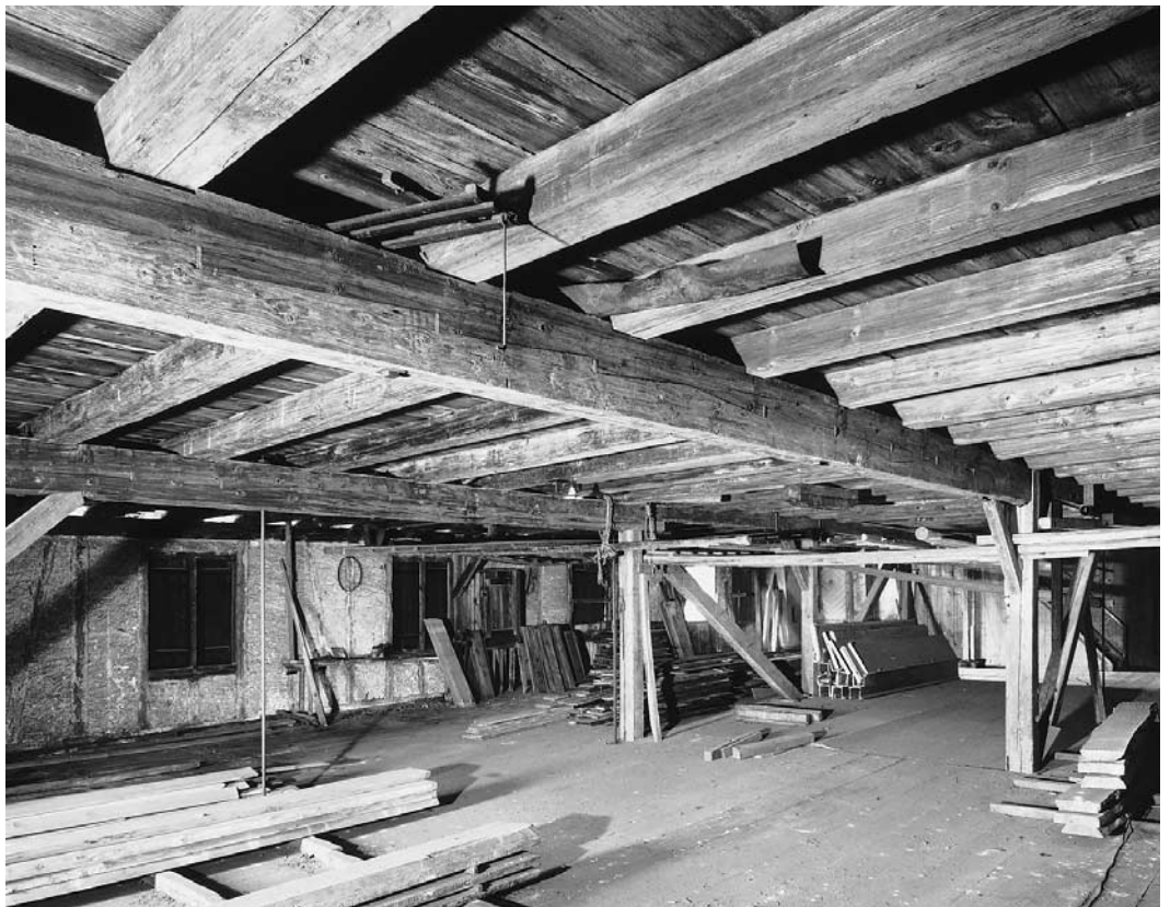
Sägerei, zweites Obergeschoss mit zwei verzahnten Unterzugsbalken. Zustand 1980. Photo Max Siegrist, Winterthur.
