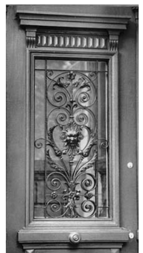
Gitter an der Eingangstüre zur Villa Stünzi. Zustand 1976.
