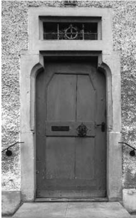
Spätgotisches Eingangsportal am «Alten Schloss». Zustand 1989.
