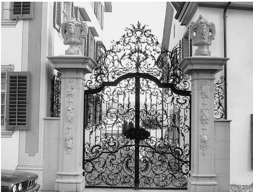
Das Gartenportal an der Strassenseite des «Seehofs» nach der Restaurierung bzw. Kopierung der Postamente in Sandstein durch die Gebr. Custer, Bäch/SZ. Zustand 1993. Das Portal wurde 1907 gemeinsam durch das Schweizerische Landesmuseum und die Gottfried Keller-Stiftung angekauft und 1992 in den «Seehof» zurückgeführt.
