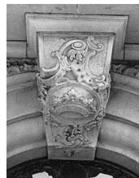
Schlussstein am Eingangsportal mit Hauszeichen «Krone». Zustand 1996.
