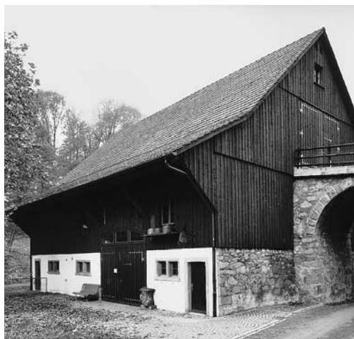
Links: Das «Mühüsli» nach der Restaurierung. Zustand 1988.
