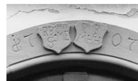
Bauinschrift am westlichen Kellerportal nach der Restaurierung 1990–1991. «17 RB ME HIB / RB MHH 07» (Rudolf Bühler, Magdalena Egli, wohl Hans Jakob Bühler, Dreipasszeichen des Wappens Bühler. «RB/MHH» ungeklärt).
