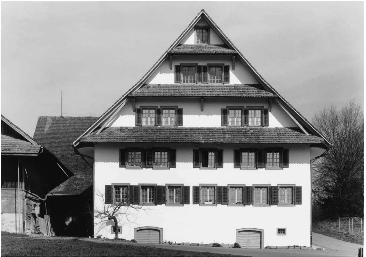
Oben: Südwestseite des Wohnhauses nach Umbau und Renovation. Der Fensterbestand im 1. Dachgeschoss wurde verdoppelt (vgl. Abbildung unten). Zustand 1989.
