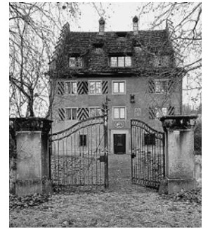
Das Schloss mit der Portalanlage von 1789. Zustand 1974.
