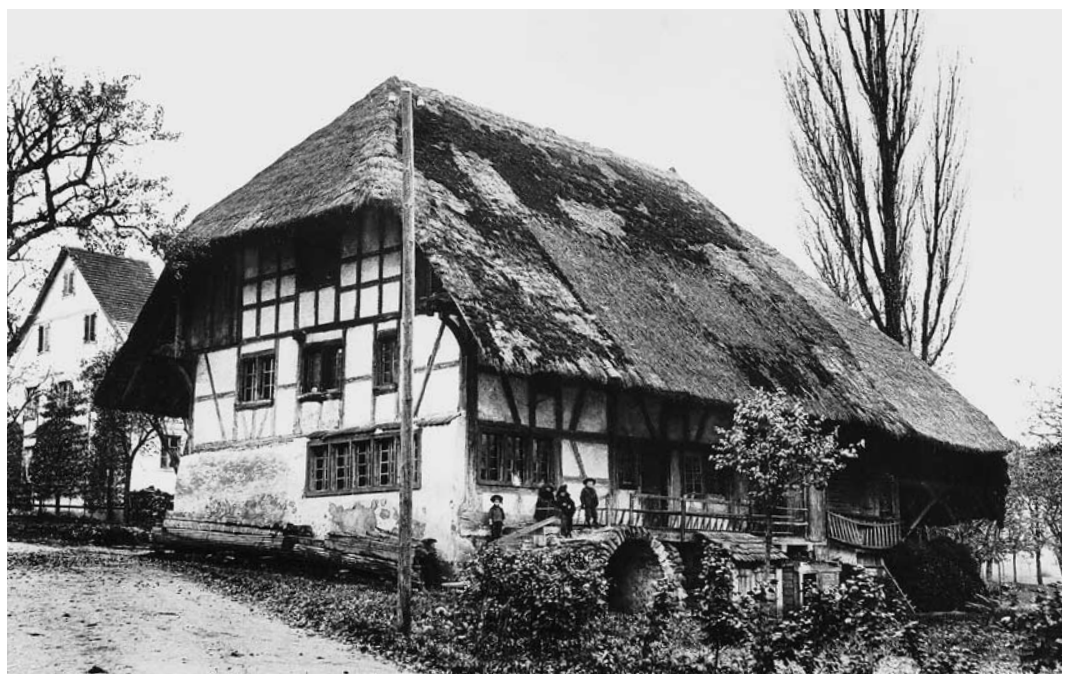
Rechts: Ansicht von Nordosten. Gut sichtbar ist der aus Bruchsteinen gemauerte Kellerhals. Zustand um 1900.
