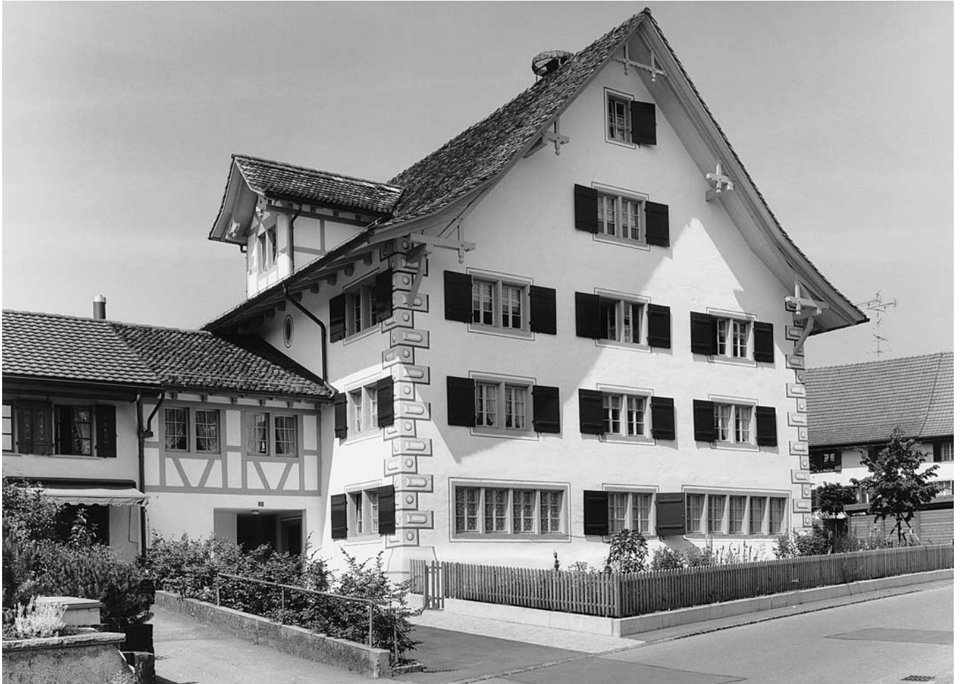
Oben: Südfassade nach der Renovation. Zustand 1988.
