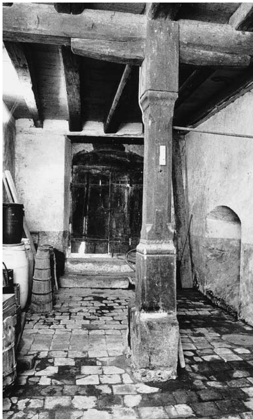
Zwei Jochsäulen im Keller- geschoss vor der Renova- tion. Zustand 1987.
