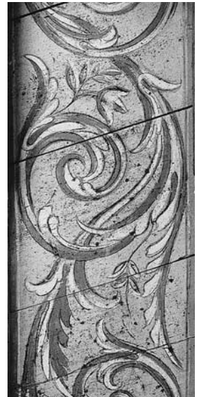
Rankenmalerei in grau und weiss auf hellgrauem Grund, an der Decke im Raum 1 im Erdgeschoss; vor der Restaurierung. Zustand 1980.
