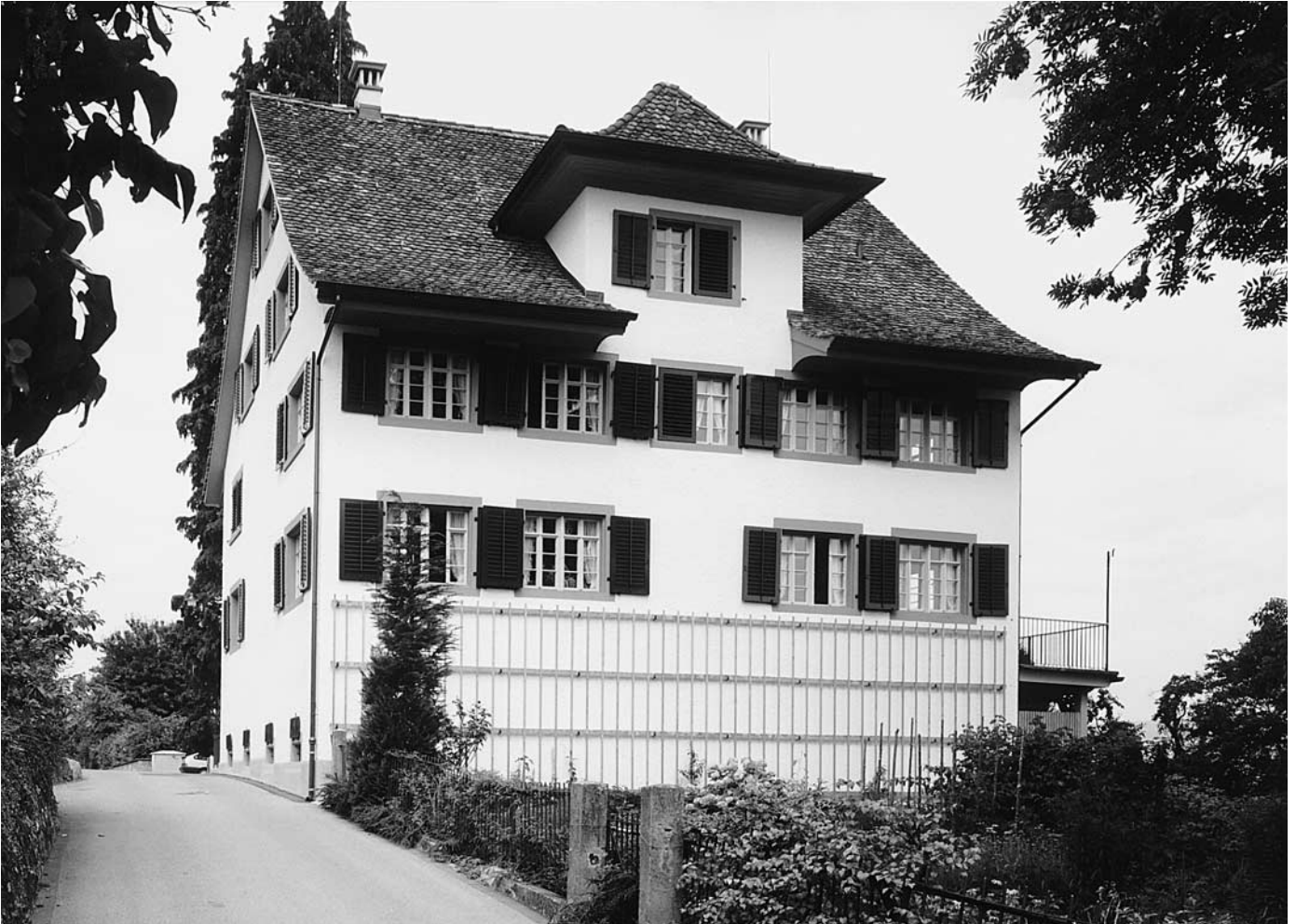
Oben: Südostansicht des renovierten Gebäudes. Zustand 1988.
