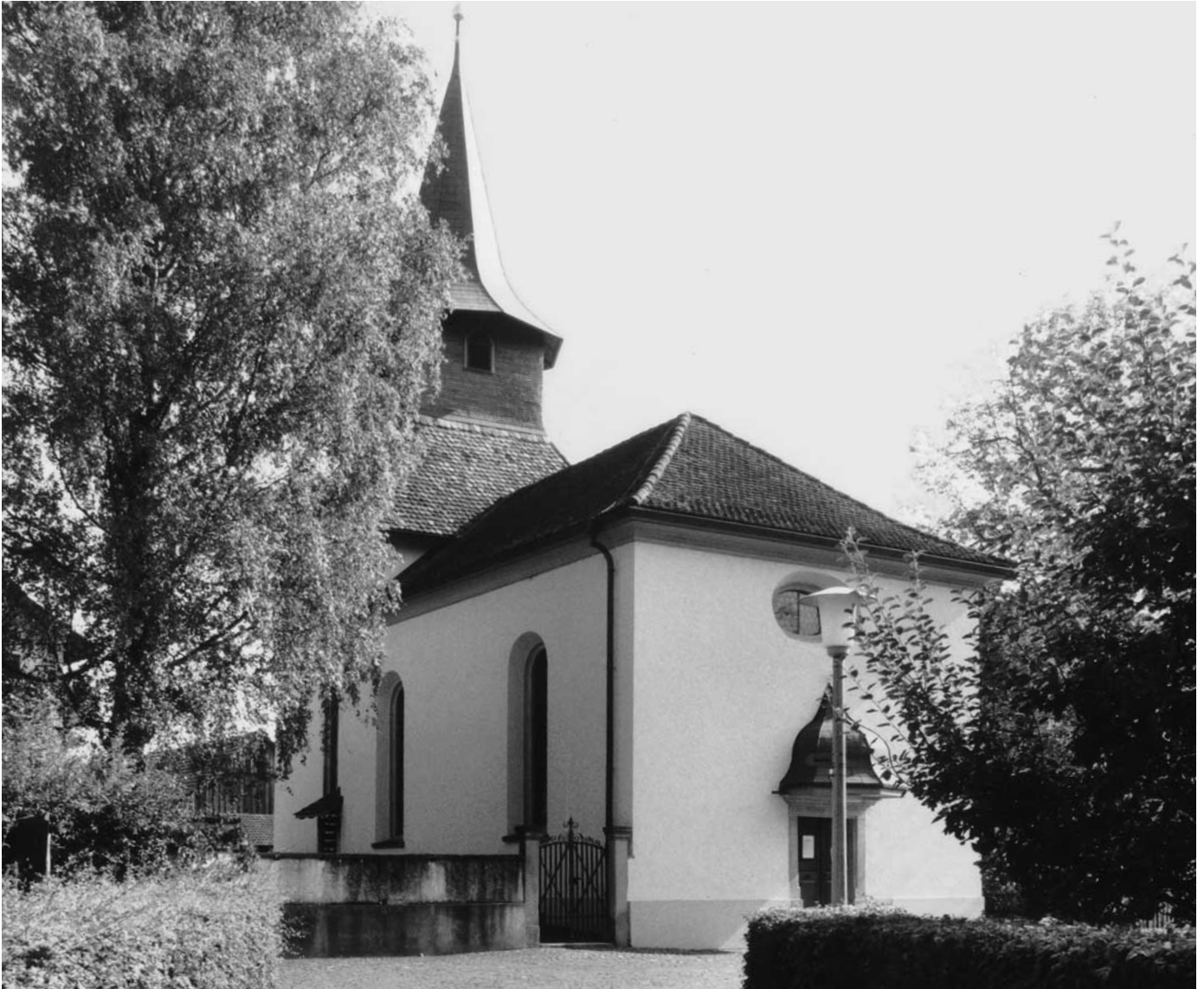
Oben: Nordwestseite der Kirche nach der Renovation. Zustand 1995.
