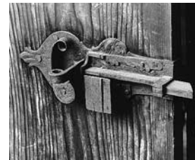
Barockes Türschloss im 2. Obergeschoss des Hauptgebäudes. Zustand 1985.
