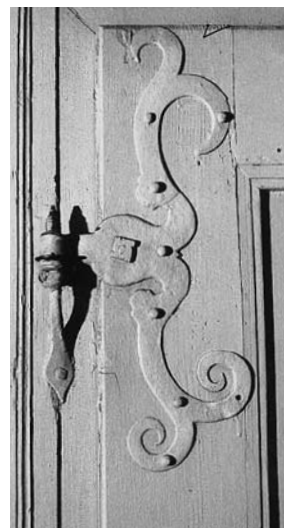
Barockes Türband im Erdgeschoss. Zustand 1988.
