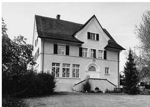
Links: Uster, ehem. ref. Pfarrhaus Vers. Nr. 2441, Zentralstrasse 38, nach der Aussenrenovation 1987.
