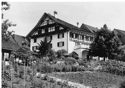
Links: Rafz, Wohnhaus Vers. Nr. 509, Chilegass 7, 9, nach Umbau und Aussenrenovation 1988–1989.
