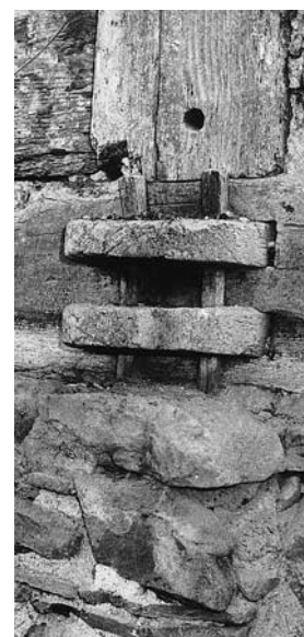
Schwellenschloss am Mittelstud der Nordfassade. Zustand 1990.
