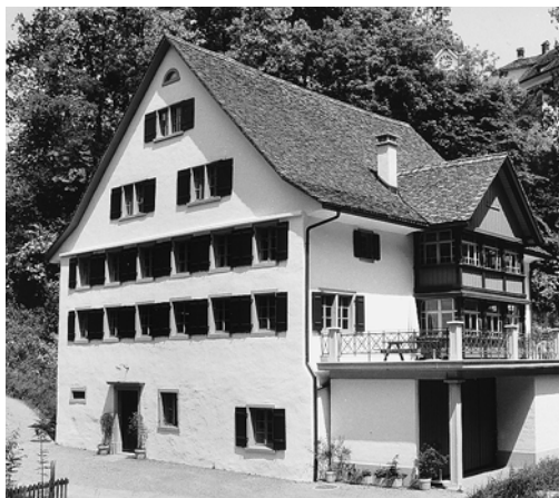
Rechts: Nordfassade während der Restaurierung 1988 und Zustand 1990.
