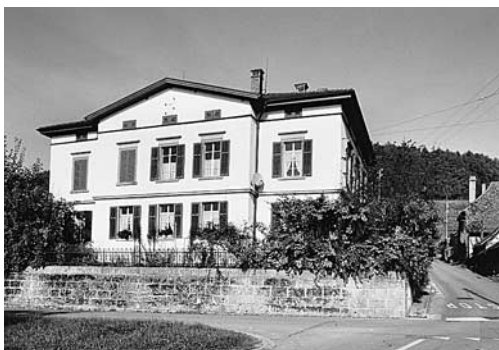
Links: Trüllikon, ref. Pfarr-haus Vers. Nr. 127, Andel-fingerstrasse 12, nach der Gesamtrenovation 1988–1989.
