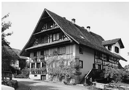
Links: Meilen, Ortsmuseum Vers. Nr. 425, Lämmliweg 14, nach Umbau und Renovation 1988.
