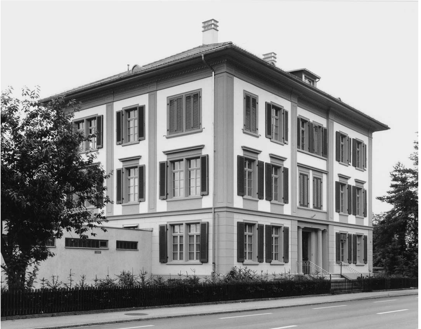
Oben: Nach der Renovation. Zustand 1990.
