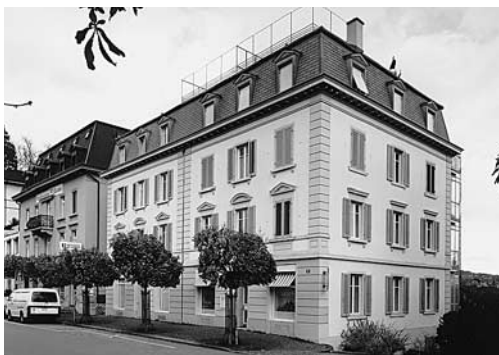
Links: Stäfa, Wohnhaus «Chergarten» Vers. Nr. 1043, Hädeli-strasse 19, nach der Aus-senrenovation 1987–1988.
