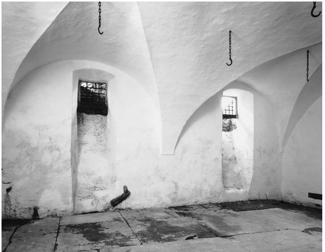
Kreuzgewölbter Kellerraum nach der Renovation. Zustand 1987.
