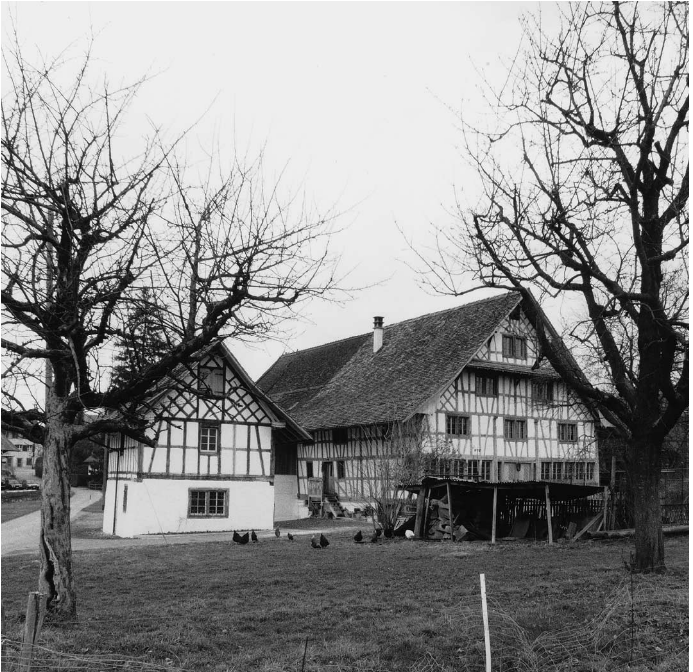
Oben: Wohnhaus mit Waschhaus, nach der Sanierung. Zustand 1992.
