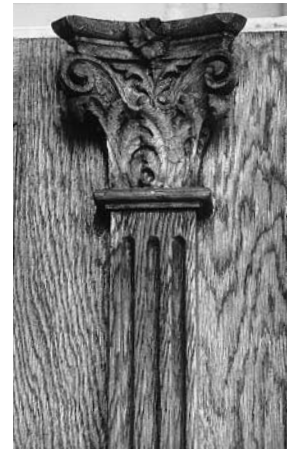
Kannelierter Holzpilaster mit Kompositkapitell am Portal des «neuen Schulhauses». Zustand 1985.
