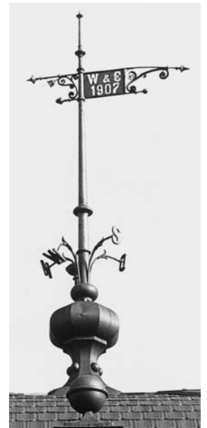
Wetterfahne auf dem zentralen Kuppelbau. Zustand 1975.
