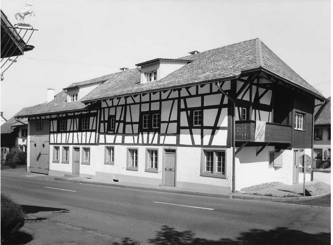
Oben: Süd- und Ostfassade nach der Restaurierung. Zustand 1990.
