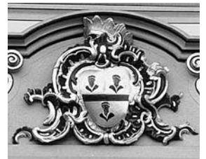
Gemaltes Wappen des Bauherrn Felix Oeri (drei Mohren) in der Kartusche über dem Balkonportal der Nordseite. Zustand 1993.
