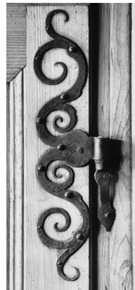
«Bockshorn»-Beschlag an der Türe der ehemaligen Gesindestube im 1. Obergeschoss.
