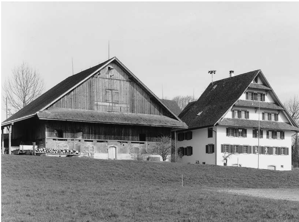
Das um 1780 erbaute Wohnhaus und die 1911 neu erbaute Scheune nach Umbau und Renovation. Zustand 1989.
