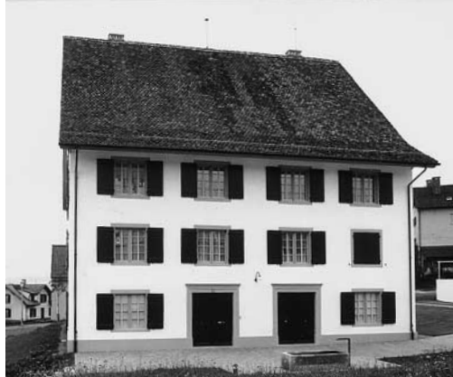
Nordwestfassade vor und nach der Renovation. Zustand 1987 und 1988.
