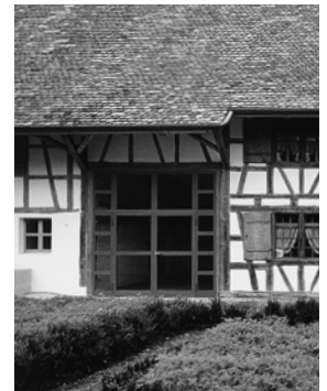
Die neue verglaste Tür- und Fensterwand bezeichnet die ehemalige Tennzone (vgl. Abbildung links unten). Zustand 1989.
