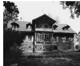
Das erhaltene ehemalige Direktorenwohnhaus Zürichstrasse 70, erbaut 1874. Zustand 1978.
