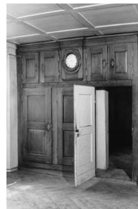
Einbauschränk (wahrscheinlich 1837) in der südöstlichen Stube im Erdgeschoss, mit Uhr und Durchgang zur Küche, vor der Restaurierung. Zustand 1990.
