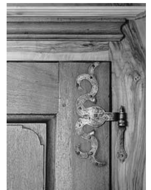
Barockes Türband im Erdgeschoss.
