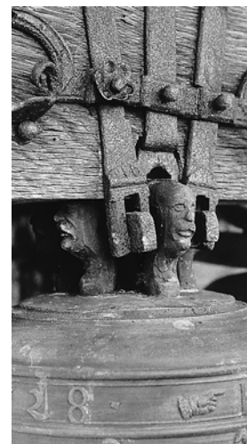
Detail des geschmiedeten Konsolträgers der Glocke von 1728. Zustand 1985.
