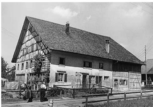
Links: Horgen, ref. Pfarrhaus «Pfrund» Vers. Nr. 706, Alte Landstrasse 23, nach der Aussenrenovation 1987.
