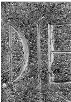
Detail der Inschrift vor der Renovation. Zustand 1990.
