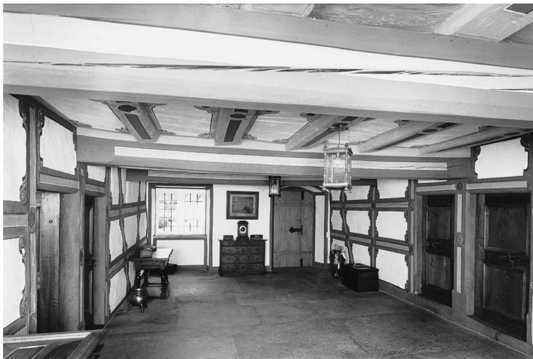
Die Erdgeschosshalle (Raum 0.1) des Schlosses nach der Restaurierung. Zustand 1990.
