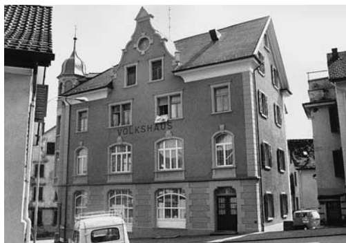
Links: Wädenswil, Haus «Zur alten Kanzlei» Vers. Nr. 450, Zugerstrasse 28, nach Umbau und Fassadenrenovation 1986–1987.
