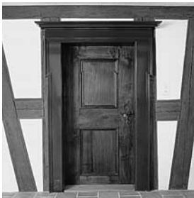
Türe im Flur des 1. Obergeschosses nach der Renovation. Zustand 1988.
