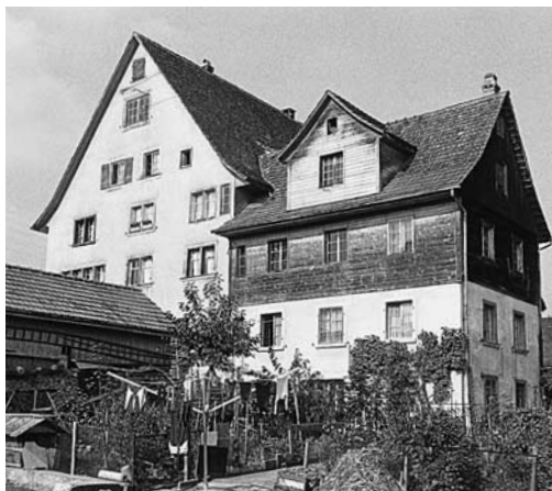
Oben: Die Südwestfassade nach der Renovation. Zustand 1989.
