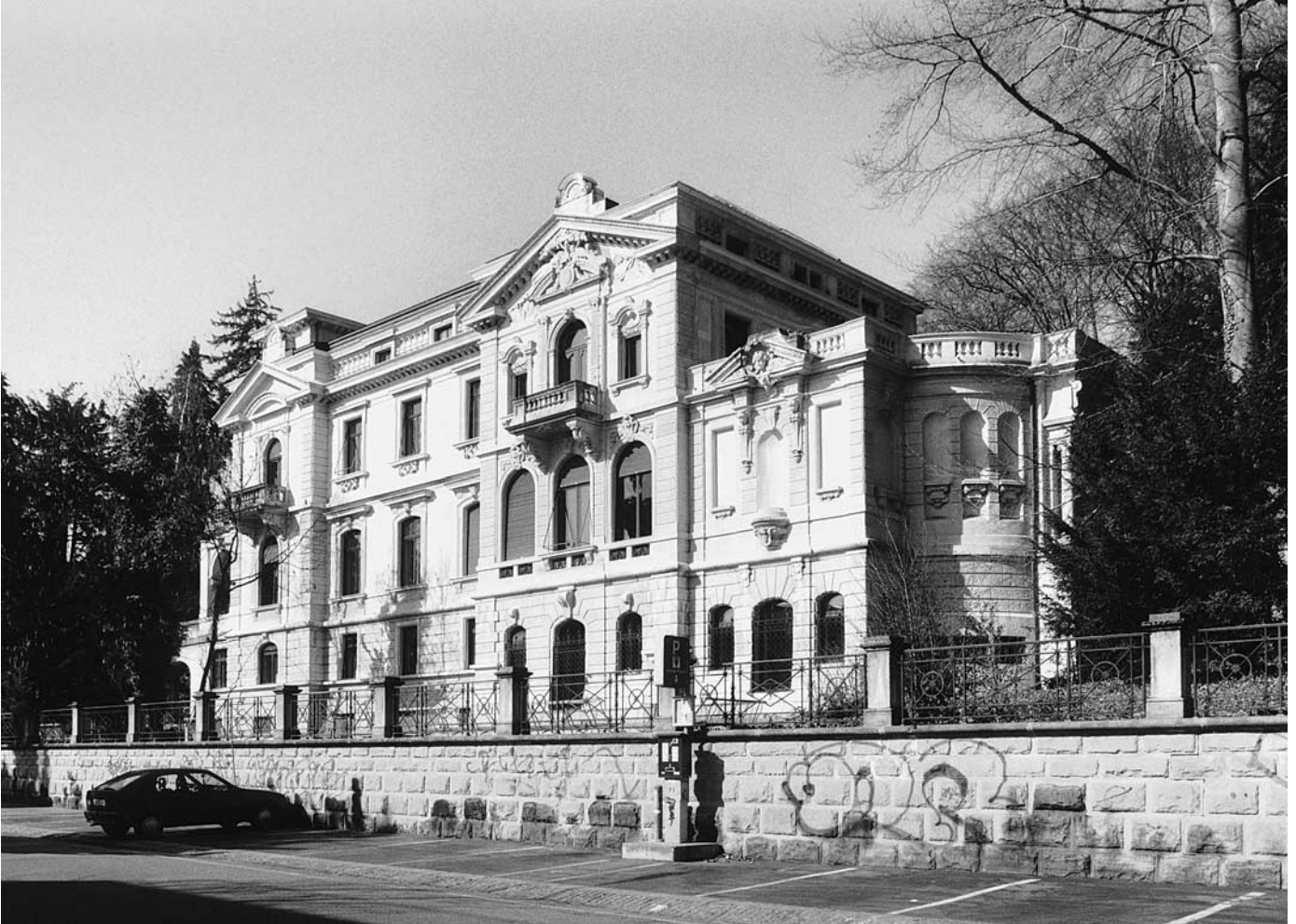
Oben: Hauptansicht der Villa nach der Renovation. Die Gebäudehälfte links wurde 1898–1899 erstellt, die rechte Hälfte mit übergiebeltem Risalit und Terrassenanbau 1902–1904. Zustand 1997.
