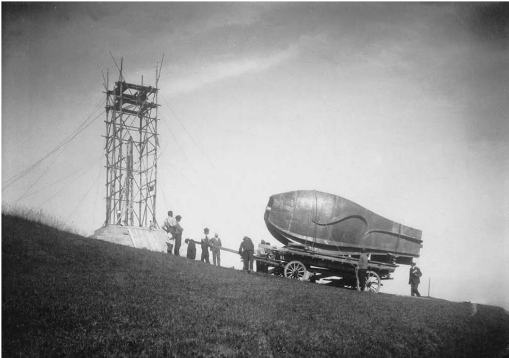
Montage der Kupferflamme. Photo am 25. August 1922 von Architekt Hermann Fietz (1898–1977), der wahrscheinlich die Bauleitung inne hatte.
