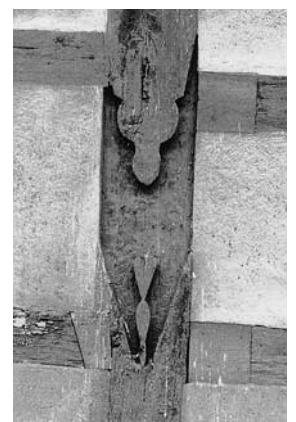
Anblattung an einem Ständer im Obergeschoss der Südfassade. Zustand 1987.
