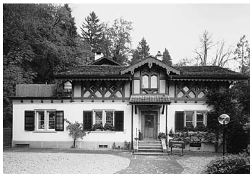
Links: Schönenberg, Wohnhaus Vers. Nr. 138, Mittler-Langwis, nach der Aussenrenovation 1989.
