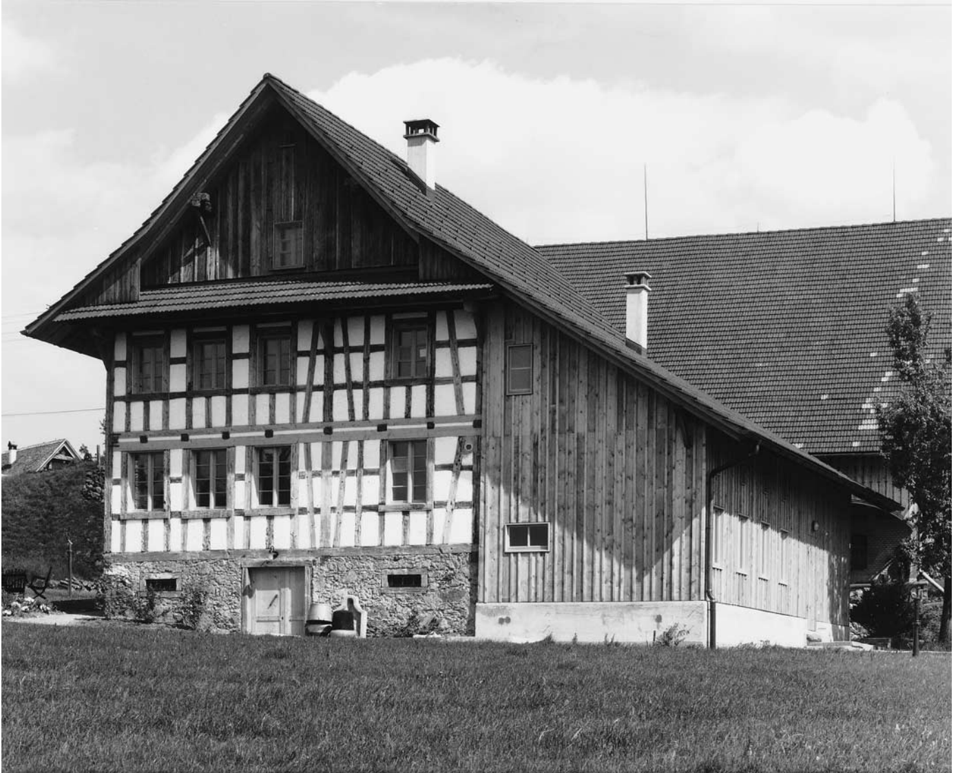
Oben: Nordwestansicht nach der Renovation. Rechts mit Schleppdach die ehemalige Wagenremise, deren Befensterung die neue Nutzung als Wohnraum diskret andeutet. Zustand 1991.
