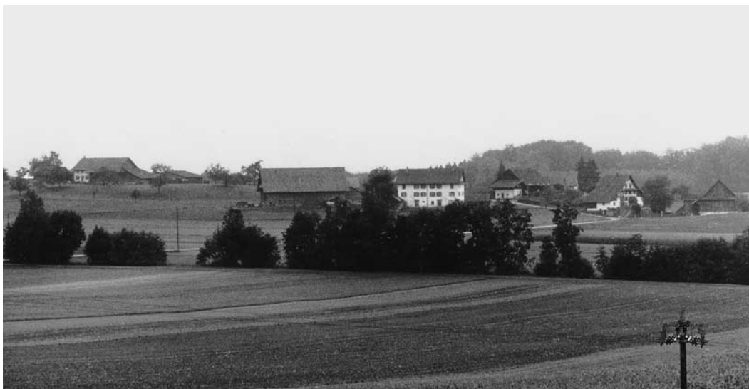
Der Hof Vollenweid mit Doppelscheune und Doppelhaus in der Bildmitte, Zustand 1989, vor der Sanierung.
