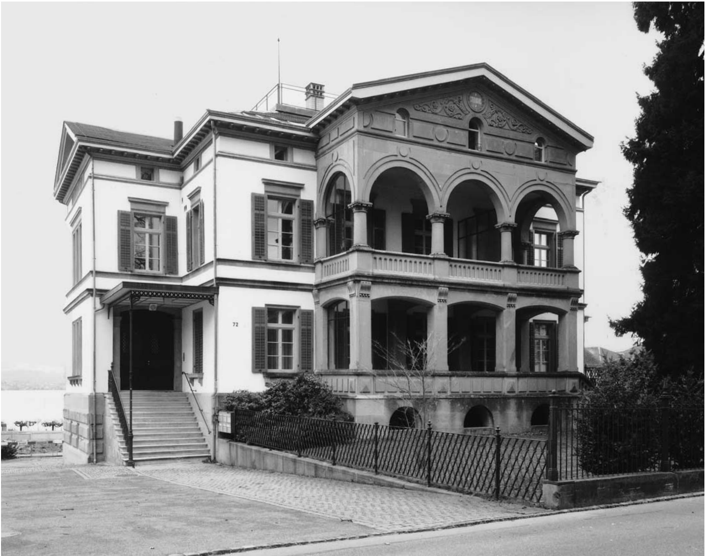
Oben: Südwestfassade der Villa nach der Renovation. Zustand 1996.
