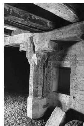
Zentraler, auf 1557/1558 dendrodatierter Stud im Schlosskeller nach der Freilegung. Zustand 1986.
