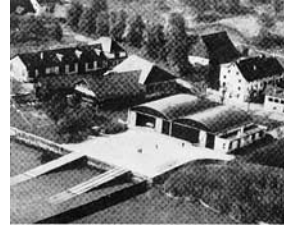
Die 1920 erstellte Doppelhalle mit Vorplatz und Ab- laufbahnen für Flugboote. Links die Yachtwerft Faul. Zustand 1921 (Bild aus Dok. 5).
