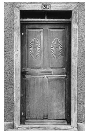
Türe des westlichen Haus- teils, um 1830. Zustand 1987.
