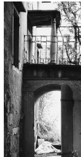
Der gewölbte Durchgang zwischen der südwestlichen Giebelfront und dem Waschhaus, mit klassizistischem Geländer und balkontragendem Säulenpaar. Zustand 1987, vor dem Abbruch.
