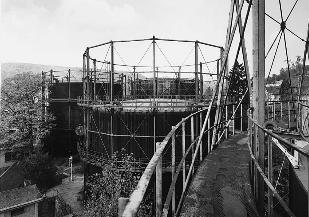
Blick vom sog. Gasometer Nr. 1 (vorn) auf die sog. Gasometer Nrn. 2, 3 und 4 (Mitte und hinten links und rechts). Zustand 1978.
