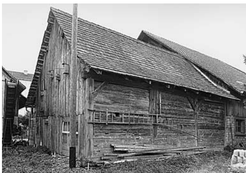
Links: Elsau, Bauerngut «Pestalozzihaus» Vers. Nrn. 46/47, Rätterschen, Alte St. Gallerstrasse, links das Bauernhaus Vers. Nr. 47 nach der Gesamtrenovation 1987.
