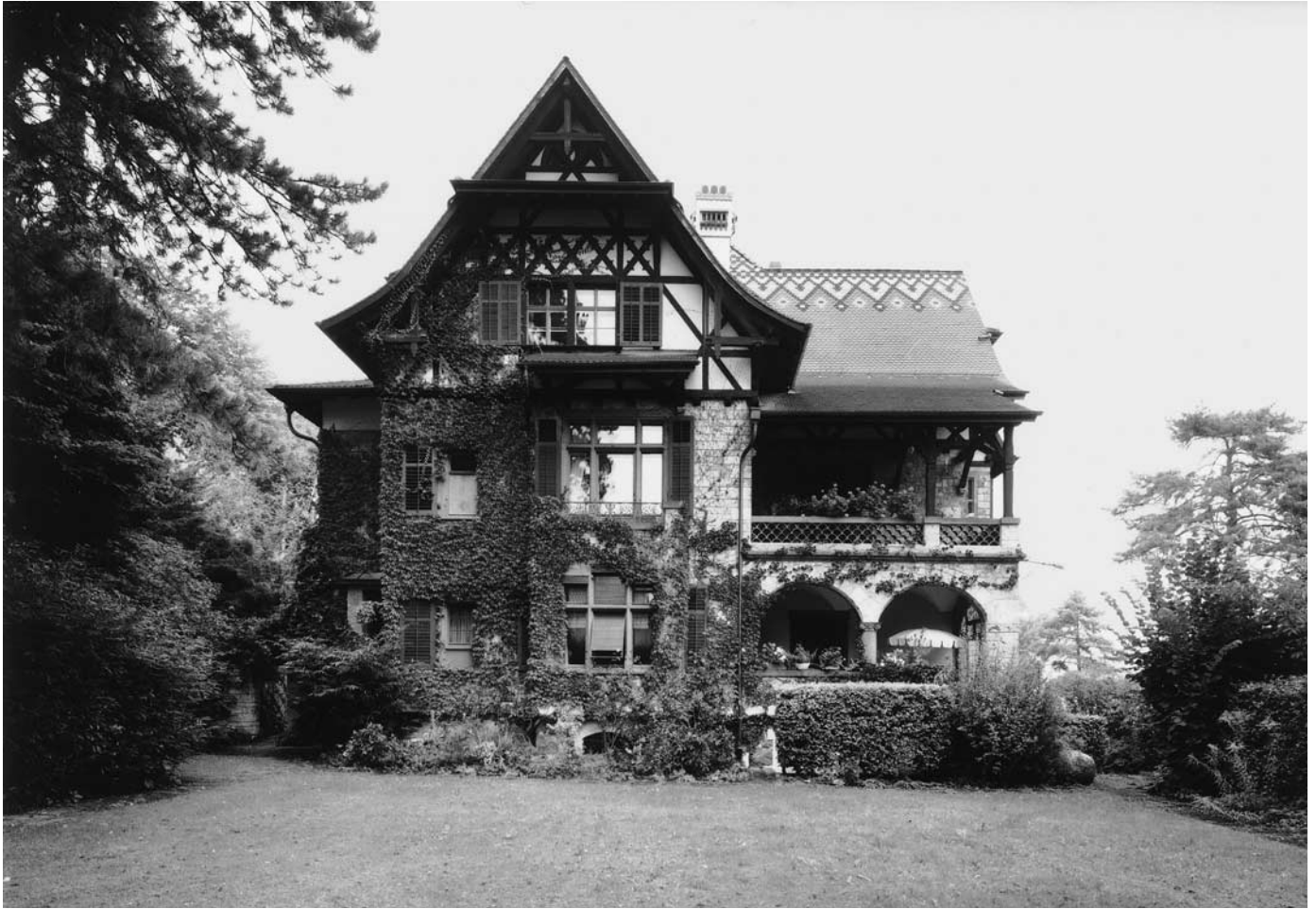
Oben: Süd- bzw. Garten- seite des Landhauses nach der Renovation. Zustand 1996.
