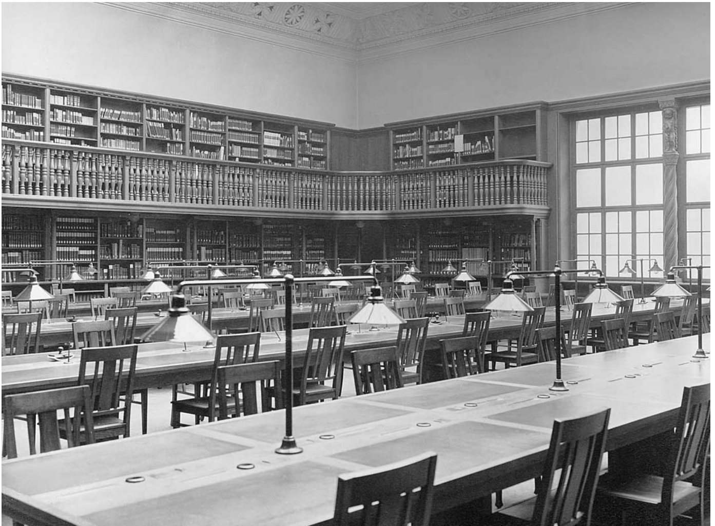
Oben: Der 1990 abgebrochene Lesesaal der Zentralbibliothek kurz nach der Inbetriebnahme 1917. Rechts oben Holzplastik Adam als Kind, auf gewundener Säule, von Carl Fischer (1888–1987). Photo BAZ.
