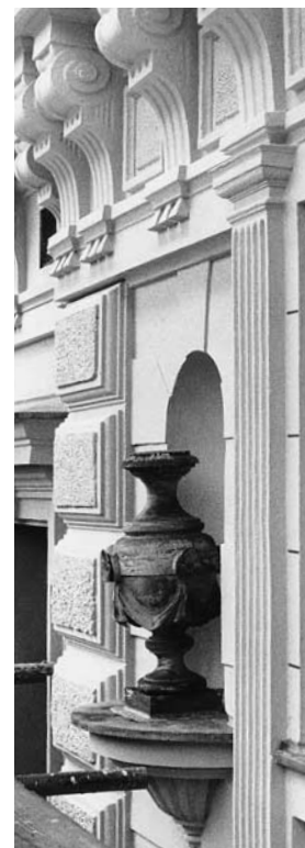
Fassadendetail vom 2. Obergeschoss der Ostseite des Villenanbaus. Zustand während der Restaurierung 1988.
