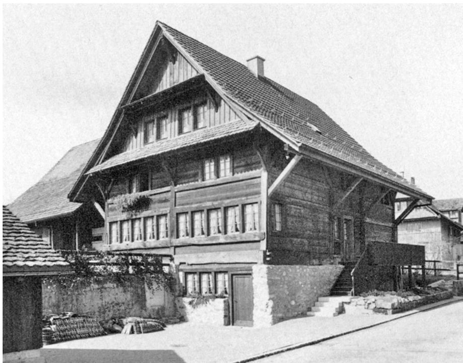
etwas verändert worden. Die 1976/77 von beiden Hauseigentümern durchgeführte Renovation beschränkte sich auf die Sanierung des Äusseren. Dabei wurde das Holzwerk instandgestellt, die verputzte Nordseite wieder freigelegt und das Dach, soweit nötig, umgedeckt. Ausserdem konnten neue Fenster angefertigt sowie Dachrinnen und Abfallrohre durch kupferne ersetzt werden. Gemeinde und Kanton leisteten Beiträge, das Gebäude steht seither unter Schutz.
