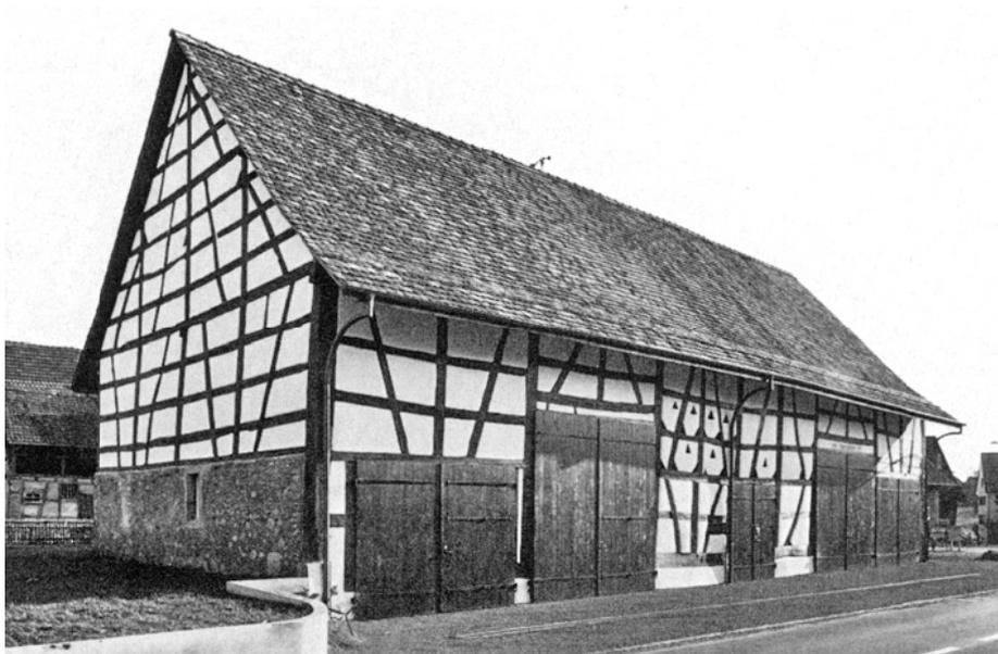
dürfte der Bau um 1700 entstanden sein. Bei der Gesamtrenovation 1977 wurden der Verputz und die Ausfachungen überholt, die Riegel- und übrigen Holzelemente saniert, neue Fenster eingehängt, die Jalousien repariert, die Dachflächen umgedeckt, neue kupferne Dachrinnen und Abfallrohre montiert und sämtliche Anstriche erneuert. Leider wurde das Riegelwerk im modischen Braun lasierend und nicht mit dem im Weinland üblichen Rotbraun gestrichen.
