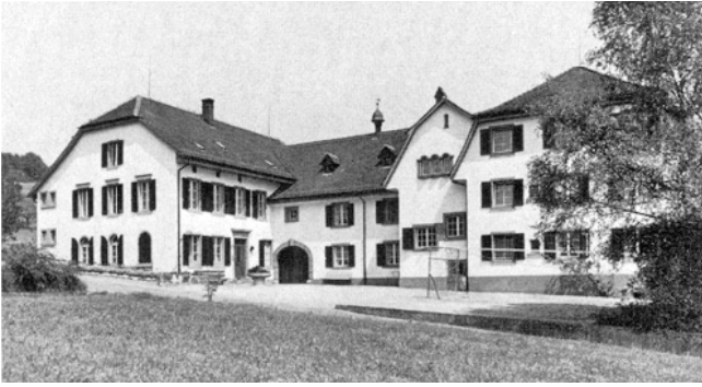
Stäfa. Mühlehölzli. Altersheim Vers. Nr. 1403/1404. Nach der Restaurierung 1976.
