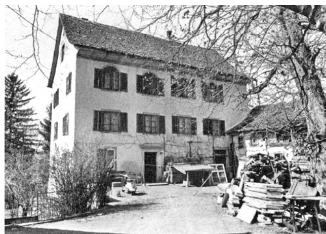
Maur. Burg. Vor der Restaurierung 1974/75.
