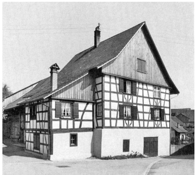
Marthalen. Tiefenwegen. Ehem. Bauernhaus «Zum Buck» (Vers. Nr. 169). Nach der Renovation 1975/76.
