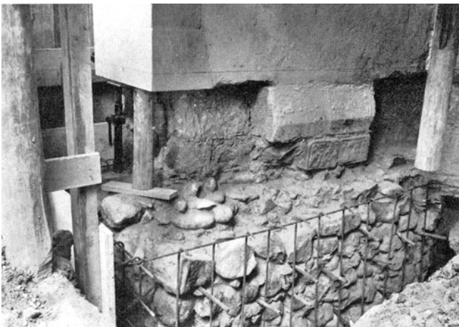
Zürich. Predigerchor. Nordseite. Strebebfeilerfundament und -sokkel während der Bauarbeiten im September 1963. Ummantelung in Sica-Beton.
