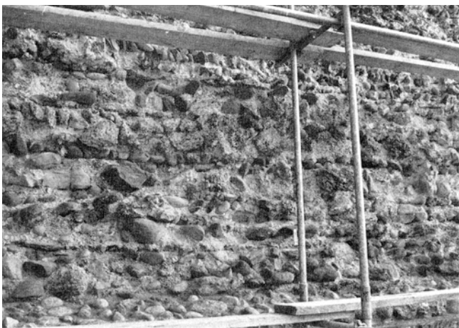
Freienstein-Teufen. Burgruine Freienstein. Nordmauer. Detail des Mauerkerne mit den horizontalen Nivellierbändern aus kleinen Kiesel.
