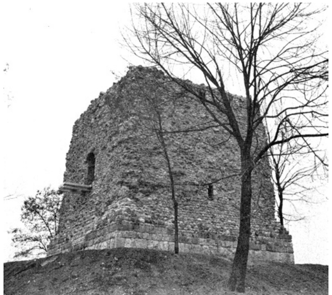
Freienstein-Teufen. Burgruine Freienstein. Oben: Ansicht aus Südosten vor der Konservierung; unten: nach der Konservierung 1975–1977.
