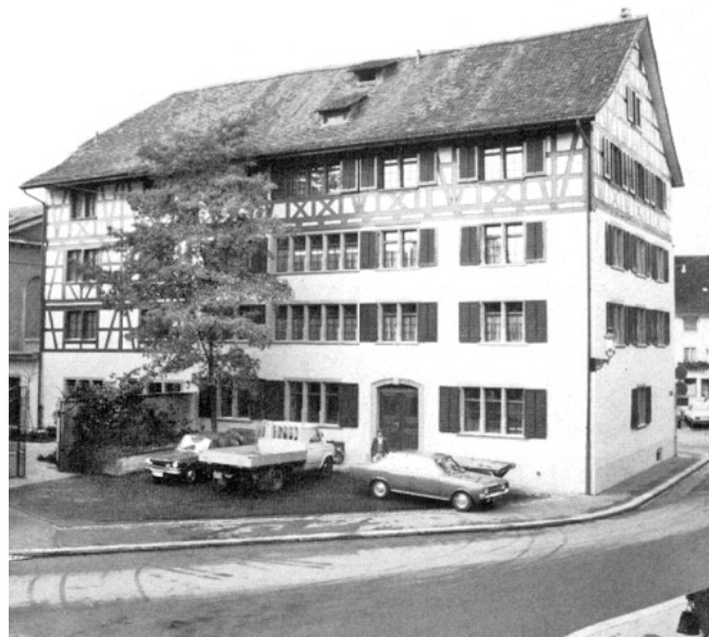
Altstadt. Neumarkt 4. «Königshof». Oben: vor der Restaurierung; unten: nach der Restaurierung 1975/76.
