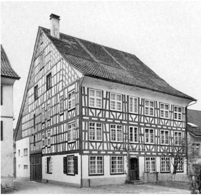
Elgg, Hintergasse 18. Wohnhaus Vers. Nr. 226. Nach der Aussenrenovation 1976.
