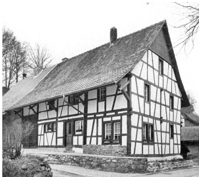
Niederweningen. Breitstrasse. Ehem. Bauernhaus Vers. Nr. 139. Nach der Renovation 1975.
