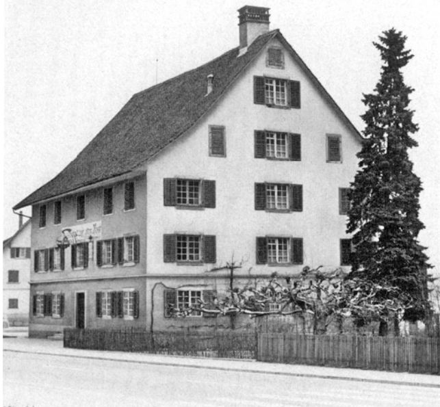
Regensdorf. Watterstrasse. Ehem. Gasthof «Zur alten Post». Abgebrochen 1973. Oben: Zustand vor dem Abbruch, unten: retuschierte Photographie als Anregung zu einer Renovation.
