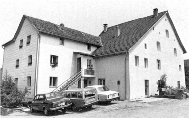
Wädenswil, Untere Gisenrüti. Ehem. Bauernwohnhaus Vers. Nr. 1304/1305. Oben: vor dem Umbau; unten: nach dem Umbau 1975/76.
