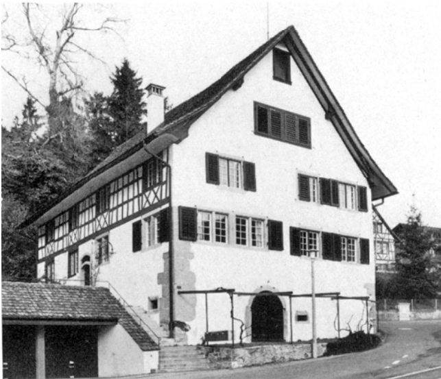
Herrliberg. Obergrüt. Ehem. Weinbauernhaus «Alter Grüthof», Vers. Nr. 809. Nach der Renovation 1976/77.
