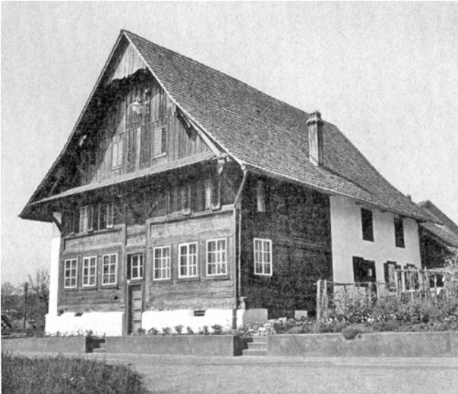
Mettmenstetten. Dachelsen. Doppelbauernwohnhaus Vers. Nr. 753. Nach der Restaurierung 1975.
