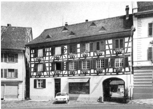
Andelfingen. Landstrasse. Geschäftshaus «Zur alten Post» (Vers. Nr. 19). Nach der Restaurierung 1975/76.
