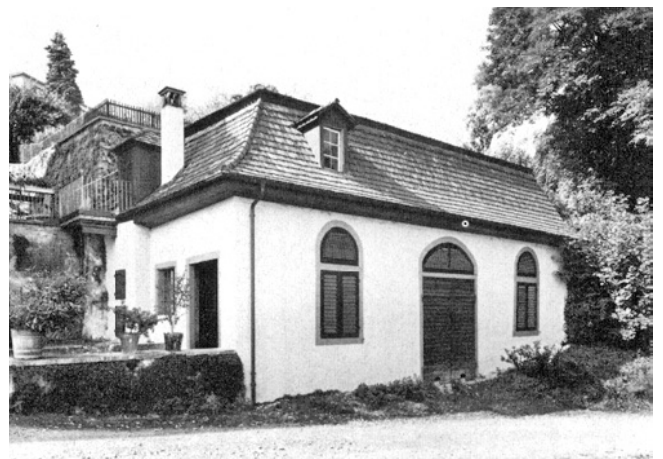
Andelfingen. Haldenmühle. Waschhaus Vers. Nr. 179. Nach der Aussenrenovation 1976.
