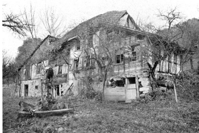
Äugst a. A. Im Scheller. Ehem. Bauernhaus Vers. Nr. 261. Abgebrochen 1974.
