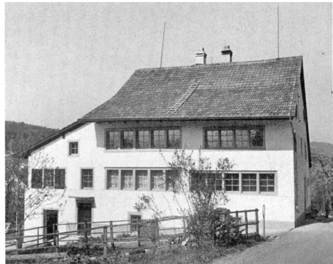
Oetwil a. S. Chilerain. Reihenhaus Vers. Nr. 810/812. Nach der Aussenrenovation 1976.
