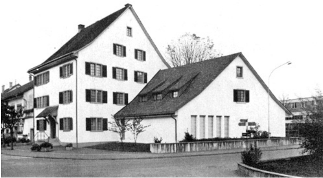
Pfäffikon. Seestrasse 45. Altes reformiertes Pfarrhaus, jetzt Kirchengemeindehaus. Nach Renovation und Anbau eines Saales 1976/77.
