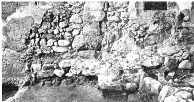
Affoltern a. A. Reformierte Kirche. Archäologische Untersuchungen 1975. Westmauer und Südwestecke des Turmes der spätgotischen Kirche.
