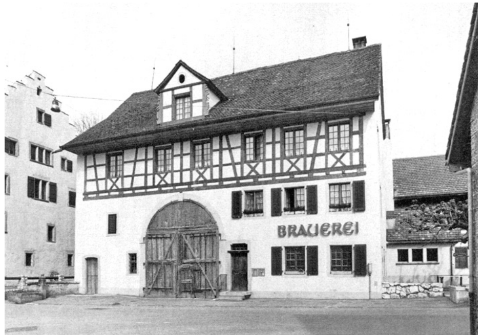
Otelfingen. Restaurant «Brauerei» (Vers. Nr. 57). Nach der Teilrestaurierung 1975/76.
