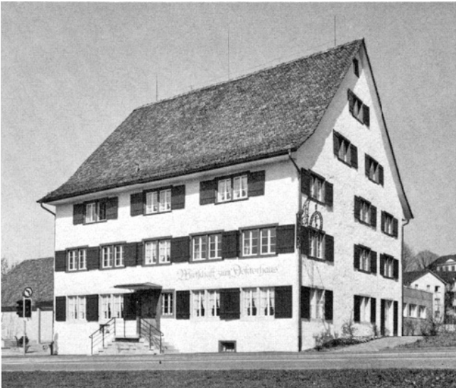
Wallisellen. Kreuzplatz. Wirtschaft «Zum Doktorhaus». Oben: vor der Renovation; unten: nach der Renovation 1975/76.
