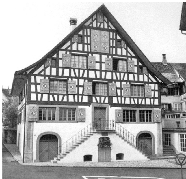
Richterswil. Dorfbachstrasse 12. Haus «Zum Bären» (Vers. Nr. 278). Nach der Restaurierung 1975/76.
