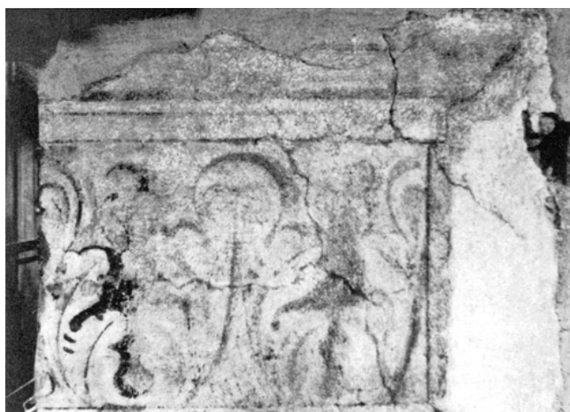
Richterswil. Dorfbachstrasse 12. Haus «Zum Bären» (Vers. Nr. 278). Fassadenmalerei auf der Südostfassade: Lisenenkapitell an der Südecke. Nach der Freilegung 1975.
