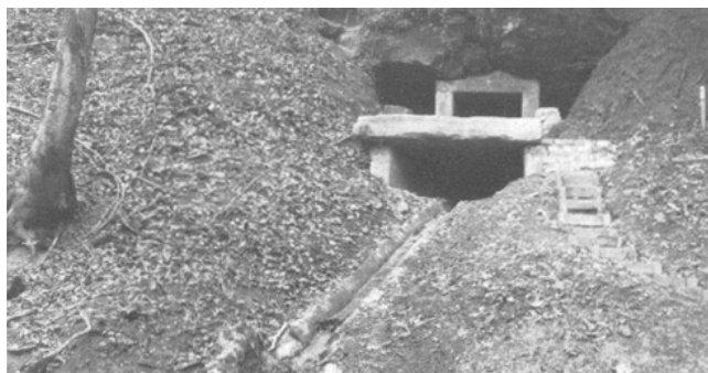
Wülflingen. Chomberg. St. Pirminsbrunnen. Nach der Instandstellung der Quelhöhle 1975.
