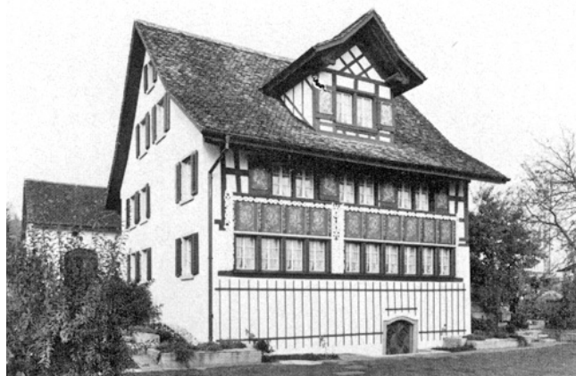
Hombrechtikon. Vorder Ghei. Ehem. Bauernwohnhaus und Wirtschaft «Zum Wiesental», Vers. Nr. 704. Nach der Renovation 1975 (zu S. 90).
