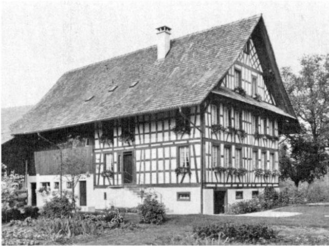
Mettmenstetten, Rossau. Ehem. Bauernhaus Vers. Nr. 121. Nach der Renovation 1975.
