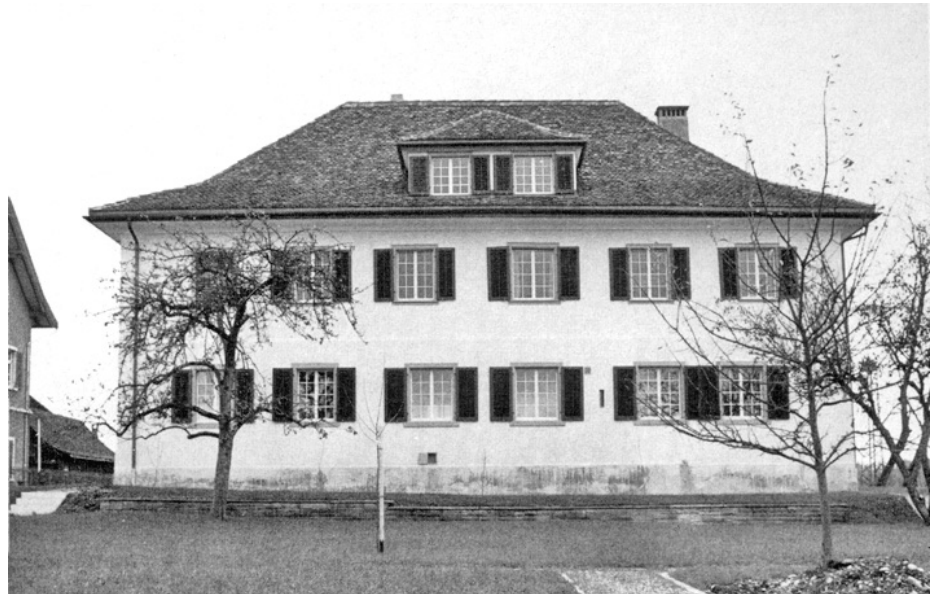
Illnau-Effretikon. Oberillnau. Reformiertes Pfarrhaus. Nach der Renovation 1975/76.
