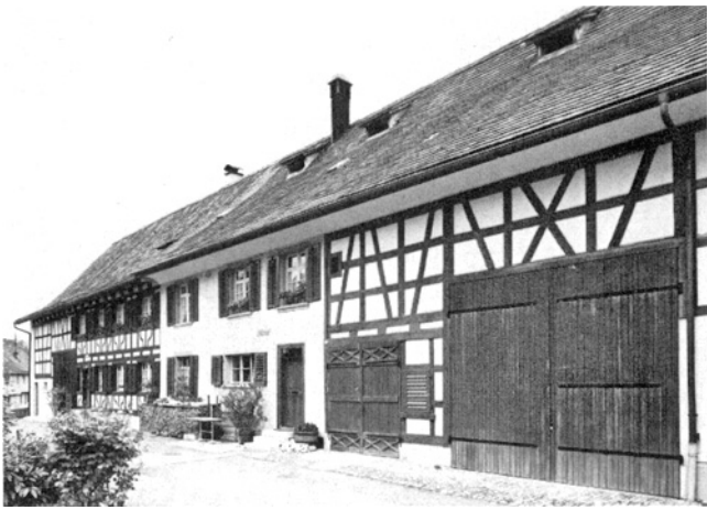
Andelfingen. Ehem. Doppelbauernhaus «Felsenhof» (Vers. Nr. 119/120). Nach der Restaurierung 1976 des Hausteils Vers. Nr. 120 (links).
