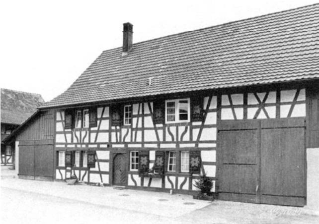
Ossingen. Werdhof. Bauernhaus Vers. Nr. 330. Nach der Aussenrenovation 1975/76.
