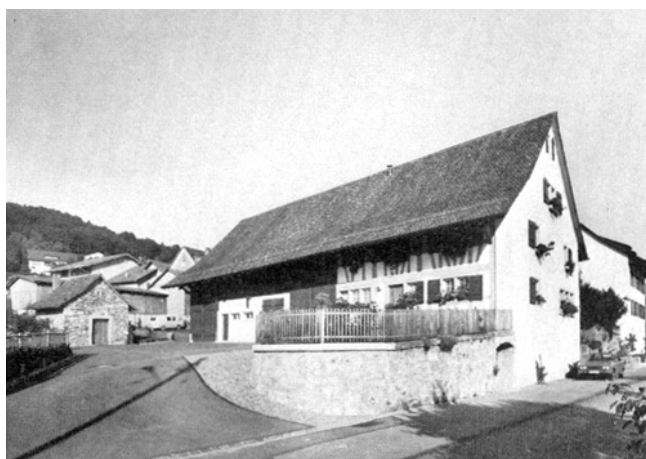
Oetwil a. d. L. Werkhofgebäude «Meierhof» (Vers. Nr. 520). Nach der Restaurierung 1976/77.
