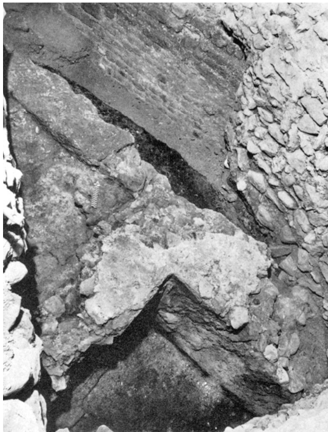
Oberwinterthur. Reformierte Kirche St. Arbogast. Archäologische Untersuchungen 1976/77. Chor. Ostteil. Oben: Kastellmauer von Westen; unten: Nordecke des Hypokaustraumes (Caldarium?) der römischen Thermen.
