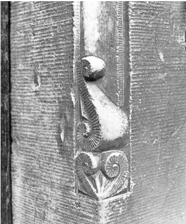
Richterswil, Dorfbachstrasse 52. Haus «Zum Bären» (Vers. Nr. 278). Gewände der Eingangstüre. Detail. Vor der Restaurierung.
