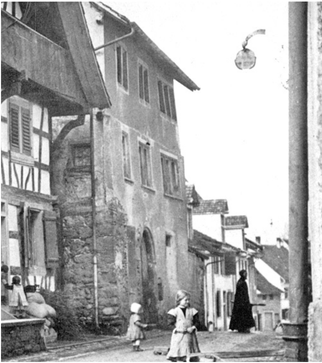
Eglisau. Obergass 46. Ehem. Weinbauernhaus Vers. Nr. 559. Zustand 1929.
