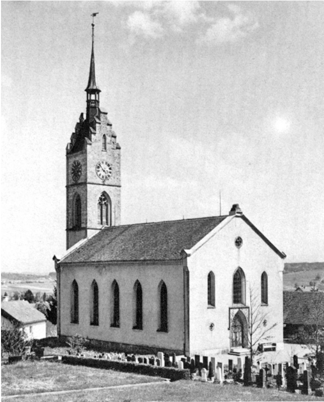
Dielsdorf. Reformierte Kirche. Vor der Renovation von 1955/56.
