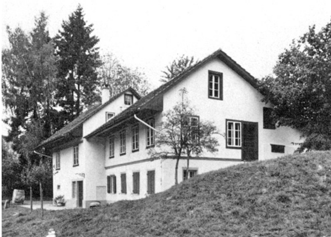
Birmsendorf. Kirchgasse. Ehem. Drechslerei, jetzt Ortsmuseum. Nach der Renovation 1975/76.
