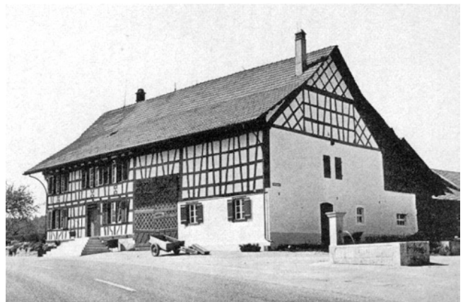
Seuzach, Winterthurerstrasse 26. Bauernhaus Vers. Nr. 56. Nach der Renovation 1974/75.
