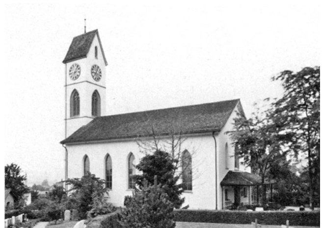
Dielsdorf. Reformierte Kirche. Nach der Aussenrenovation 1975.
