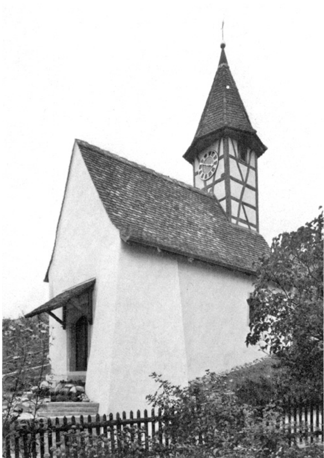
Dachsen. Reformierte Kapelle. Nach der Restaurierung 1975/76.
