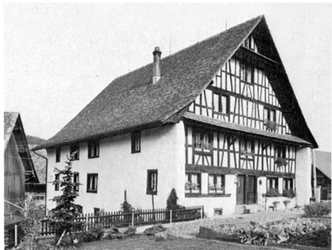
Langnau a. A. Hinteralbis. Doppel-Bauernwohnhaus Vers. Nr. 489/490 (sog. «Nägelihaus»). Nach der Restaurierung 1976.
