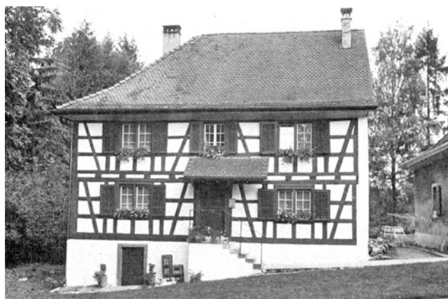
Elgg. Schloss. Wirtschaftshof. Pächterhaus Vers. Nr. 77. Nach der Renovation 1975.
