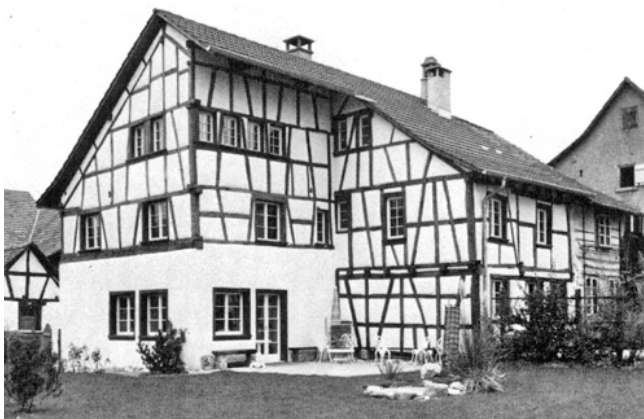
Flurlingen. Rheingässli. Doppelwohnhaus «Im blauen See». Hausteil Vers. Nr. 528. Oben: vor der Restaurierung; unten: nach der Restaurierung 1976.
