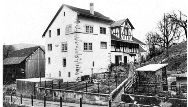
Langnau a. A. «Schloss»-Turm. Oben: vor der Renovation 1931; Unten: nach der Renovation 1931.
