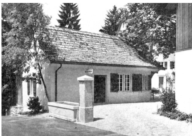
Maur. Burg. Schmiede. Oben: vor der Restaurierung; unten: nach der Restaurierung 1974/75.
