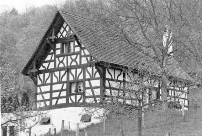
Hüntwangen. Auf Bohl. Ehem. Speicher Vers. Nr. 86. Oben: Zustand 1930; unten: nach Restaurierung und Umbau 1974/75.
