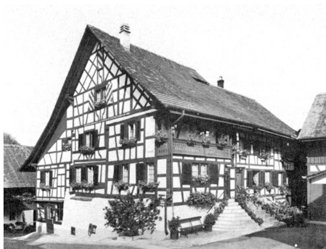
Andelfingen. Schlossgasse. Doppelwohnhaus Vers. Nr. 92/93. Nach der Aussenrestaurierung 1976 des hinteren Hausteiles Vers. Nr. 92.
