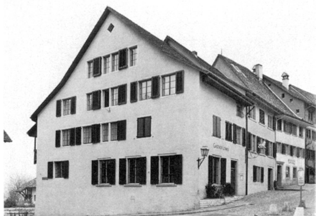
Regensburg. Unterburg. Gasthof «Zum Löwen» (Vers. Nr. 64). Oben: vor Renovation und Umbau; unten: nach Renovation und Umbau 1975/76.
