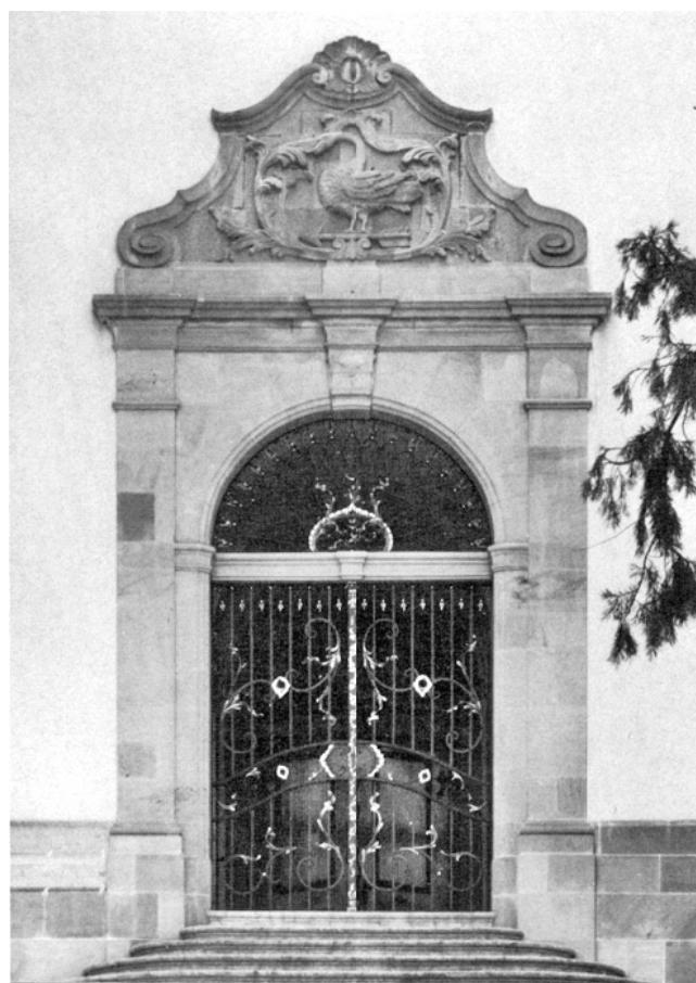
Horgen, Reformierte Kirche. Turmportal. Nach der Restaurierung 1975/76.
