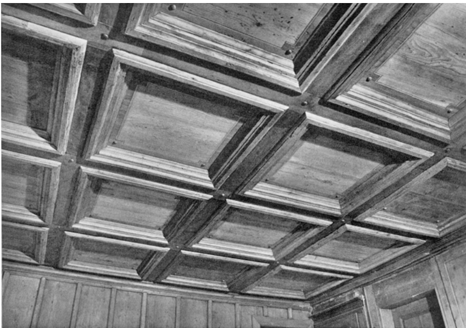
Zollikon. Alte Landstrasse 50. Ehem. Weinbauernhaus Vers. Nr. 429. Kassettendecke in der Wohnstube im Obergeschoss. Nach der Restaurierung 1974.
