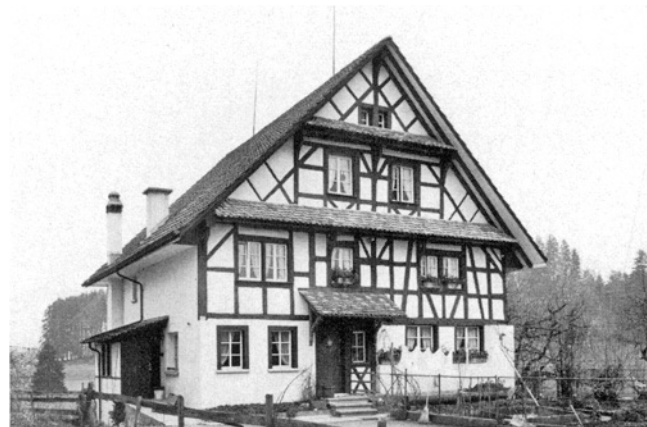
Bubikon. Bürg. Bauernhaus Vers. Nr. 537. Nach der Aussenrenovation 1975.
