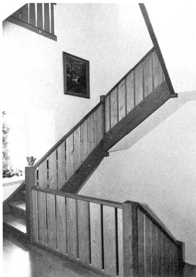
Grüningen. Schloss. Treppenhaus. Nach der Restaurierung 1971–1974.
