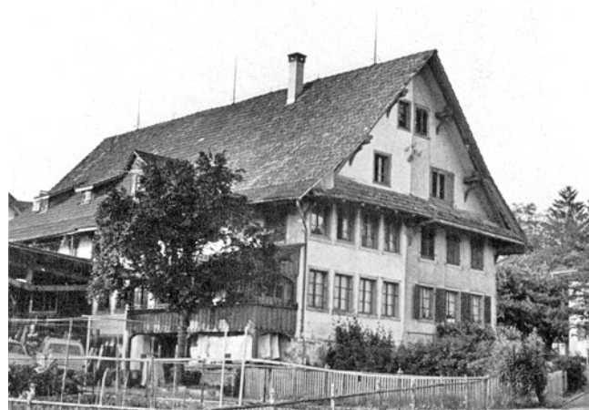
Obfelden. Oberlunnern. Dorfstrasse 85. Doppelwohnhaus Vers. Nr. 272. Abgebrochen 1976.
