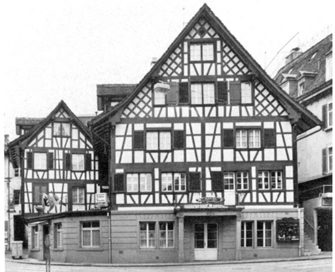
Horgen. Zugerstrasse 20. Restaurant «Freihof», Vers. Nr. 633–636. Nach der Aussenrenovation 1975.
