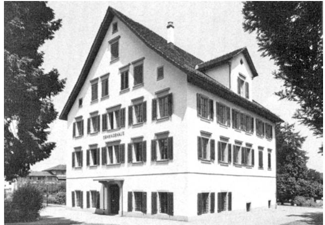
Richterswil. Bahnhofstrasse 47. Gemeindehaus (Vers. Nr. 68). Nach der Aussenrenovation 1975.
