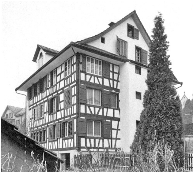
Richterswil. Kirchstrasse 23. Wohnhaus Vers. Nr. 377. Nach der Restaurierung 1975–1977.
