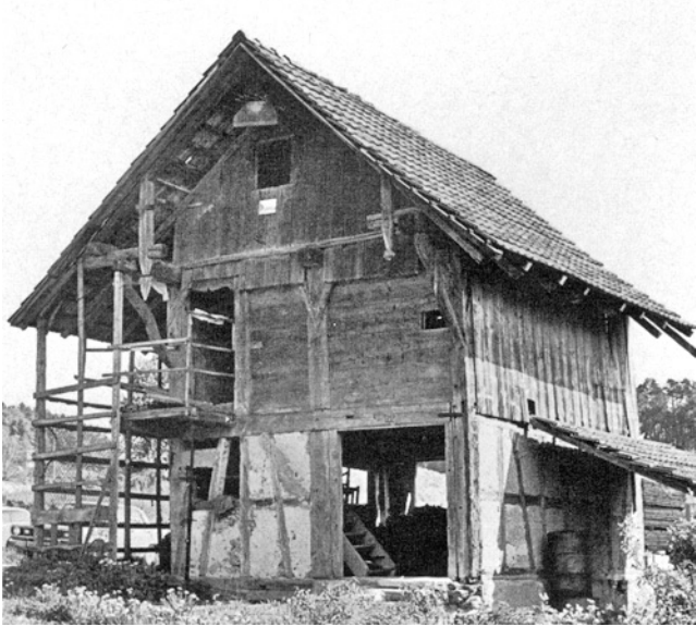
Winkel. Spichergasse. Speicher Nr. 143. Abgebrochen 1975.
