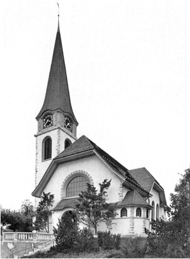
Wallisellen. Reformierte Kirche. Nach der Restaurierung 1975/76.
