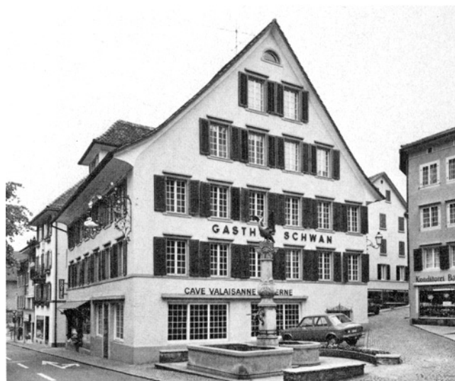
Horgen, Zugerstrasse 9. Hotel «Schwan» (ehem. Gesellenhaus «Zum Schwan»). Nach der Aussenrenovation 1976.
