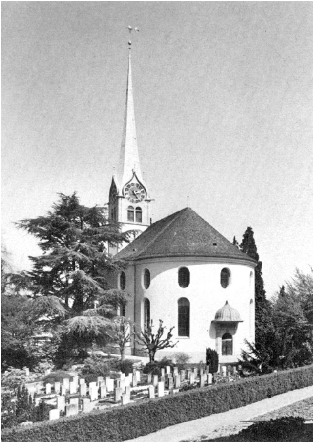
Horgen. Reformierte Kirche. Nach der Restaurierung 1975/76.
