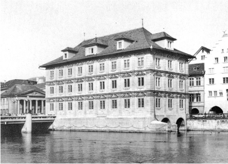
Zürich. Rathaus. Nach der Restaurierung 1974–1977.
