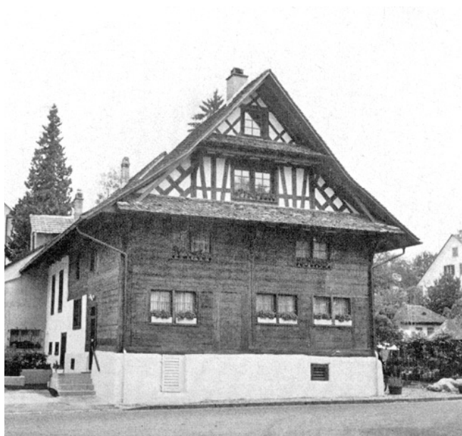
Rifferswil. Ober-Rifferswil. Ehem. Gasthaus «Zum Engel», heute Kirchgemeindehaus (Vers. Nr. 138). Oben: vor der Restaurierung; unten: nach der Restaurierung 1974/75.
