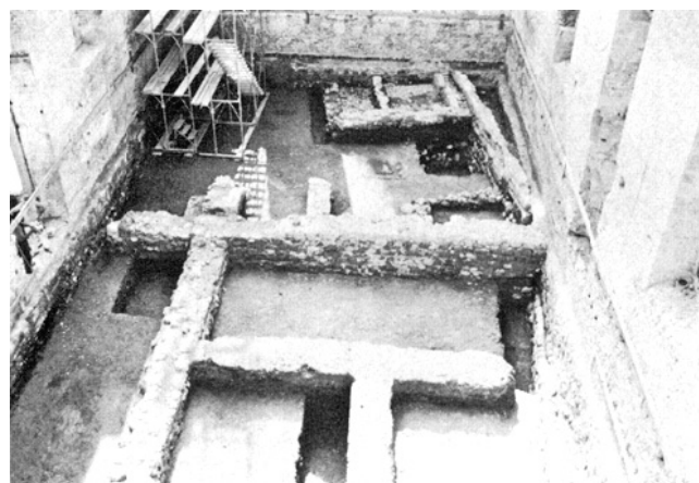
Grüningen. Reformierte Kirche. Archäologische Untersuchungen 1975. Gesamtansicht aus Osten.
