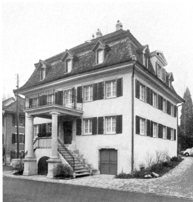
Wädenswil. Friedbergstrasse 7. Haus «Zum Friedberg» (Vers. Nr. 311 Nach der Restaurierung 1975.
