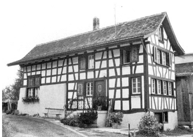
Pfäffikon. Vorder-Balm. Bauernwohnhaus Vers. Nr. 358. Nach der Restaurierung 1973–1975.
