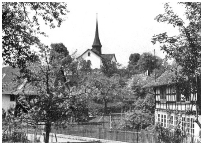
Zürich. Witikon. Alte Reformierte Kirche. Nach der Renovation 1939/40.
