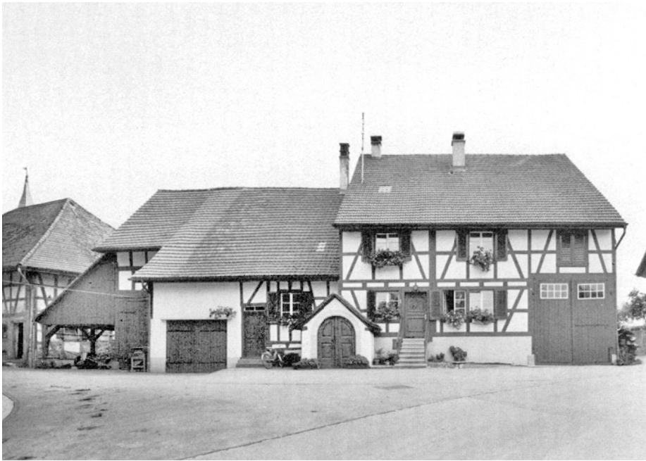
Ossingen. Hausen. Doppelbauernhaus Vers. Nr. 319/320. Nach der Renovation 1976.
