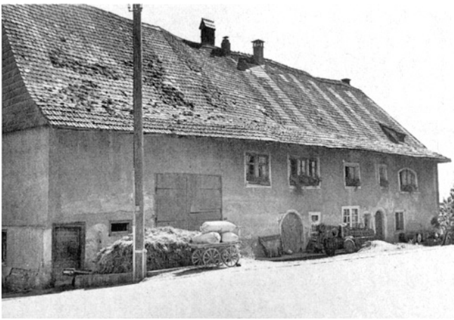
Laufen-Uhwiesen. Uhwiesen. Bauernhaus «Zum Rebstock» (Vers. Nr. 76). Vor der Renovation.
