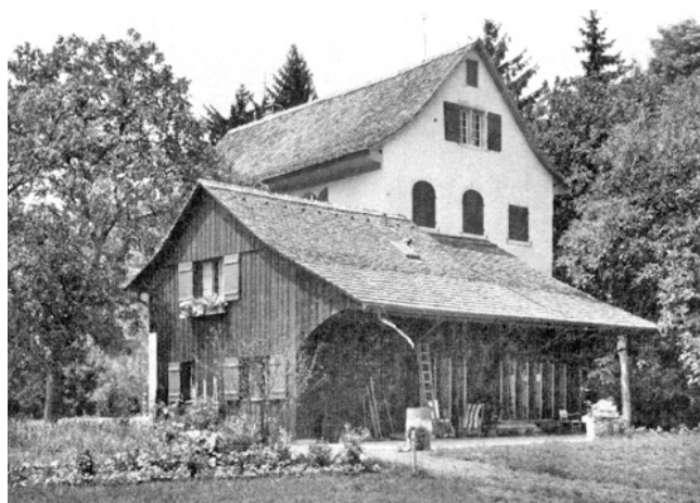
Maur. Burg. Nordseitiger Anbau. Nach der Restaurierung 1974/75.
