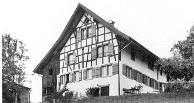
Dürnten. Oberdürnten. Ehem. Bauernhaus «Absägete» (Vers. Nr. 11). Nach Renovation und Umbau 1974/75.
