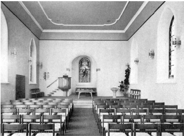
Glattfelden. Reformierte Kirche. Inneres. Ansicht gegen Chor. Oben: vor der Restaurierung; unten: nach der Restaurierung 1975/76.
