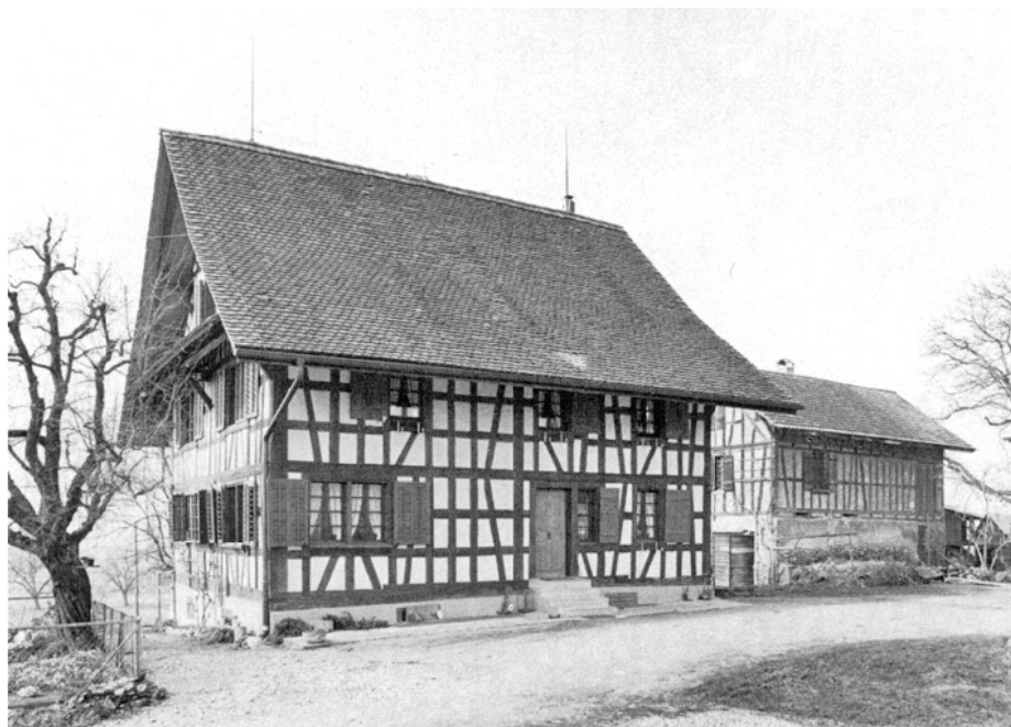
Maschwanden. Feld. Bauernwohnhaus Vers. Nr. 170. Nach der Renovation 1973–1975.
