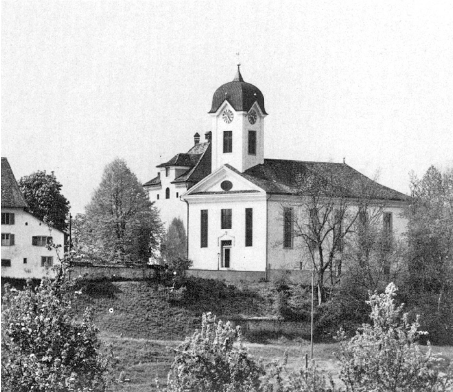
Grüningen. Reformierte Kirche. Nach dem Wiederaufbau 1975– 1977.
