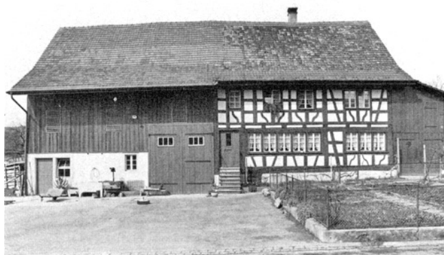
Dägerlen. Rutschwil. Bauernhaus Vers. Nr. 100. Nach der Aussenrenovation 1975.
