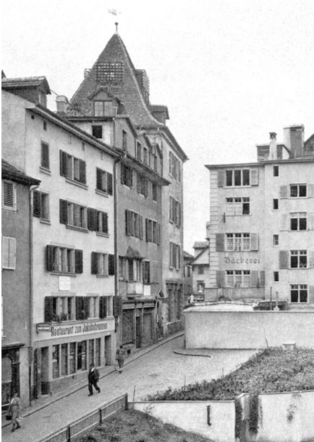
Spiegelgasse 14. «Jakobsbrunnen.» a) Altbau; b) Erdgeschosszone des Neubaus.
