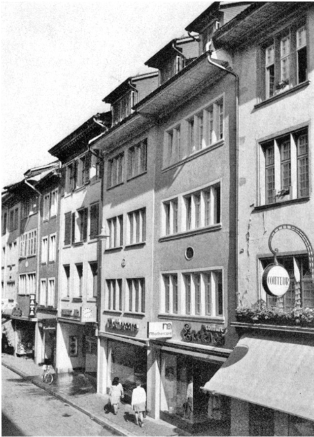
Winterthur. Altstadt. Marktgasse 32/34. Fassaden nach Umbau und Renovation.
