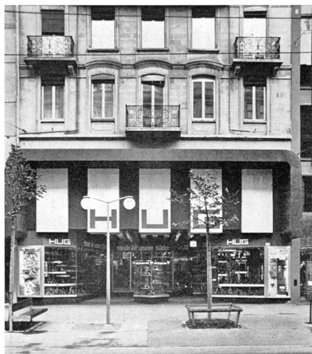
Bahnhofstrasse 76. Neue Erdgeschosszone.
