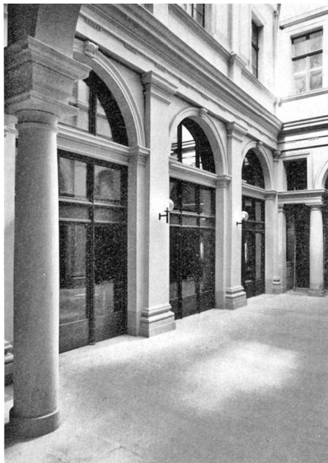
Winterthur. Altstadt. Rathaus. Der Lichthof nach der Restaurierung 1968/70.
