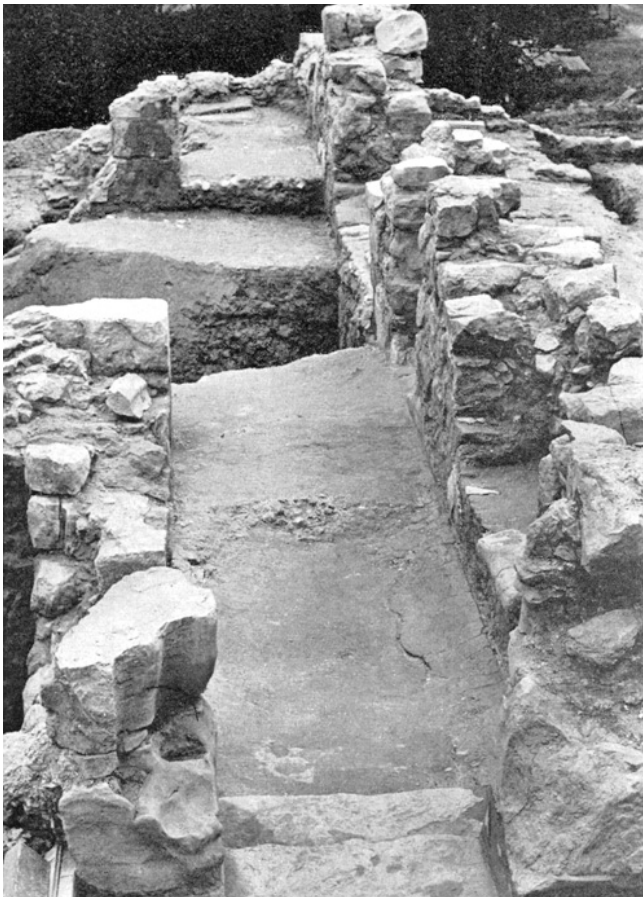
Winterthur. Wülflingen. Beerenberg. Ehemaliges Kloster Mariazell. Archäologische Untersuchung 1970/73. Kirche. Korridor zwischen Lettner und Chor. Blick gegen Süden.
