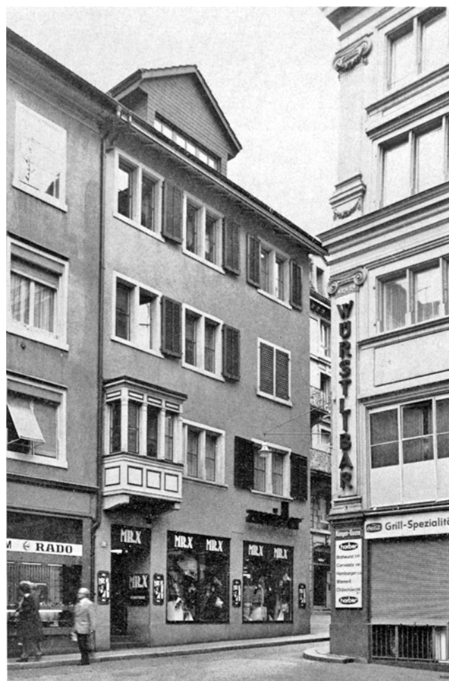
Niederdorfstrasse 20. Nach der Renovation.
