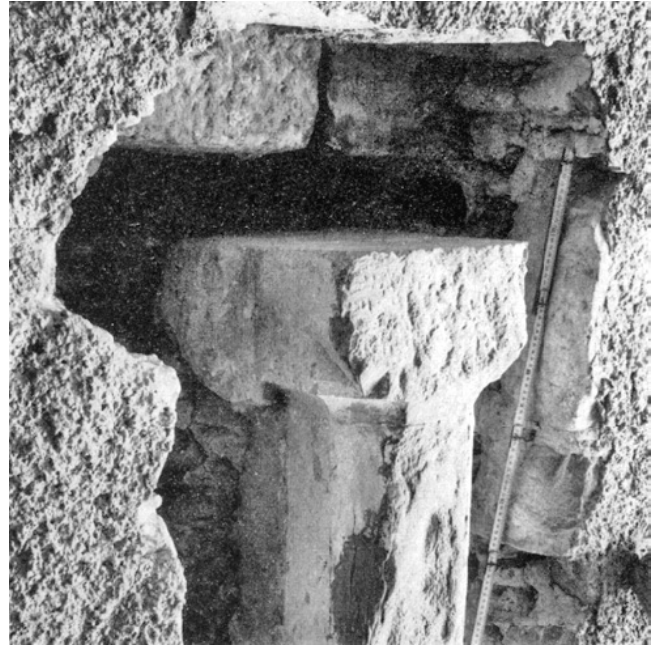
Winterthur. Altstadt. Rathaus. Durchgang – Südteil. Ostwand. Kapitell einer gotischen \frac{3}{4} -Säule, während der Restaurierung 1968/70.
