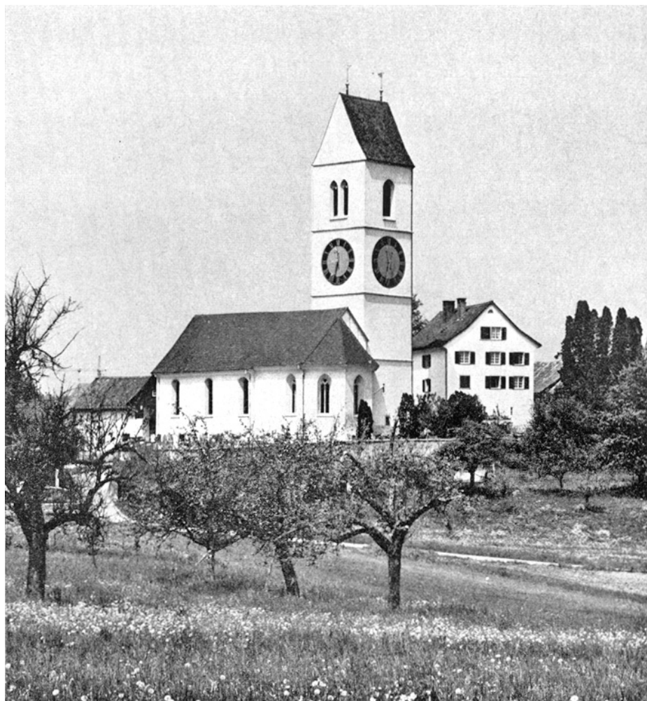
Dinhard. Reformierte Kirche mit Pfarrhaus. Ansicht aus Südosten.
