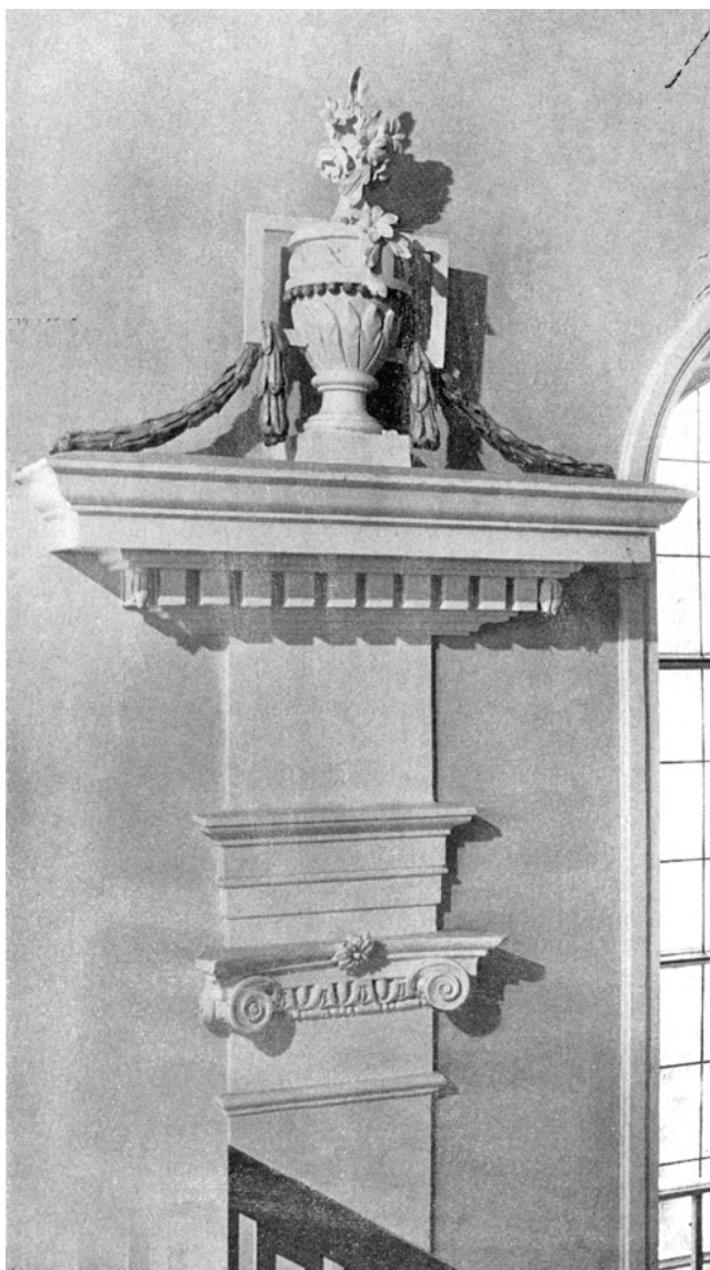
Gossau. Reformierte Kirche. Oberteil eines Pilasters nach der Restaurierung 1970.
