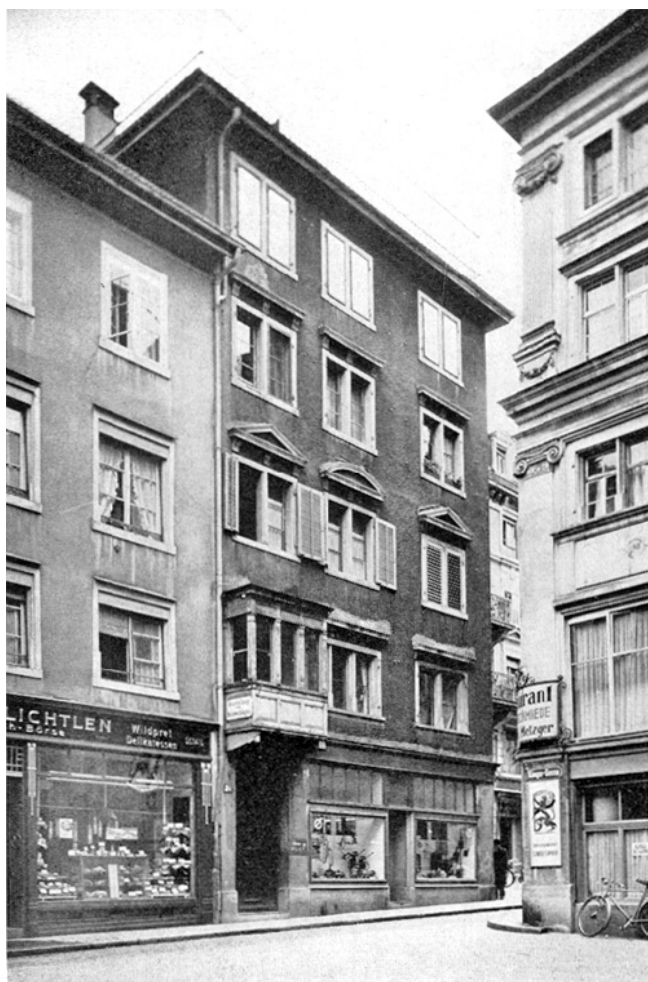
Niederdorfstrasse 20. Vor der Renovation.
