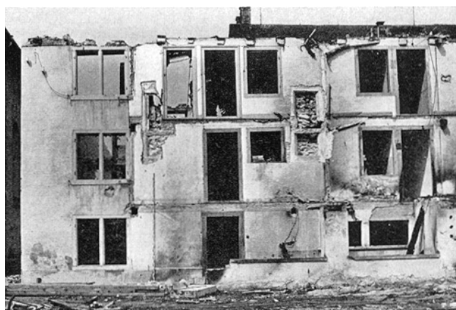
Rüti. Ehemaliges Klosterareal. Schütte. Ostfassade mit gotischen Fenstergewänden, während des Abbruches im Mai 1970.
