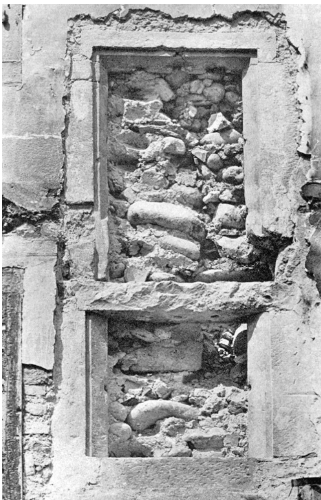
Rüti. Ehemaliges Klosterareal. Schütte. Aus der Ostfassade mit gotischen Fenstergewänden, während des Abbruches im Mai 1970.
