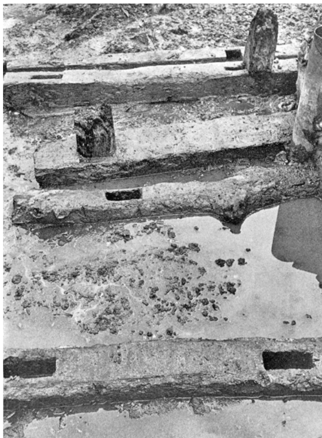
Pfäffikon. Burgwies. Ehemalige Wasserburg. Unterbau der Brücke bei der Nordwestecke der ehemaligen Burgmauer aus Süden.
