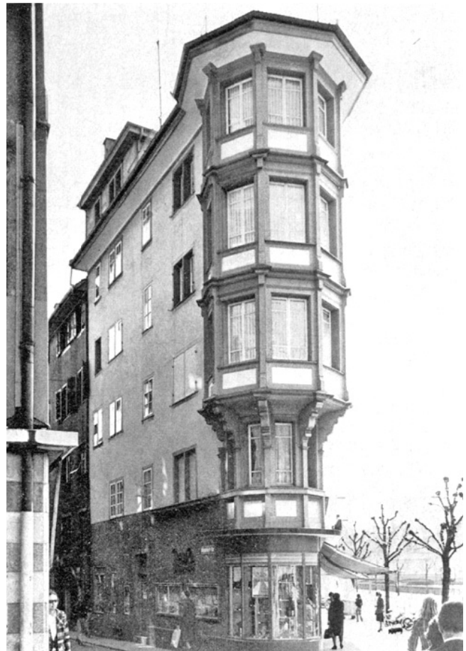
a Limmatquai 140/Niederdorfstrasse 77. «Brotkorb.» a) Ansicht gegen die Niederdorfstrasse, heutiger Zustand; b) «Plan zu einem neuen Wohngebäude beym Durchbruch im Niederdorf in die neue Quai-Strasse » von W. Waser, 1856.
