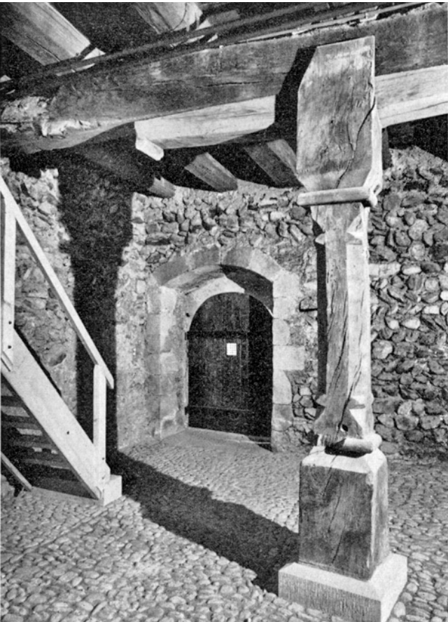
Küsnacht. Höchhus. Quadratischer Turm. Erdgeschoss. Nach der Restaurierung 1972/74.
