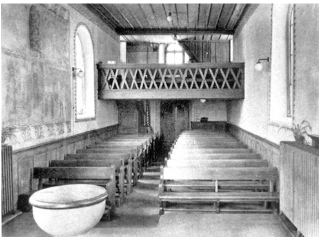
Illnau-Effretikon. Rikon. Kapelle. Inneres vor der Restaurierung 1970/71. Blick gegen Westen.
