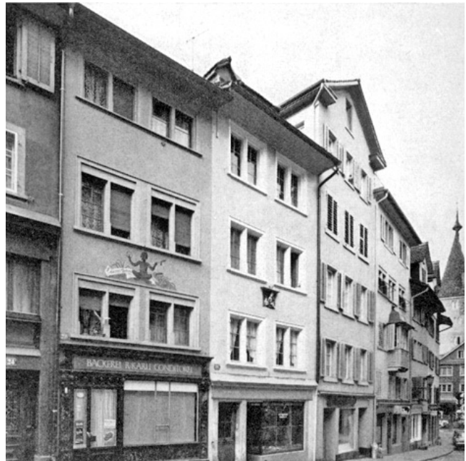
Neumarkt 10–22. Ansicht nach der Fassadenrenovation.
