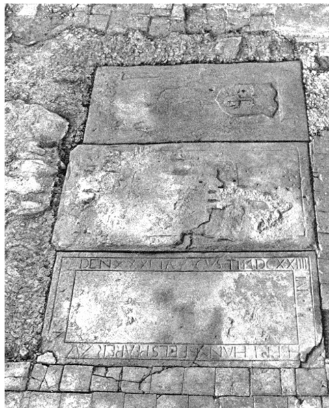
Dinhard. Reformierte Kirche. Archäologische Untersuchung 1971. Chor. Mittelteil des alten Bodens mit Grab 2 (mit Inschrift), Grab 3 (unleserlich), Grab 4 (Wappen). Ansicht aus Norden.
