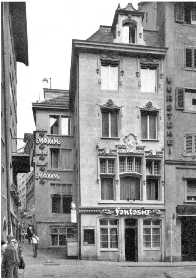
Schoffelgasse 2. «Henne.» Nach der Renovation.
