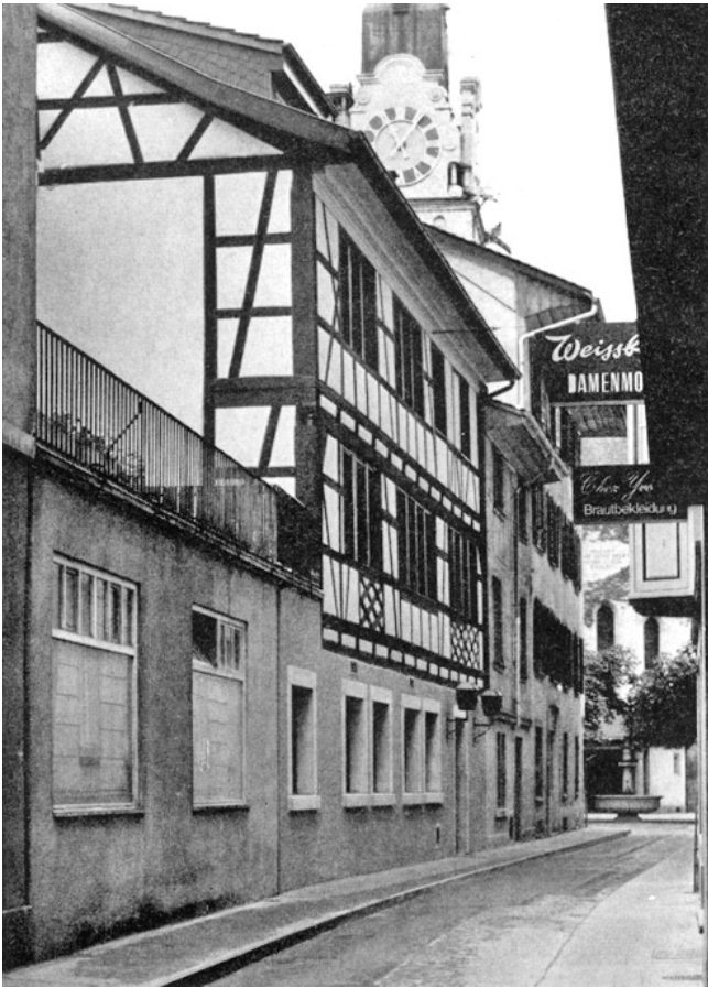
Winterthur, Altstadt. Schulgasse 3. Renovierte Riegelfassade.
