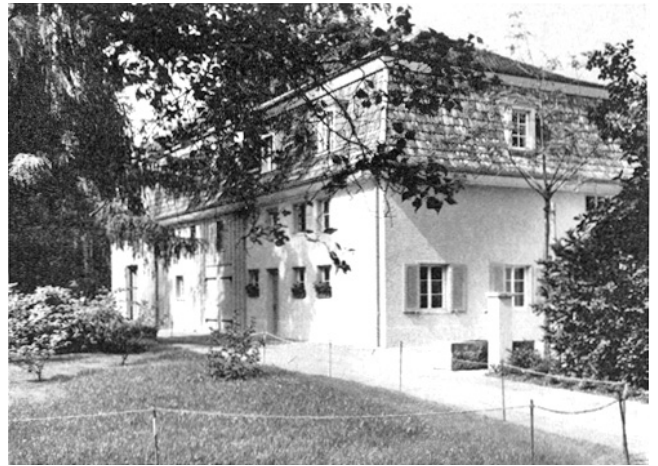
Winterthur. Römerstrasse. «Lindengut.» Ehemaliges Kutscherhaus. Nach der Restaurierung 1971/72. Von Süden.
