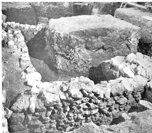
Andelfingen. Reformierte Kirche. Archäologische Untersuchung 1969. Kirchenschiff-Südteil. Mitte: Die Mauer des Beinhauses von Osten.
