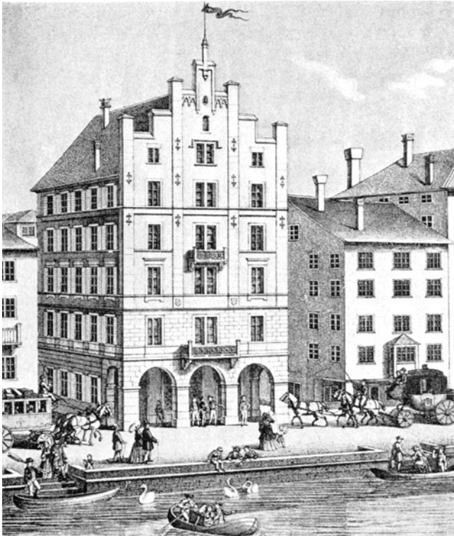
Limmatquai 72. «Schweizerhof.» a) Ansicht gegen den Limmatquai kurz nach Inbetriebnahme des Hotels; b) heutiger Zustand.
