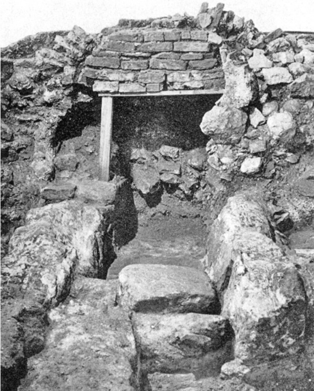
Winkel. Seeb. Römischer Gutshof. Herrenhaus A. Westflügel. Nordwestteil. Präfurnium P 1 mit der zugemauerten Mörtel-einfassung für die sogenannte Testudo (Heizkessel). Aus Südosten.
