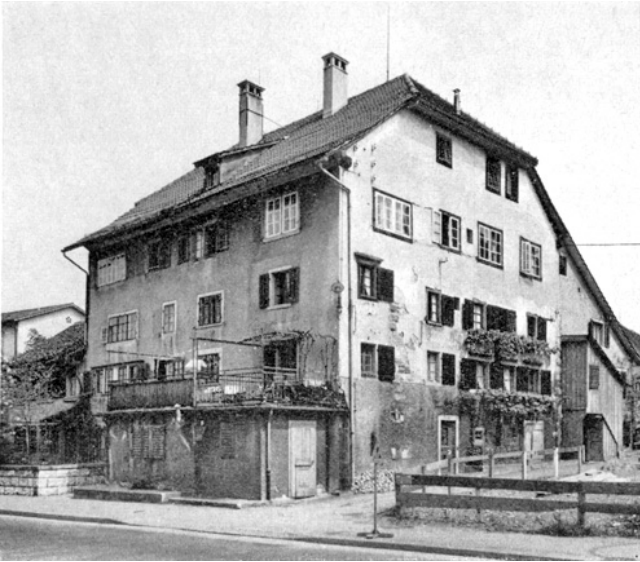
Küsnacht. Höchhus. Äusseres vor der Restaurierung 1972/74. Ansicht aus Südwesten.
