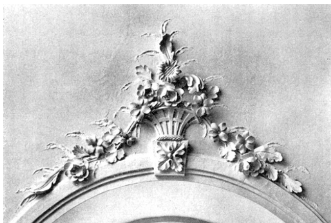
Gossau. Reformierte Kirche. Fensterbogen mit Stuckdekor nach der Restaurierung 1970.
