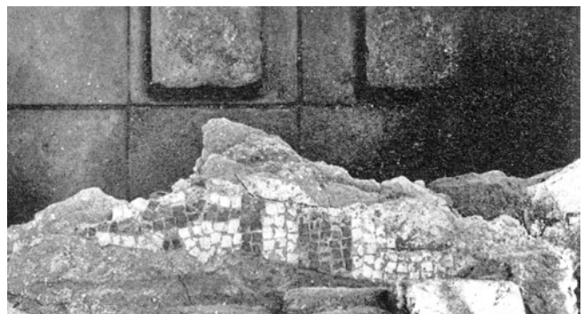
Winkel. Seeb. Römischer Gutshof. Herrenhaus A. Westflügel. Mosaikfragment im östlichen Caldarium (F 4z/R IV) in situ, von oben.
