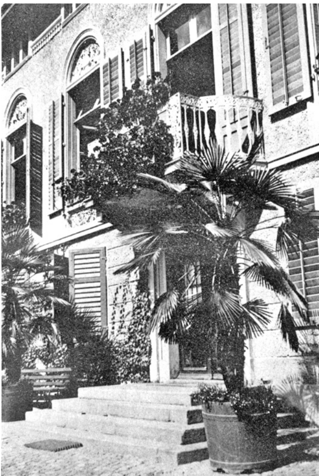
Bassersdorf, Baltenswil. Ehemaliger Gasthof «Zum Schwanen». Der Haupteingang vor Entfernung des originalen Balkongitters im Jahr 1954.
