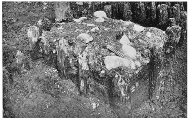
Pfäffikon. Burgwies. Ehemalige Wasserburg. Pfostenrost des nördlichen Burgmauerabschnittes vor endgültiger Freilegung der Pfähle.
