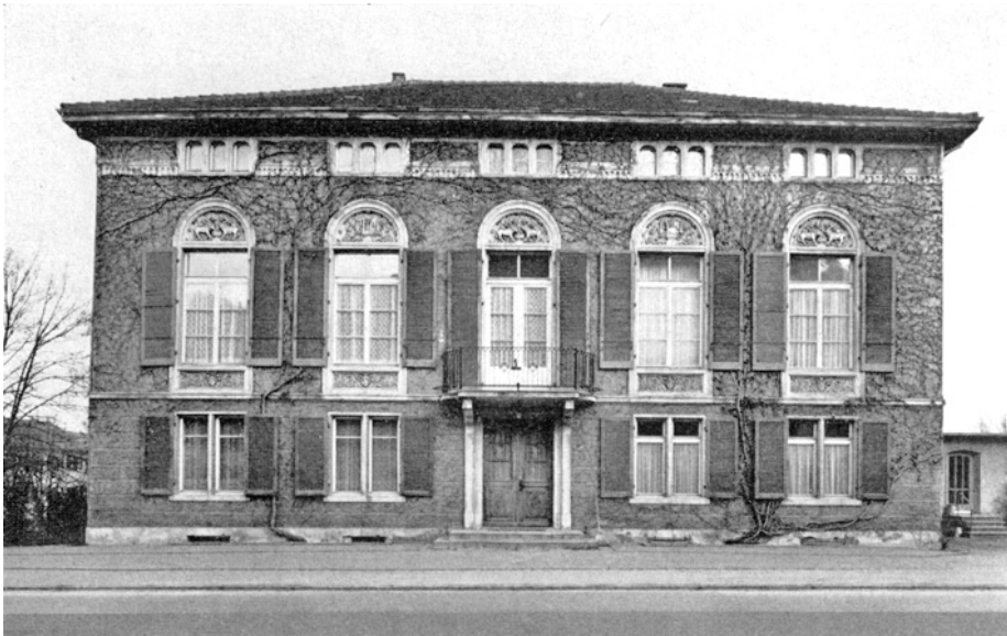
Bassersdorf. Baltenswil. Ehemaliger Gasthof «Zum Schwanen». Strassenfassade vor der Restaurierung.
