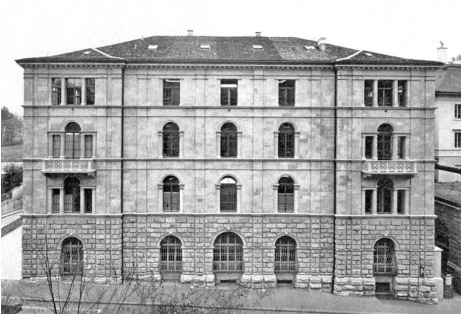
Zürichbergstrasse 8. «Oberer Sonnenbühl.» Gerichtlich-medizinisches Institut der Universität. Strassenfassade nach der Restaurierung 1973/74.
