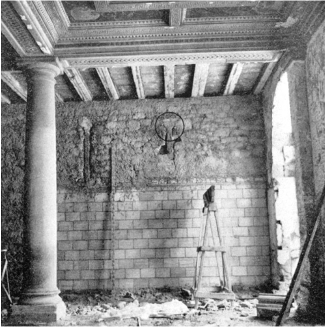
Winterthur. Altstadt. Rathaus. Durchgang – Südteil. Ostwand mit Resten gotischer Wandsäulen, während der Restaurierung 1968/70.
