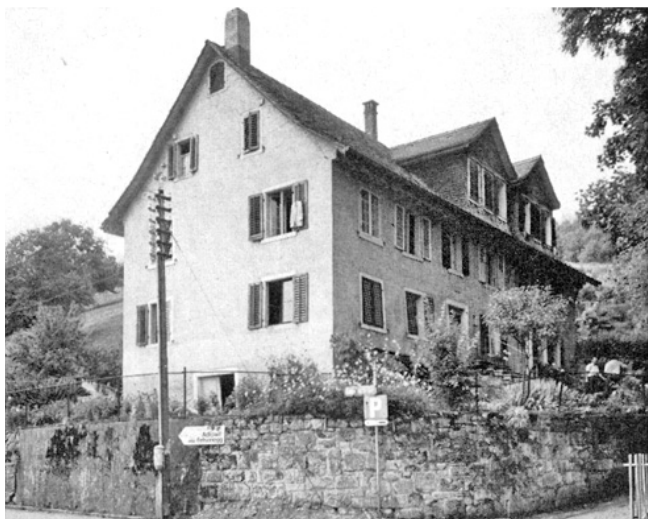
Risweg «Im Hüsi.» a) Alter Zustand; b) Zustand nach der Renovation.
