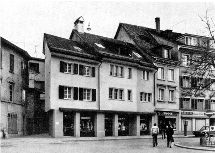
Winterthur, Altstadt. Graben 38/42. Sanierte und renovierte Häuser.
