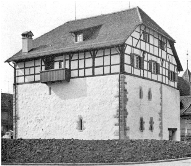
Küsnacht. Höchhus. Äusseres nach der Restaurierung 1972/74. Ansicht aus Nordosten.
