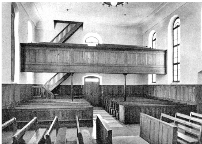
Henggart. Reformierte Kirche. Inneres vor der Restaurierung 1971/72. Blick gegen Westen.
