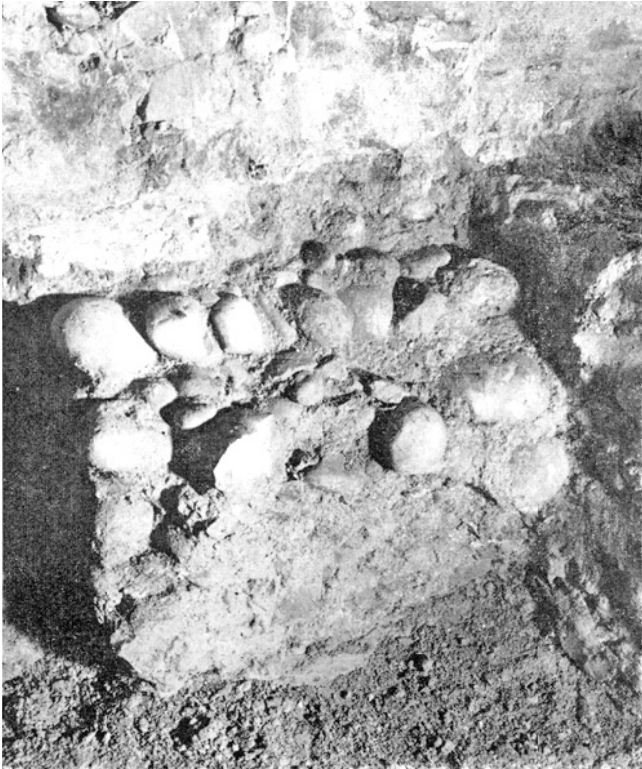
Eglisau – Reformierte Kirche. Fundamentrest der Nordmauer des romanischen Turmes, von Westen gesehen.
