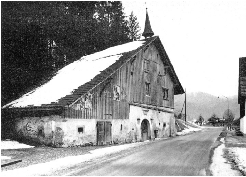
Zell – Rikon. Sogenannte «Zehntenscheune». Zustand vor der Restaurierung von 1960/61.
