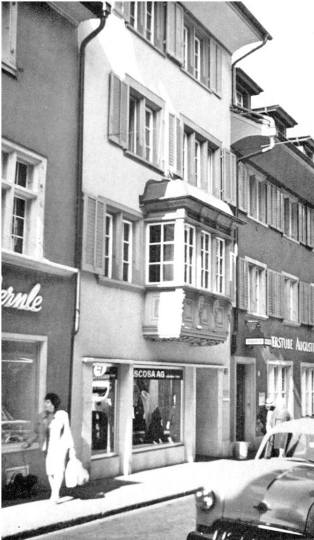
Augustinergasse 25, zum untern Kürass. Aussehen nach dem Umbau.
