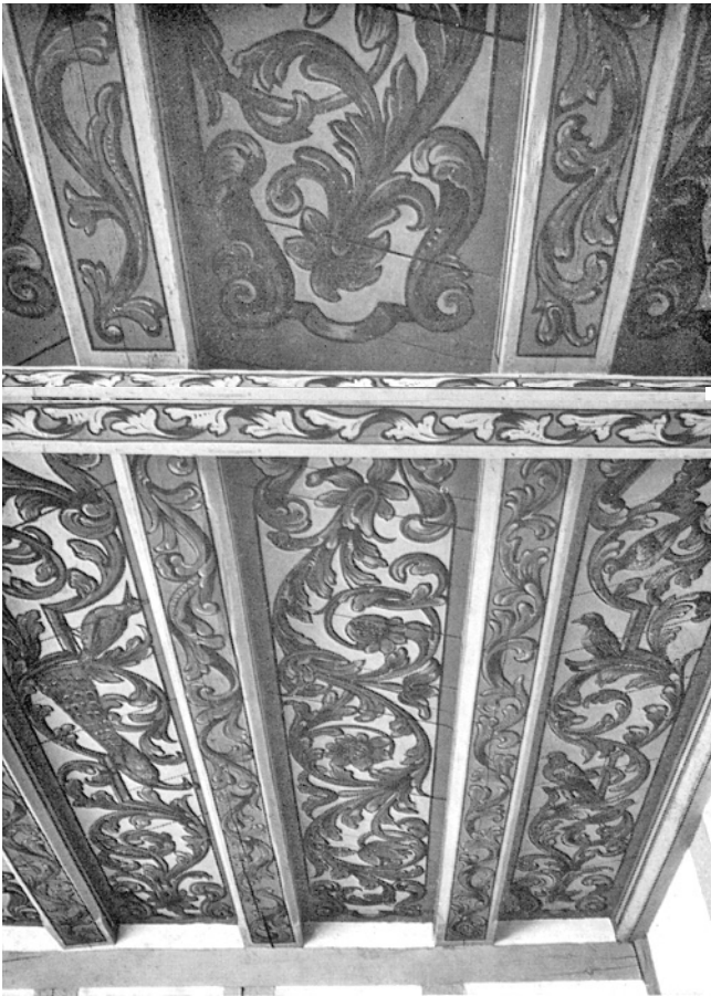
Meilen – Kirchgasse. Haus zum «Bu» (Bau). Die bemalte Holzdecke in der Wermüller-Stube nach der Restaurierung von 1960/61.
