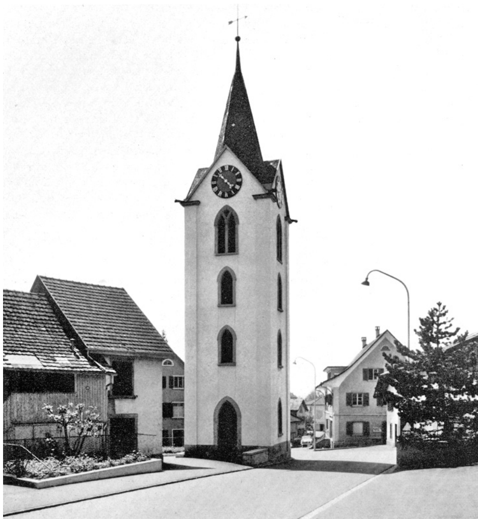
Wallisellen – Rieden. Riedenerstrasse: Turm von 1866, aus Norden.
