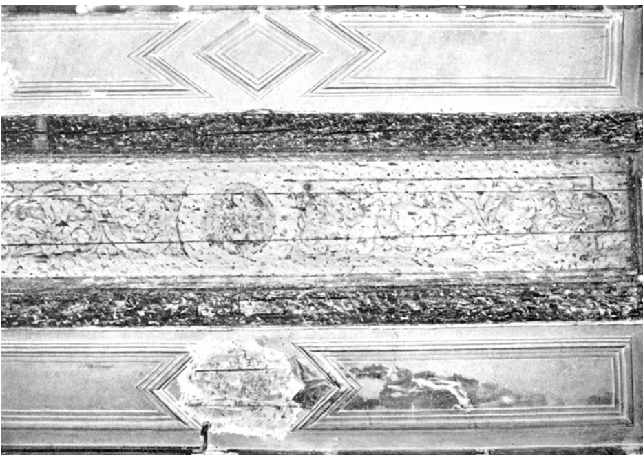
Augustinergasse 19, zum obern Kürass. Stuckierte Balkendecke von 1676 und Reste einer früheren Bemalung mit Ranken.
