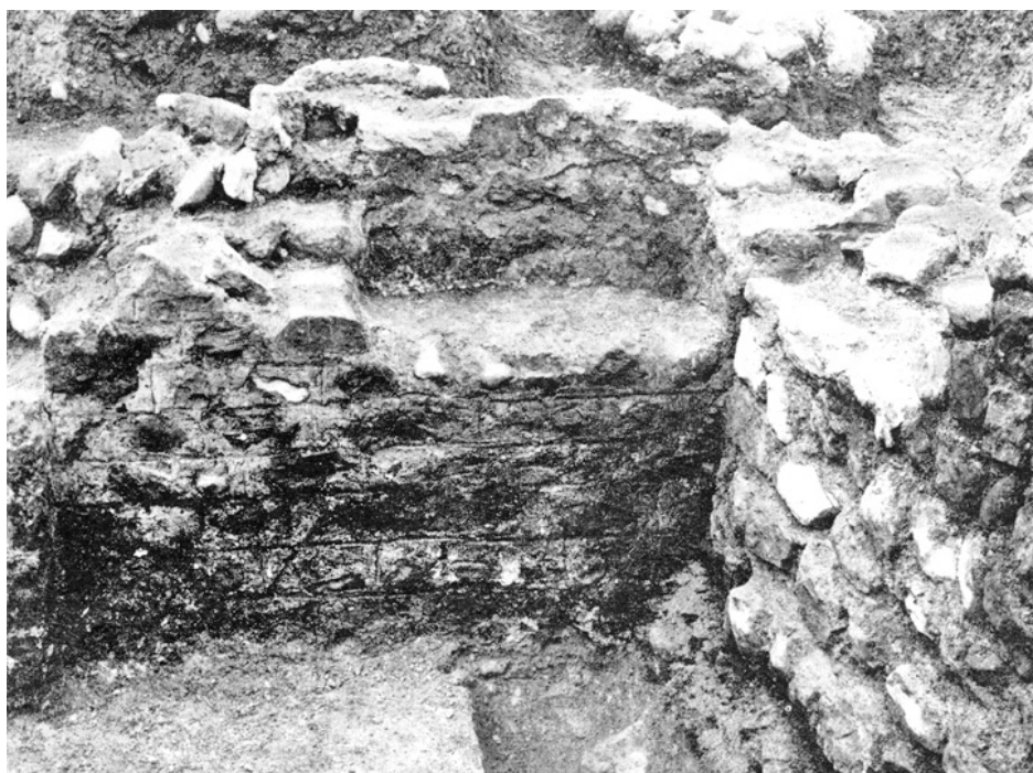
Altstetten, Loogarten, römischer Gutshof. Der Keller des Herrenhauses, Mauerdetail mit Fugeisenstrich bei der Westecke.
