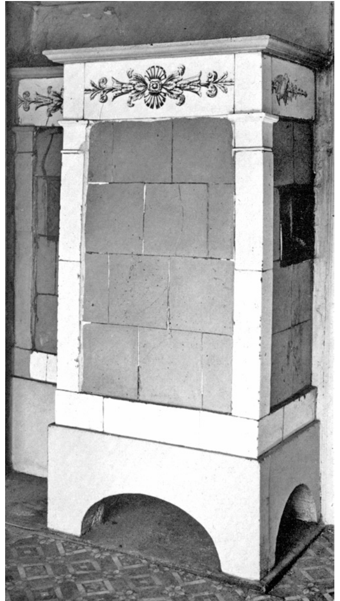
Froschaugasse 24. Ofen, der aus verschiedenen Resten älterer Öfen zusammengestückt wurde.
