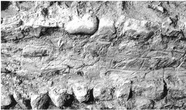
Mettmenstetten – Reformierte Kirche. Teil des aufgehenden Mauerwerkes der Ostmauer des romanischen Rechteckchores. Pietra rasa-Verputz mit Fugeisenstrichen, von Osten.
