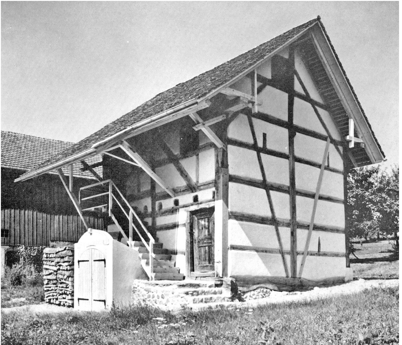
Höri – Oberhöri. Alter Speicher nach der Restaurierung von 1961.
