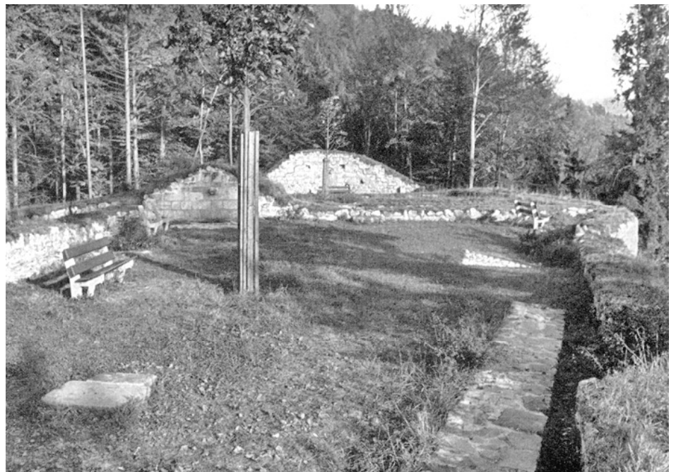
Bauma – Alt-Landenberg. Die Burg- ruine nach der Konservierung von 1958 bis 1961. Blick gegen Osten, links in der Mitte die Rückseite des Sodbrunnens.
