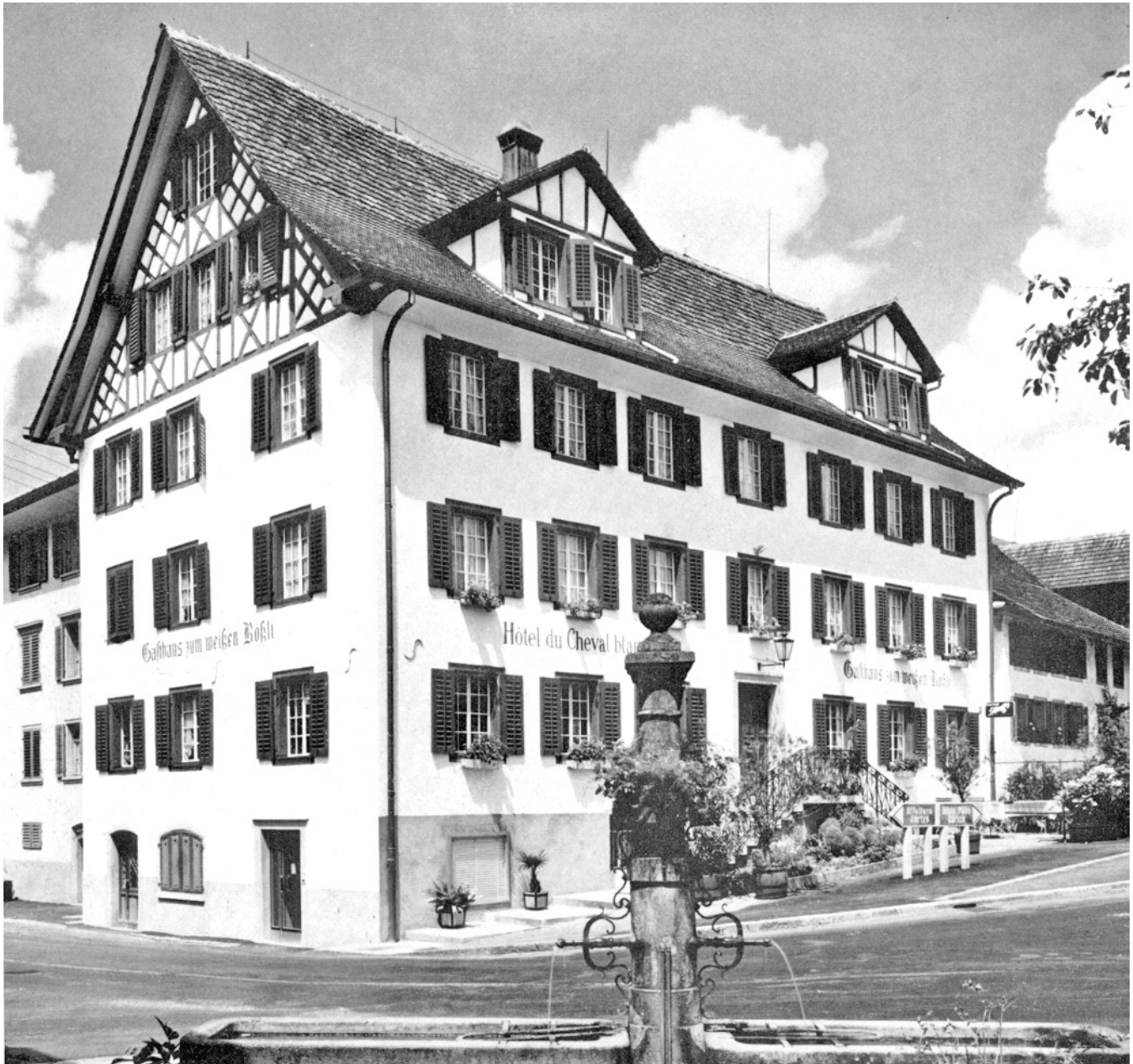
Mettmenstetten – Gasthaus zum «Weissen Rössli», nach der Aussenrenovation von 1960.
