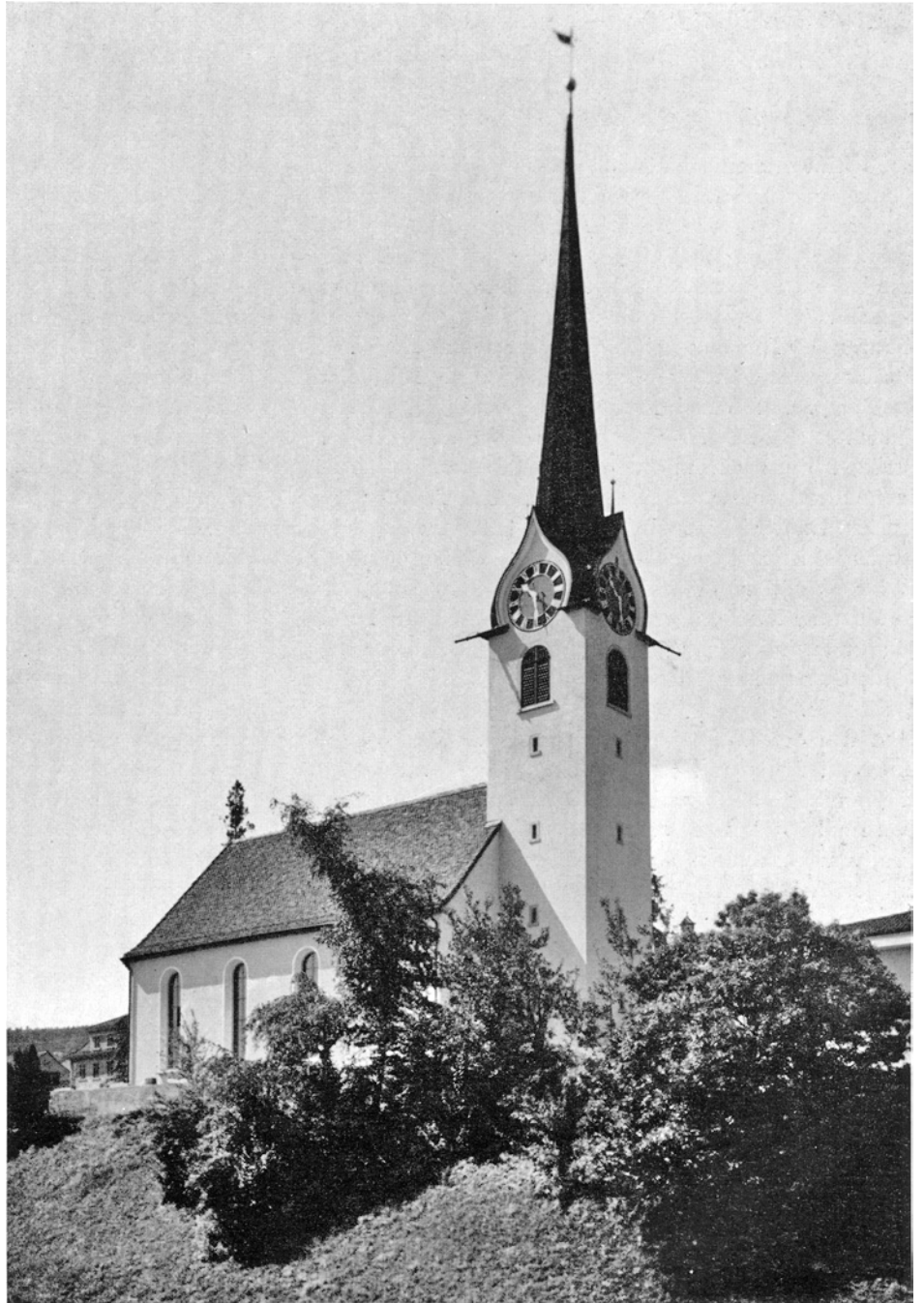
Oberrieden – Reformierte Kirche, nach der Gesamtrenovation von 1961/62, aus Norden.
