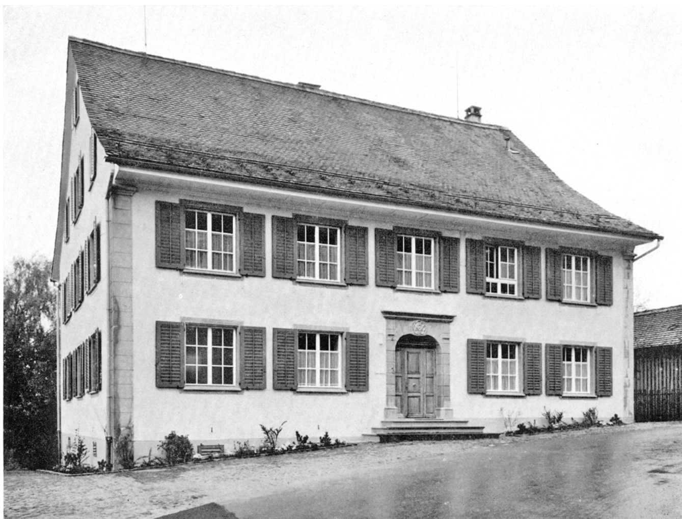
Lindau – Pfarrhaus, nach der Gesamtrenovation von 1960/61. Strassenfassade.
