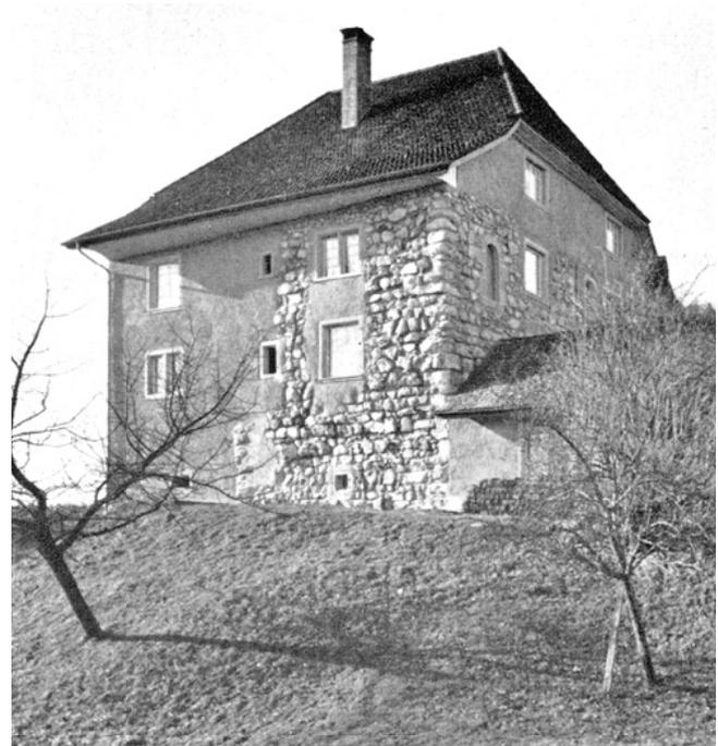
Gewände aus recht gut zubehauenen Sandsteinquadern konstruiert worden ist. Auf der Innenseite war noch der Balken, mit dem die Tür verrammt werden konnte, vorhanden. Die Mauern sind rund 2 Meter dick, die Aussenmasse des Turmes betragen rund  $8 \times 8$  Meter, und bei der Nordwestecke misst man ab äusserem Bodenniveau bis zur heutigen Oberkante der Mauer noch immer 9 Meter. Das Kellerniveau liegt bloss 1 Meter tiefer als die heutige Oberfläche des angrenzenden Umgeländes.
