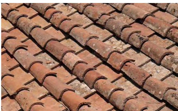
Dachausschnitt mit Klosterziegeln (Abb. 8)
