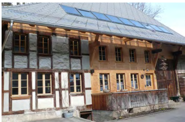
Indachmontage, Band mit Kollektoren und Dachflächenfenstern, Gebäude an der Mühlestrasse in Münsingen (Abb. 29)
