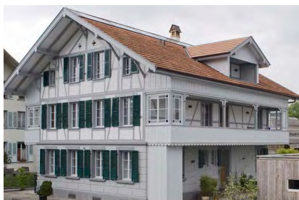
Wohnhaus in Münsingen: Montage am First (Abb. 34)
