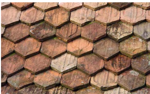
Ausschnitt Biberschwanzziegeldach Doppeldeckung (Abb. 7)
