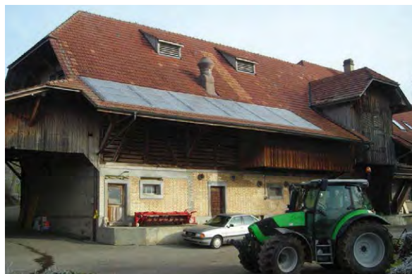
Bauernhaus (Vielzweckbau): Kollektoren im Bereich des Ökonomieteils und in Traufnähe (Abb. 32)
