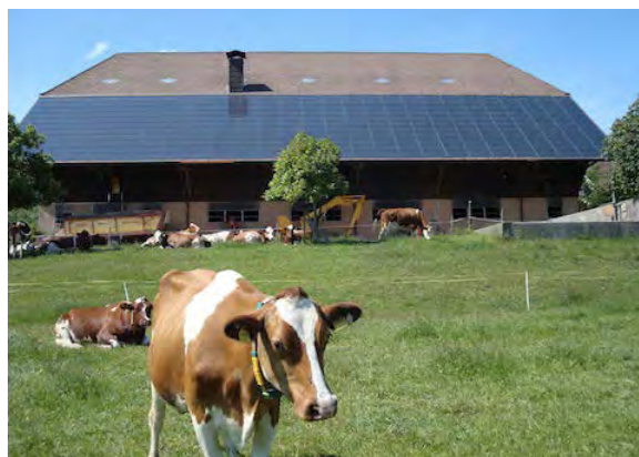
Grosse Scheune in einem bernischen Weiler. Lamine ersetzen die Ziegel der unteren Dachschildehälfte. Dieser Dachteil wirkt ruhig und einheitlich wie ein Dachbelag. Allerdings bildet sich ein grosser Farbkontrast, der obere und untere Dachhälfte optisch in zwei Teile trennt. Hofen, Photovoltaikanlage auf Scheunendach (Abb. 38)
