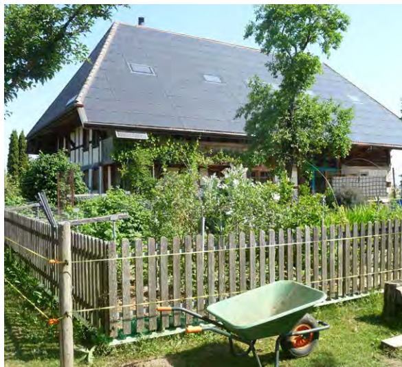
Materialersatzkonzept mit Voltaiklaminaten, ehem. Bauernhaus in Schüpfenried, Uetligen, Solarpreis 2009 (Abb. 37)
