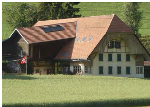
Kollektorenfeld für Warmwasseraufbereitung am untergeordneten Bauteil Hocheinfahrt, Bauernhaus in Hub, Gemeinde Krauchthal (Abb. 28)
