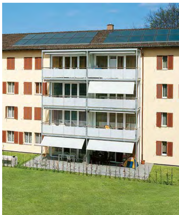
Indach-Kollektoren für Warmwasseraufbereitung der MFH Wohnbaugenossenschaft Bavariabach, St. Gallen (Abb. 31)
