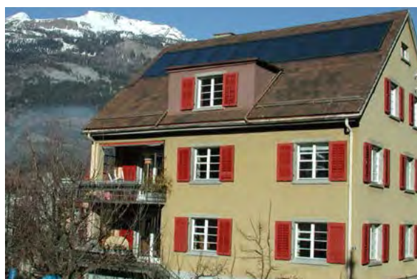
Zweifamilienhaus in Chur: Montage unterhalb des Firsts (Abb. 35)
