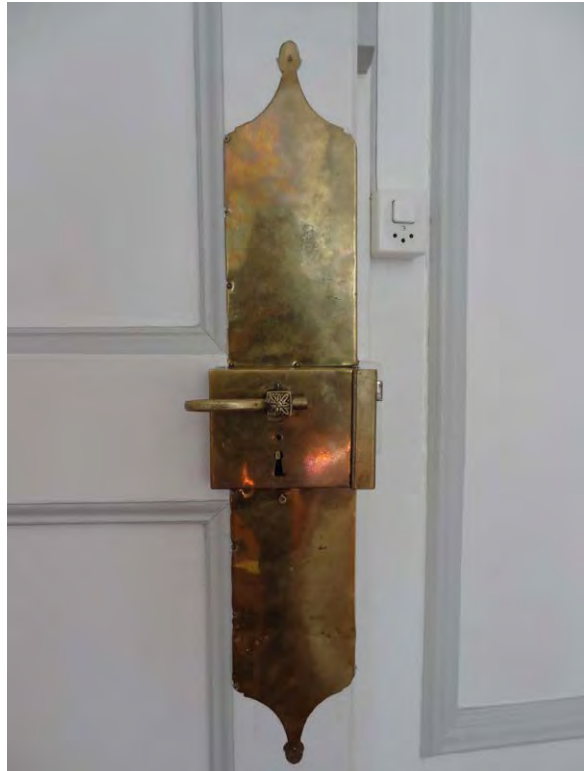
Klassizistisches Kastenschloss mit Langschild (Abb. 38)
