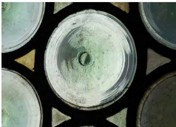
Detail einer Butzenscheibe mit mittiger Butze (Abb. 15)
