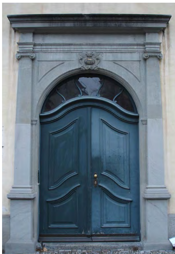
Haus zum Kiel, Zürich, barockes Eingangsportal mit gestemmten Türflügeln (Abb. 36)
