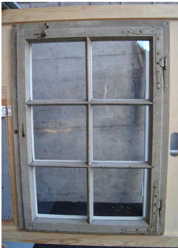
Musterfensterflügel mit Aussendoppel: Innenansicht (Abb.22)
