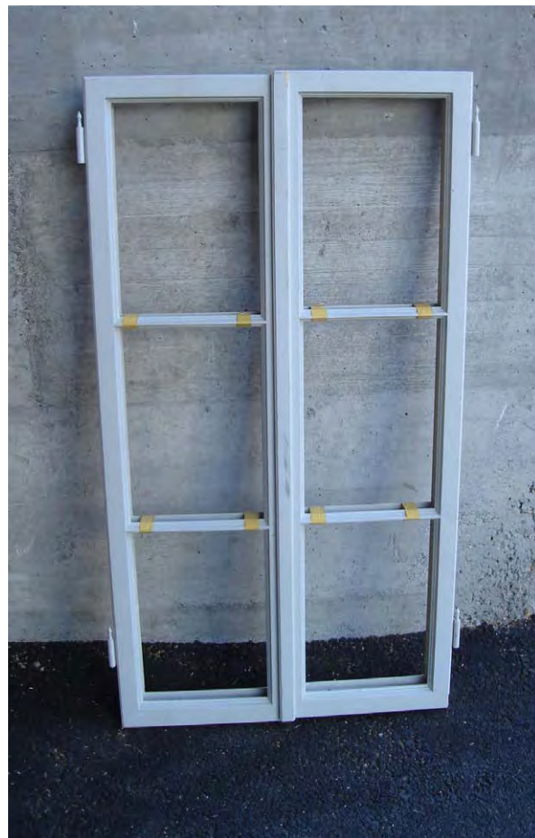
Muster IV-Fenster mit schlanken Flügelrahmen und Sprossen, hergestellt im Trennverfahren, ohne Glas (Abb. 33)
