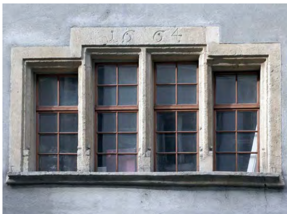
Spätgotisches Staffelfenster von 1664 mit jüngeren Verglasungen. Aarau, Haus zum Erker, Rathausgasse 10 (Abb. 8)
