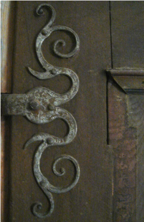
Ziseliertes S-Band um 1690 (Herrenhaus, Brännengut, Bern) (Abb. 37)
