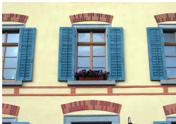
Uster, Lokremise 1855/56, Fassadenausschnitt Seitenflügel mit Galgenfenstern (Abb. 11)
