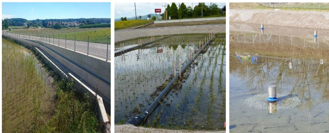
Abbildung 15: Verschiedene Systeme zur Verteilung des Zuflusses (Aufnahmen bei Einstau für Anwuchsphase des Schilfs)
