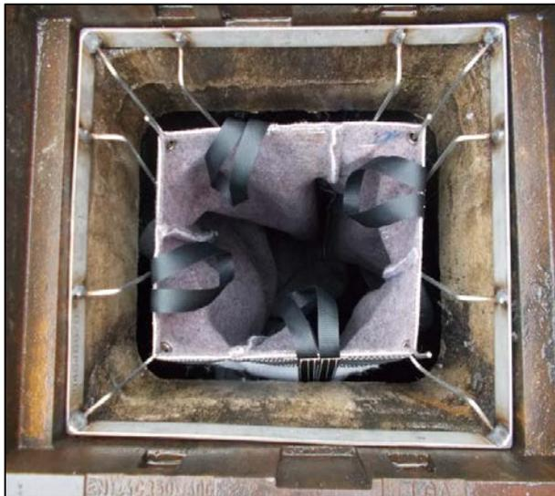
Abbildung 24: Tragkonstruktion im Schlammsammler mit rechteckigem Einlaufrost-Rahmen und eingehängtem GTS
