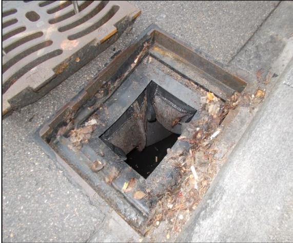
Abbildung 25: Leiteinrichtung auf rechteckigem Einlaufrost-Rahmen (Einlaufrost daneben) in einem Schlammsammler SA
