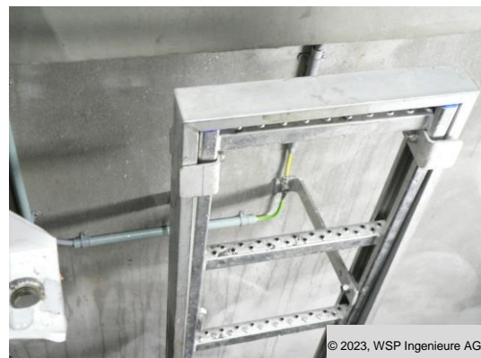
Abbildung 16: Aufgeräumte Sensorik (z.B. Schwimmerbirnen) und Potentialausgleich (Erdung) an Leiter
