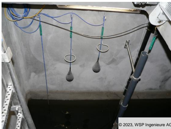
Abbildung 16: Aufgeräumte Sensorik (z.B. Schwimmerbirnen) und Potentialausgleich (Erdung) an Leiter
