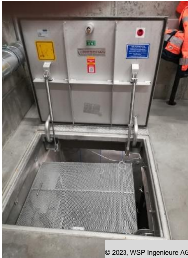
Abbildungen 13: Beispiel geöffnete Schachtabdeckung, geöffnete Absturzsicherung, ausgezogene Leiter
