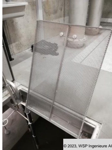
Abbildungen 13: Beispiel geöffnete Schachtabdeckung, geöffnete Absturzsicherung, ausgezogene Leiter
