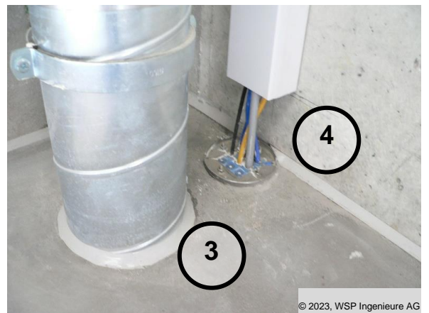
Abbildungen 14: Beispiel steckbares Geländer und gasdichte Durchführungen, Pumpwerk Wanne, Hinwil
