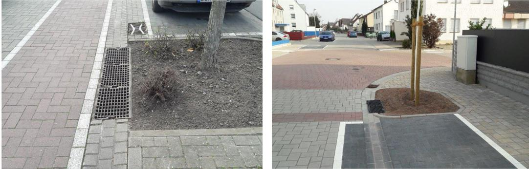
**Abbildung 23:** Einbauweisen mit Adsorbersubstrat von Fa. Funke Kunststoffe zur Entfernung von Spurenstoffen, MKW, Schwermetallen und GUS aus Strassenabwasser, bevor das Wasser in Baumrignolen geleitet wird (mündl. Mitteilung, R. Töws).
