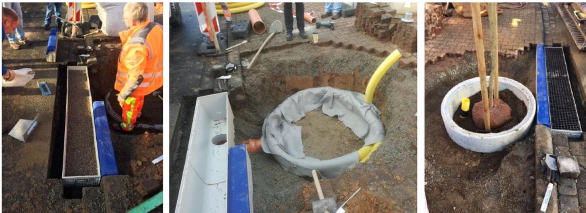
**Abbildung 24:** Einbau einer MEACLEAN Filtersubstratrinne (MEA Group) mit Zulauf von 2,6 l/s pro Meter Rinne und Ringzuleitung um den Wurzelballen. Das Substrat Biocalith MR-F1 stammt von ENREGIS und kann Schwermetalle, MKW und GUS zurückhalten<sup>15</sup>.
