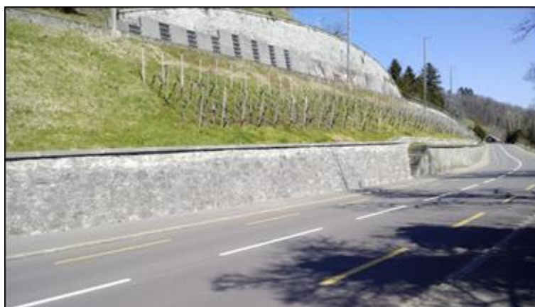
Abbildung 34: Mauer, Wand (© TBA ZH)
