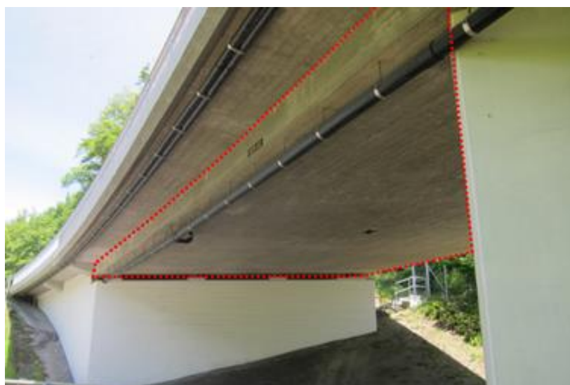
Abbildung 27: Fahrbahnplatte (© TBA ZH)
