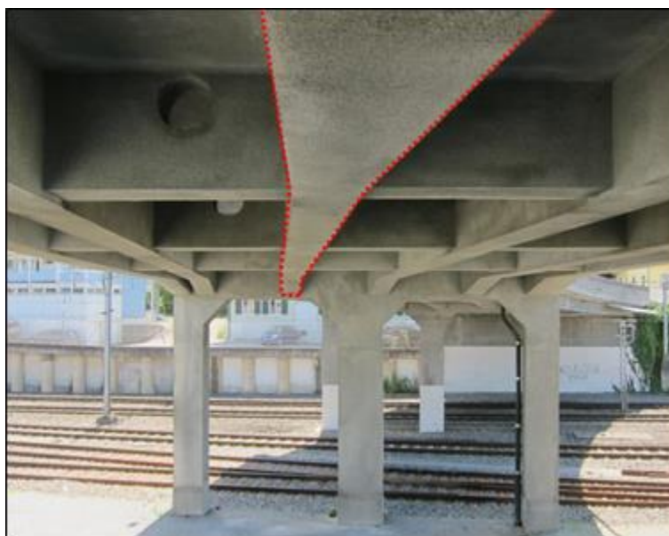
Abbildung 40: Träger, Steg (© TBA ZH)
