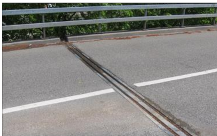
Abbildung 28: Fahrbahnübergang (© TBA ZH)
