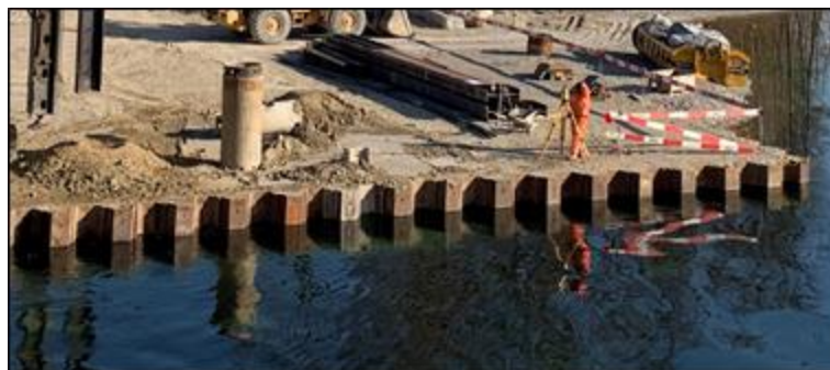
Abbildung 50: Spundwand (© TBA ZH)
