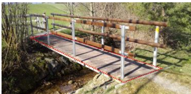
Abbildung 41: Tragender Fahrbahnbelag (© TBA ZH)
