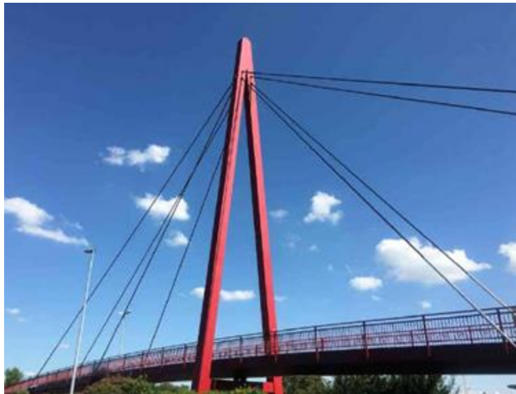
Abbildung 30: Hänger, Seile, Kabel (© TBA ZH)
