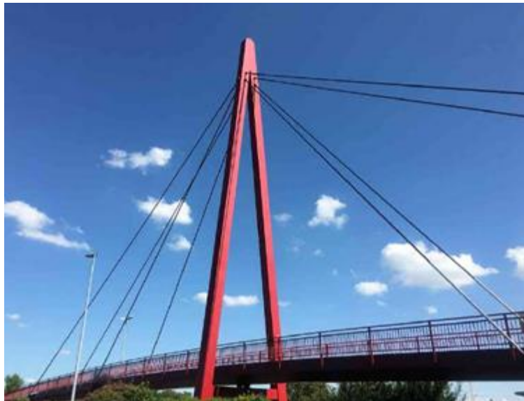
Abbildung 36: Pylon (© TBA ZH)
