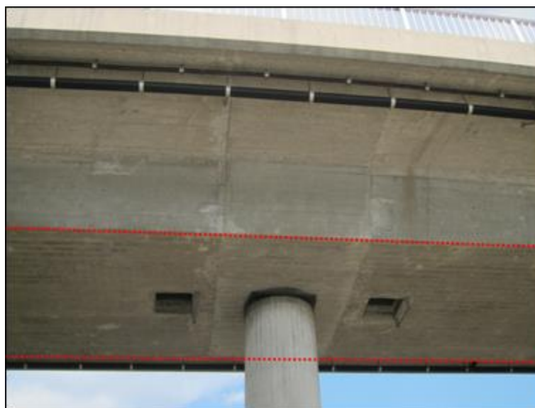
Abbildung 35: untere Kastenplatte (© TBA ZH)
