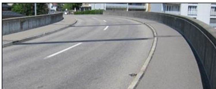
Abbildung 56: Brüstung, Leitmauer (© TBA ZH)
