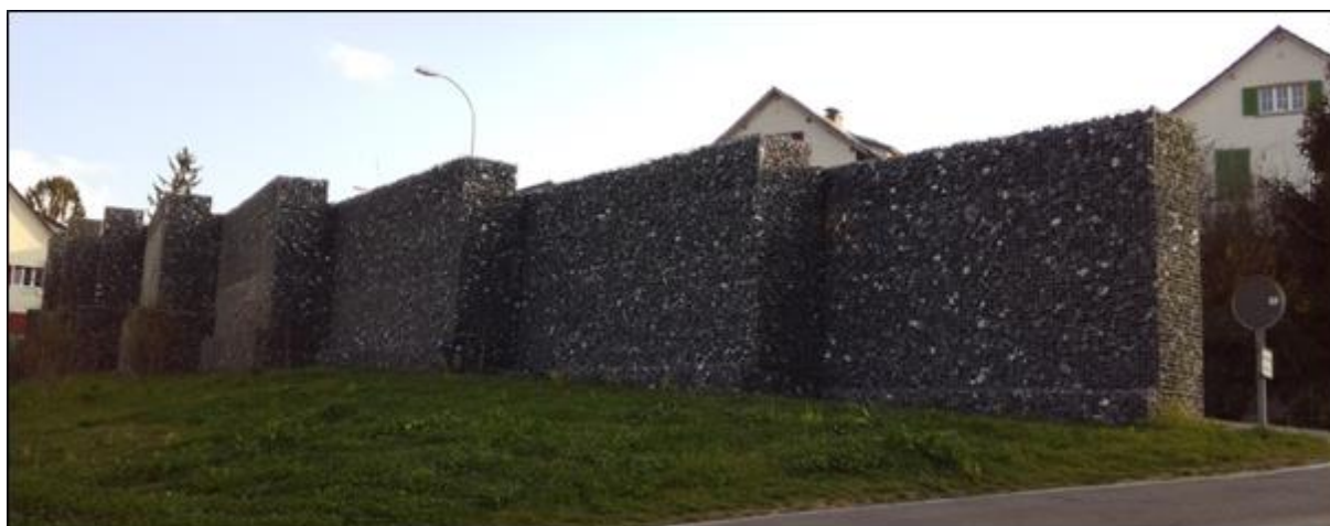
Abbildung 60: Lärmschutzelement
