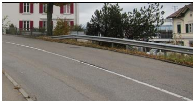
Abbildung 61: Rückhaltesysteme (© TBA ZH)
