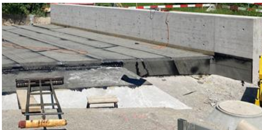
Abbildung 53: Abdichtung (© TBA ZH)
