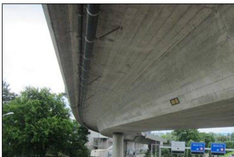
Abbildung 57: Entwässerung (© TBA ZH)
