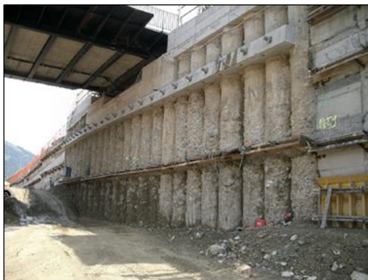
Abbildung 33: Longarine, Pfahlriegel
