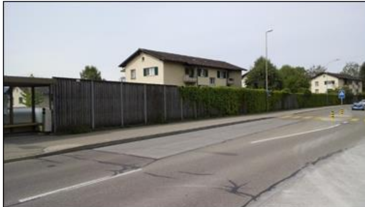
Abbildung 21: Lärmschutzwand (© TBA ZH)
