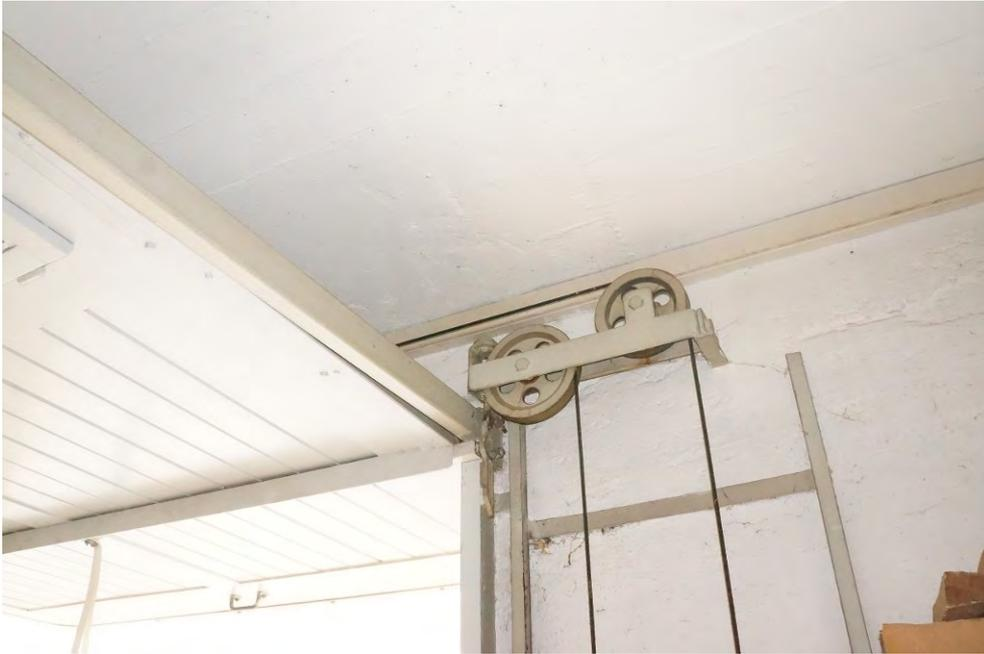
Friedhofanlage Rosenberg, Werkstattgebäude, bauzeitlicher Flaschenzug eines Garagentors, 09.04.2014 (Bild Nr. D100615\_07).
