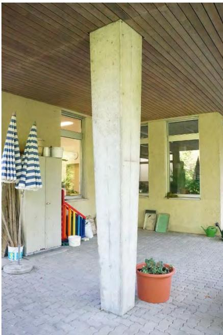
Klinik Schlosstal, ehem. Spinnerei Beugger, Erweiterungstrakt (238ERWEIT00571), sich gegen unten verjüngende Betonstütze und bauzeitlich erhaltene Dachuntersicht im Innenhof, 10.06.2014 (Bild Nr. D100648\_18).
