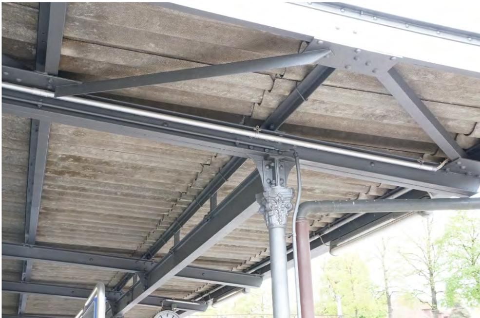
Bahnhof Winterthur Töss, Eisenkonstruktion des Perronvordachs und Eisensäulen, 15.04.2014 (Bild Nr. D100628\_36).
