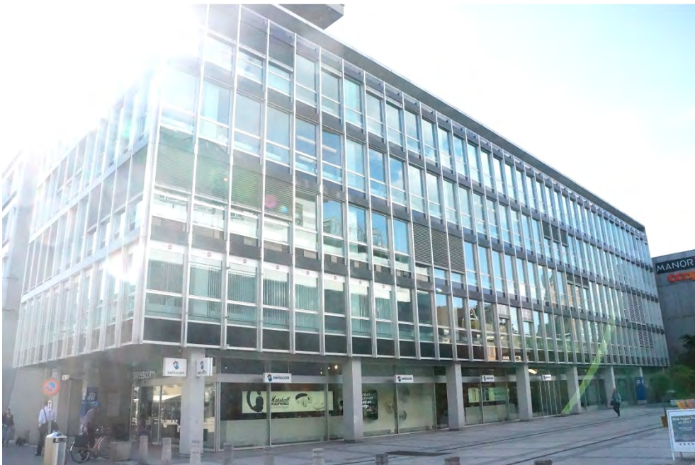
Geschäftshaus, ehem. Bankgebäude, Ansicht von SO, 19.05.2014 (Bild Nr. D100646_05).
