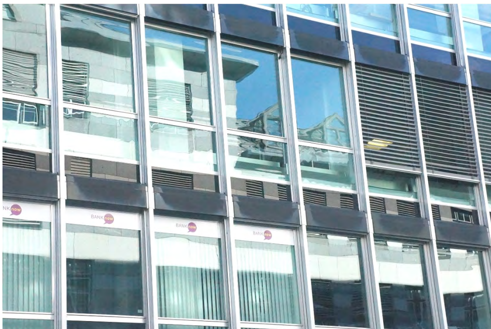
Geschäftshaus, ehem. Bankgebäude, Ostfassade (Detail), 19.05.2014 (Bild Nr. D100646_06).
