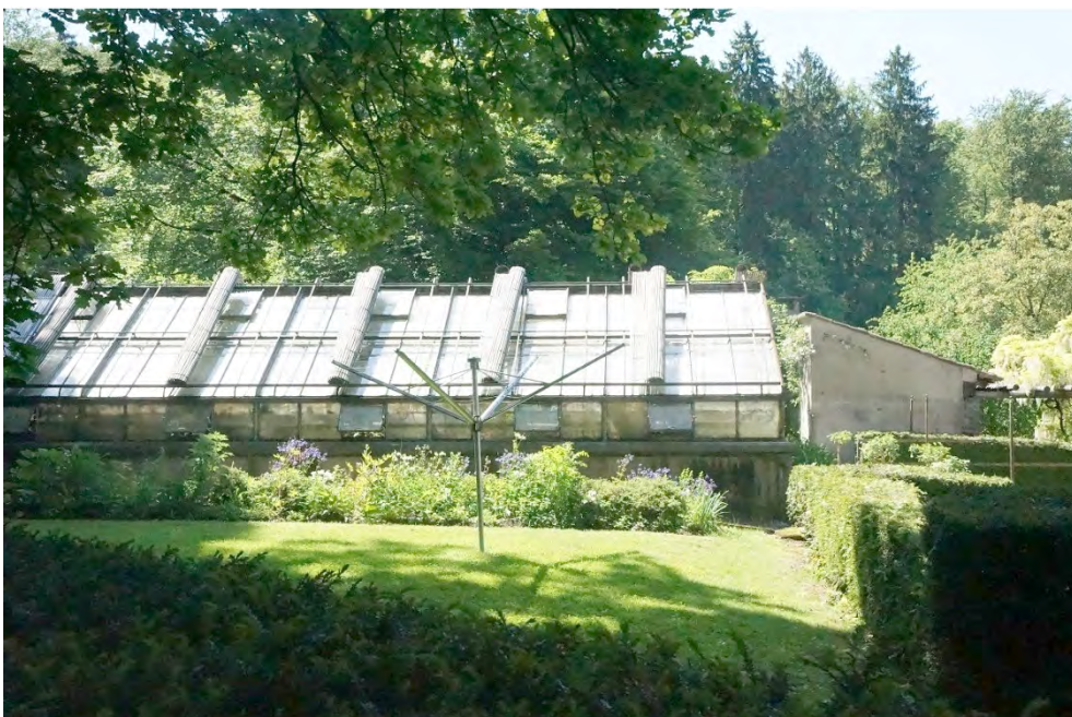
Ensemble Villa Reinhart, Gewächshaus 2 (Vers. Nr. 00017), Ansicht von NGewächshaus 2 (Vers. Nr. 00017), Ansicht von NGewächshaus 2 (Vers. Nr. 00017), Ansicht von Noberster Treppenabschnitt, Ansicht von der Aussichtsplattform, 15.05.2014 (Bild Nr. D100901_05).
