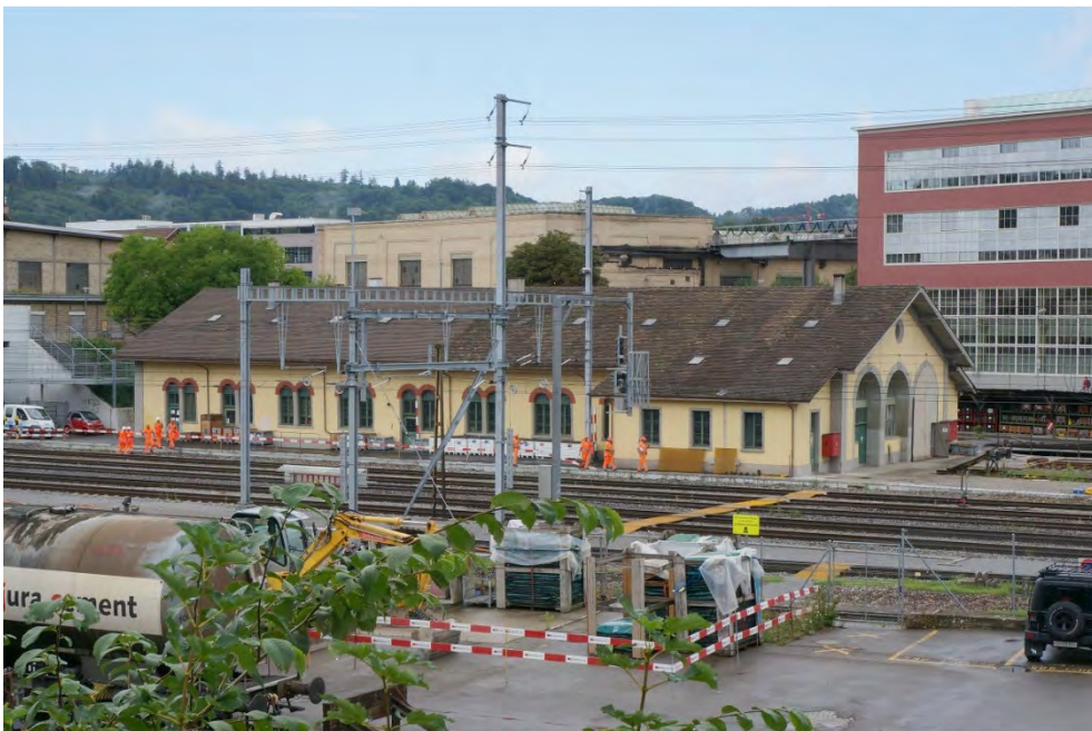
Bahninfrastrukturbauten zwischen Wylandbrücke und Lindspitz, Rechteckremise (Vers. Nr. 01043), Ansicht von O, 20.07.2017 (Bild Nr. D101146_83).
