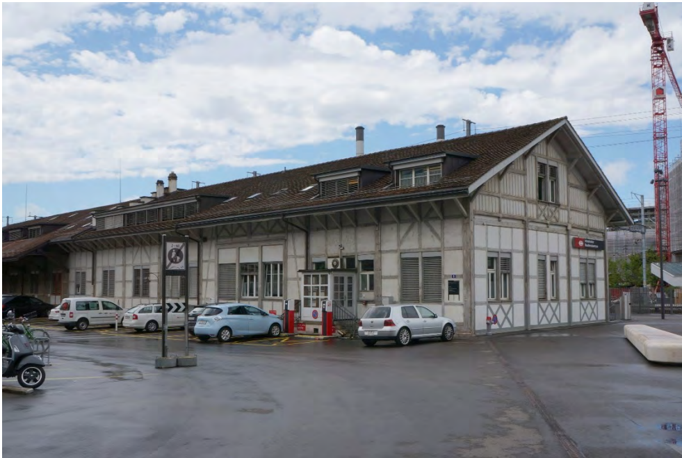
Bahninfrastrukturbauten zwischen Wylandbrücke und Lindspitz, Güterschuppen (Vers. Nr. 00467), Ansicht von NO, 20.07.2017 (Bild Nr. D101146_61).
