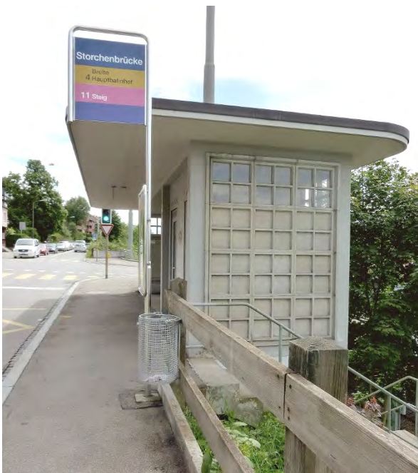
Buswartehäuschen Storchenbrücke, Ansicht von NO, 21.03.2013 (Bild Nr. D101137_24).
