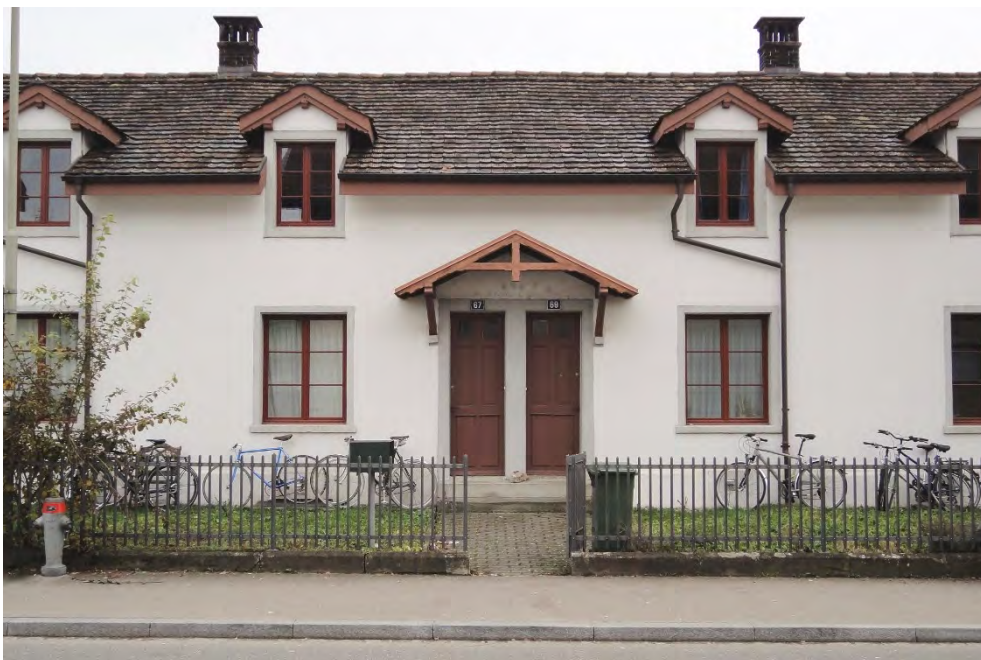
Arbeiterhäuser Jägerstrasse, Häuser der 1. Bauetappe 1873–1874 (Vers. Nr. 00919), Nordostfassaden, 21.11.2016 (Bild Nr. D101125_93).
