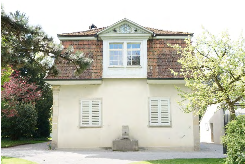
Ensemble Museum Lindengut, ehem. Gärtnerhaus (Vers. Nr. 00040), Ansicht von N, 15.04.2014 (Bild Nr. D100639_07).
