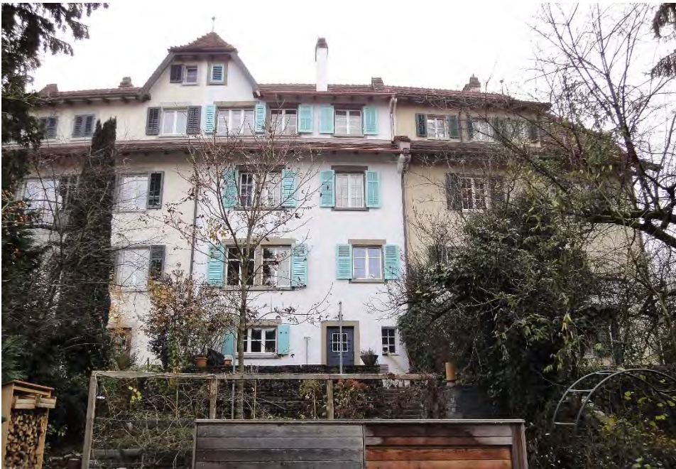
Siedlung Heiligberg II, Nordfassaden, rechter Teil (vorne rechts Vers. Nr. 02575), 25.11.2016 (Bild Nr. D101125_84).
