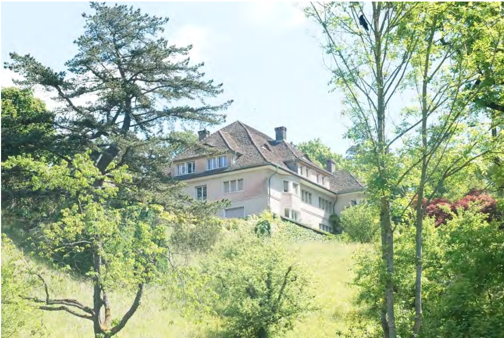
Ensemble Villa Reinhart, Wohnhaus Eichwaldstrasse 3 (Vers. Nr. 02825), Ansicht von SW, 15.05.2014 (Bild Nr. D100901_03).
