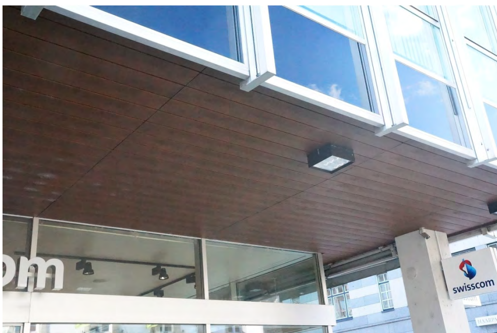
Geschäftshaus, ehem. Bankgebäude, Dachuntersicht im S, 19.05.2014 (Bild Nr. D100646_08).
