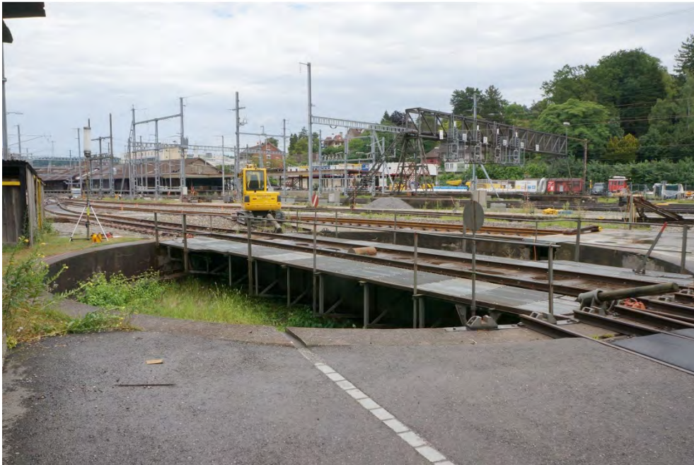
Bahninfrastrukturbauten zwischen Wylandbrücke und Lindspitz, Drehscheibe (237DREH01043), Ansicht von SW, 20.07.2017 (Bild Nr. D101146_88).
