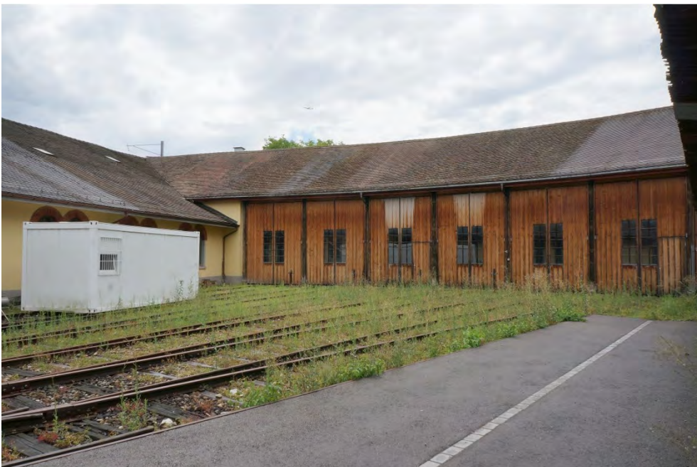
Bahninfrastrukturbauten zwischen Wylandbrücke und Lindspitz, Kressesegmentremise (Vers. Nr. 01043), Tore, Ansicht von NO, 20.07.2017 (Bild Nr. D101146_86).
