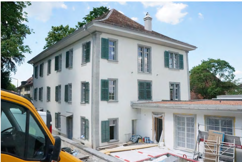
Ensemble «Schanzengarten», Wohnhaus (Vers. Nr. 00221), Ansicht von SO, 15.04.2014 (Bild Nr. D100638_03).
