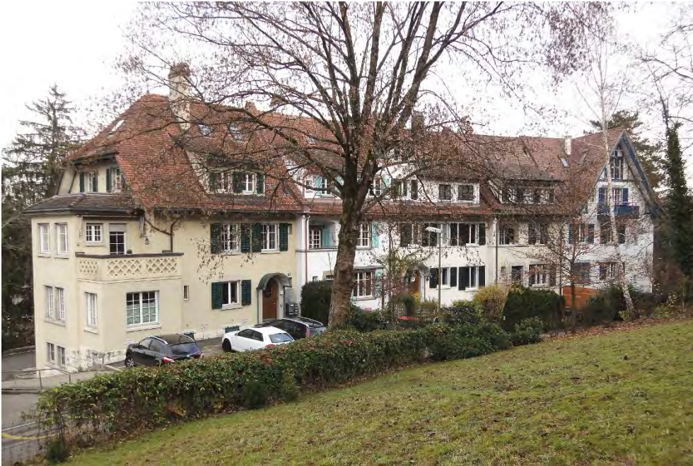
Siedlung Heiligberg II, Ansicht von SW, 25.11.2016 (Bild Nr. D101125_81).
