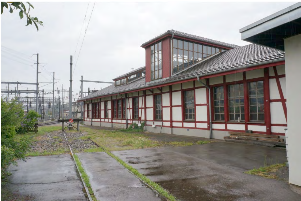
Bahninfrastrukturbauten zwischen Wylandbrücke und Lindspitz, Werkstattgebäude «Depot G» (Vers. Nr. 01951), Südostfassade, Ansicht von NO, 20.07.2017 (Bild Nr. D101146_04).
