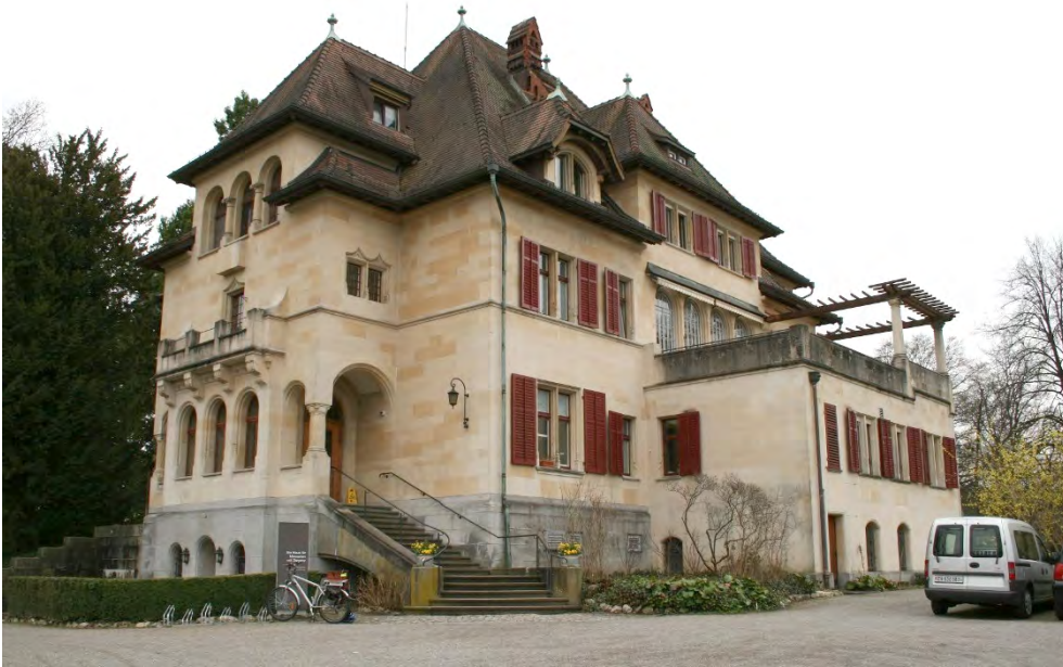
Ensemble «Sonnenberg», Villa (Vers. Nr. 00243), Ansicht von NW, 21.03.2017 (Bild Nr. D101130_31).
