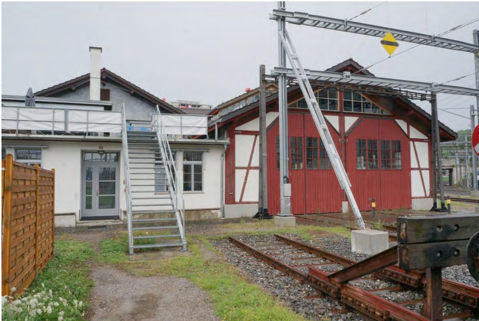
Bahninfrastrukturbauten zwischen Wylandbrücke und Lindspitz, Werkstattgebäude «Depot G» (Vers. Nr. 01951), Ansicht von SW, 20.07.2017 (Bild Nr. D101146_03).
