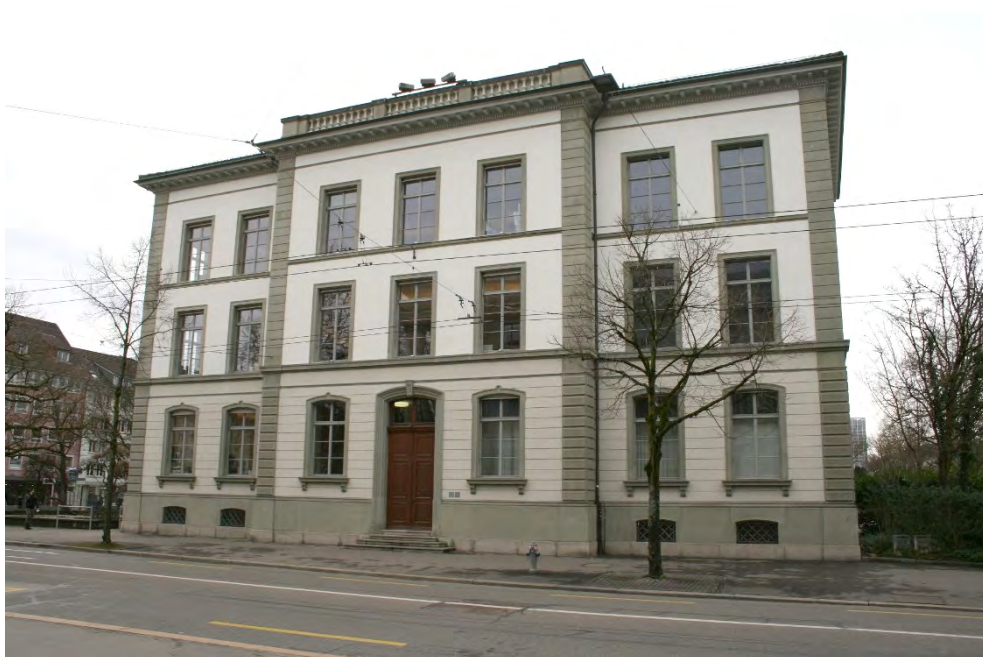
Schulhaus Altstadt, Ansicht von O, 28.02.2017 (Bild Nr. D101134_05).
