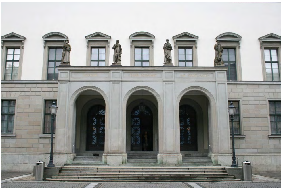
Museum Oskar Reinhart, ehem. Knabengymnasium und Gewerbeschulhaus, Portikus, 28.02.2017 (Bild Nr. D101127_03).
