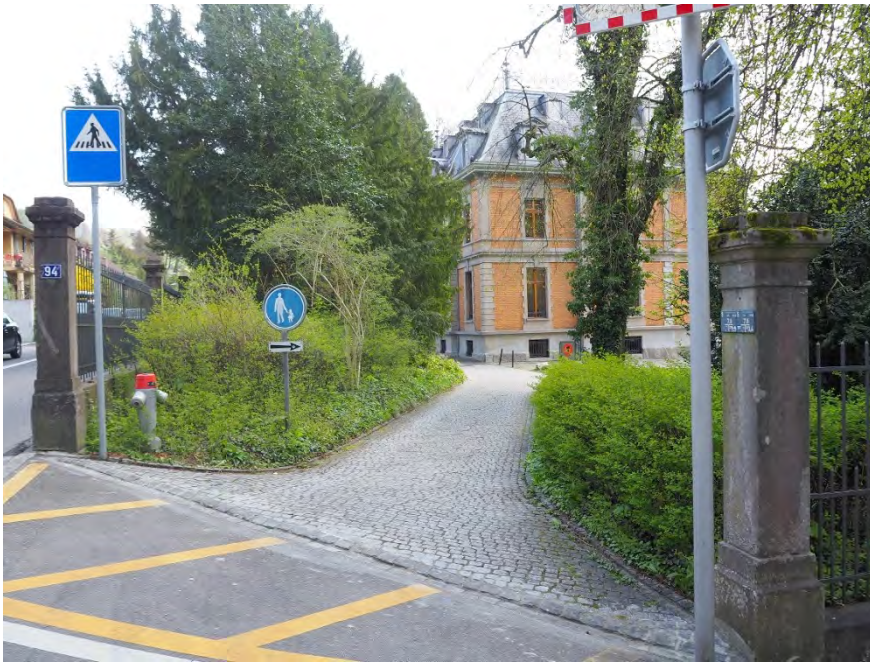
Ensemble Villa Rychenberg, Villa (Vers. Nr. 01422) und Rychenbergpark, Einfriedung mit Zufahrt von NW, Ansicht von NW, 05.04.2017 (Bild Nr. D100622_38).
