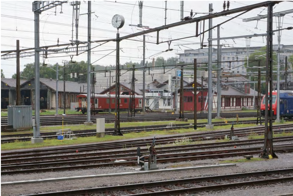
Bahninfrastrukturbauten zwischen Wylandbrücke und Lindspitz, Werkstattgebäude «Depot G» (Vers. Nr. 01951), links das Depot H, Ansicht von SO, 20.07.2017 (Bild Nr. D101146_02).
