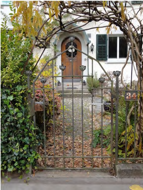
Siedlung Heiligberg II, Hauseingang Südfassade (Vers. Nr. 02573), 25.11.2016 (Bild Nr. D101125_86).
