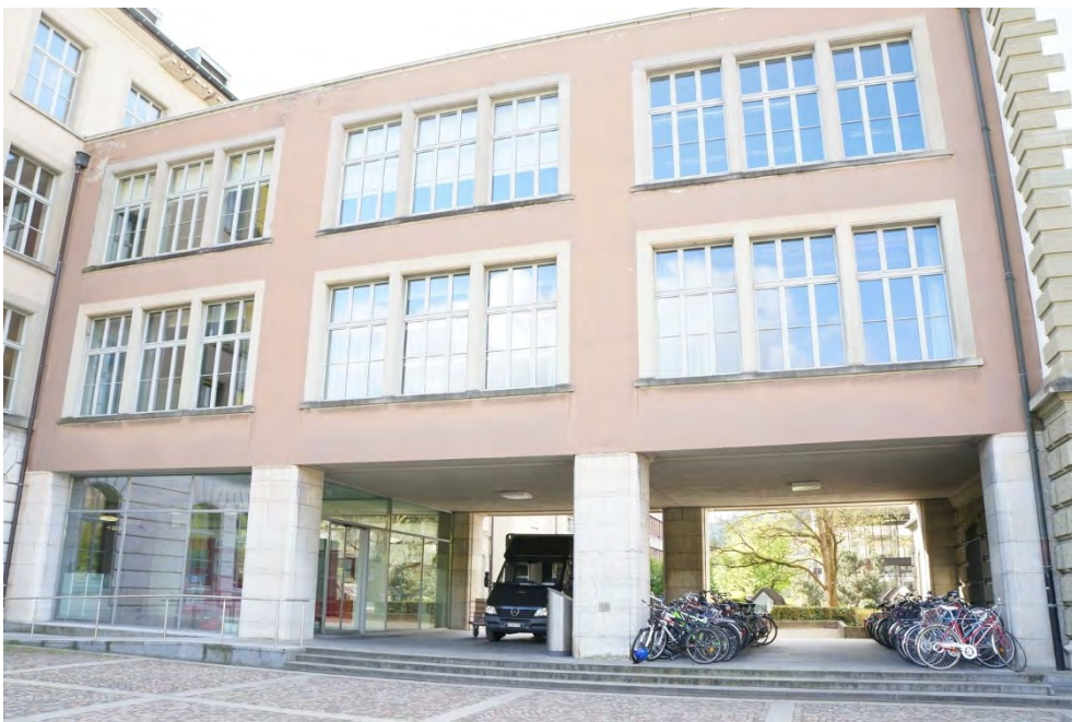
Bauten der Zürcher Hochschule für Angewandte Wissenschaften, ehem. Technikum, Verbindungsgang (Vers. Nr. 07099), Ansicht von N, 15.04.2014 (Bild Nr. D100610_20).
