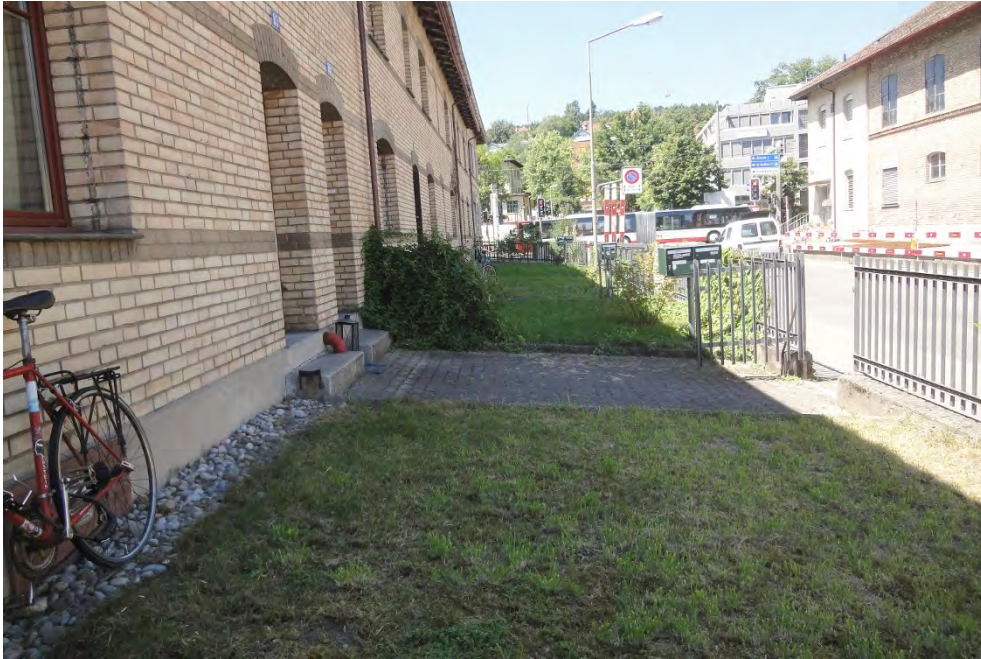
Arbeiterhäuser Jägerstrasse, 2. Bauetappe, Vorgarten an der Jägerstrasse, Ansicht von SO, 20.07.2016 (Bild Nr. D101125_98).
