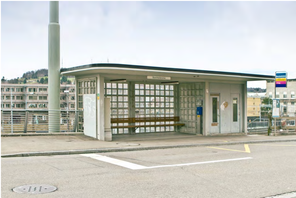
Buswartehäuschen Storchenbrücke, Ansicht von SO, 19.03.2013 (Bild Nr. D101137_21).
