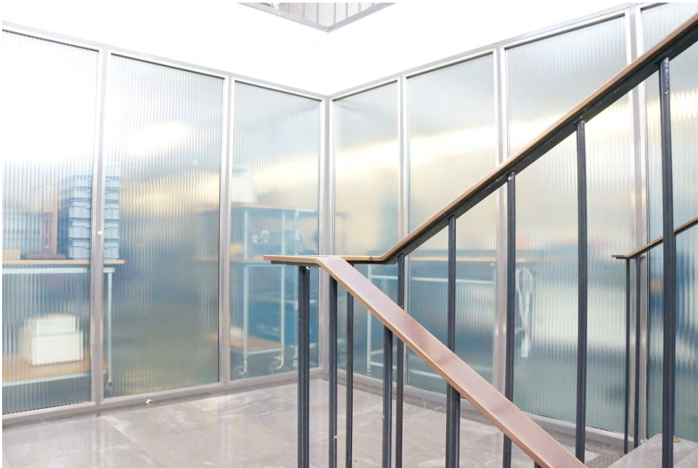
Bauten der Zürcher Hochschule für Angewandte Wissenschaften, ehem. Technikum, Physikgebäude (Vers. Nr. 00471), zentrale Treppenanlage, Zwischengeschoss mit bauzeitlichen Plexiglaswänden, 15.04.2014 (Bild Nr. D100610_09).
