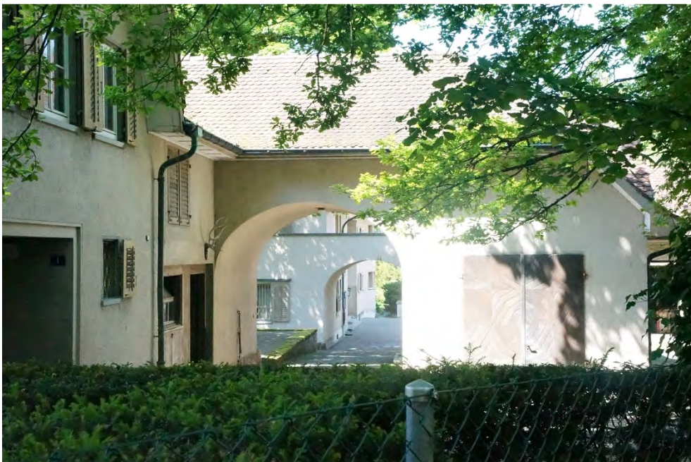
Ensemble Villa Reinhart, Durchgang nördlich des Wohnhauses Eichwaldstrasse 1 (Vers. Nr. 02826), Ansicht von O, 15.05.2014 (Bild Nr. D100901_08).
