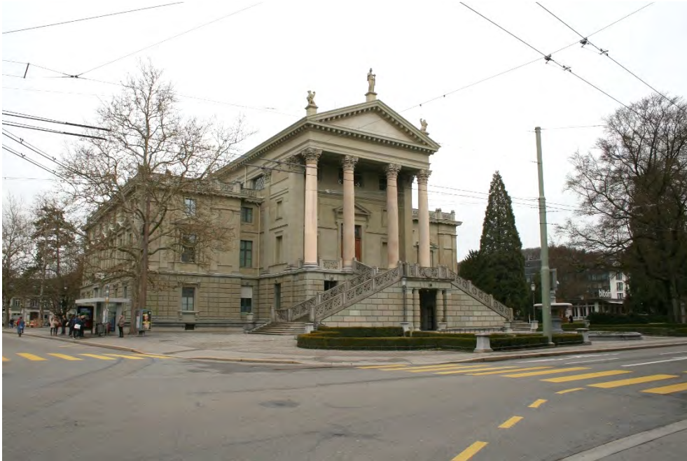
Stadthaus mit Gartenanlage und Brunnen, Stadthaus (Vers. Nr. 00602), Ansicht von SW, 28.02.2017 (Bild Nr. D101134_32).
