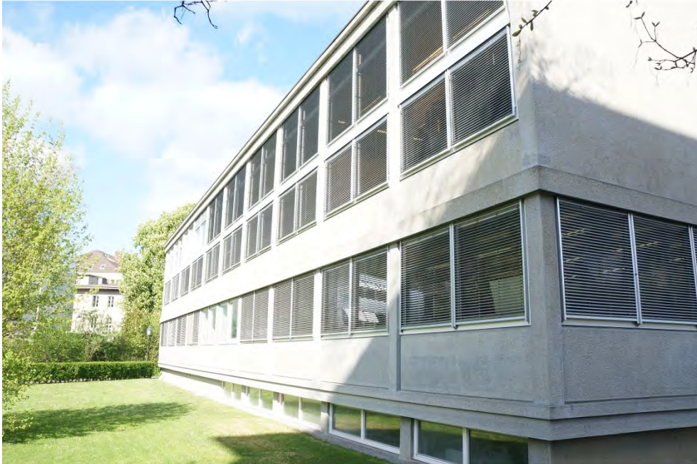
Bauten der Zürcher Hochschule für Angewandte Wissenschaften, ehem. Technikum, Physikgebäude (Vers. Nr. 00471), Ansicht von SO, 15.04.2014 (Bild Nr. D100610_06).
