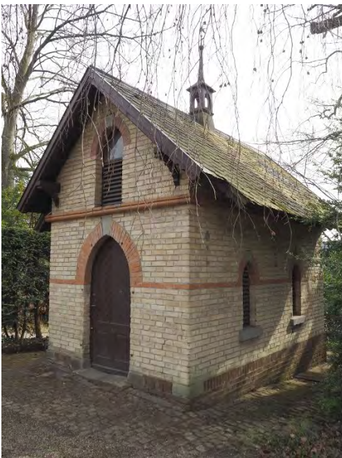
Ensemble Villa «Bühlstein», ehem. Gärtnerhäuschen (Ver. Nr. 01337), Ansicht von N, 21.03.2017 (Bild Nr. D101130_23).
