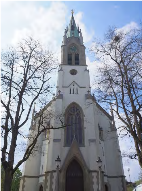
Kath. Kirche St. Peter und Paul, Turmfassade, Ansicht von NO, 06.04.2017 (Bild Nr. D101130_58).
