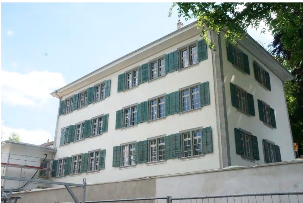
Ensemble «Schanzengarten», Wohnhaus (Vers. Nr. 00221), Ansicht von N, 15.04.2014 (Bild Nr. D100638_10).
