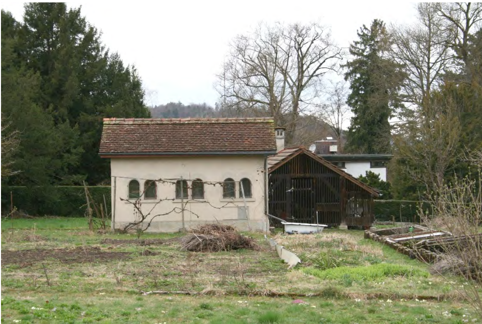
Ensemble «Sonnenberg», Gartenhaus (Vers. Nr. 03922), Ansicht von SO, 21.03.2017 (Bild Nr. D101130_30).
