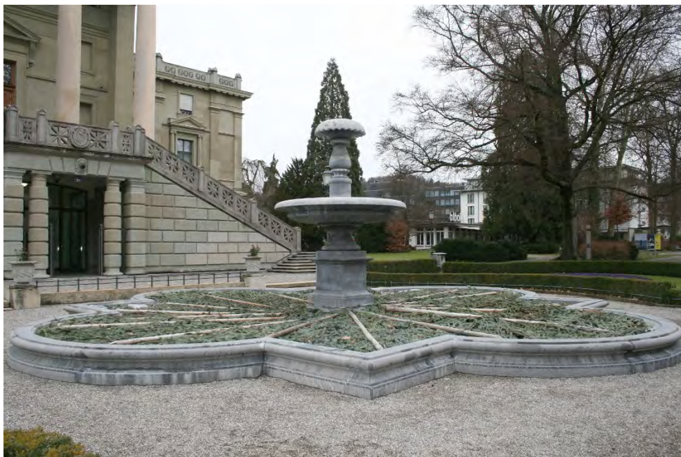
Stadthaus mit Gartenanlage und Brunnen, Brunnen, Ansicht von SW, 28.02.2017 (Bild Nr. D101134_37).
