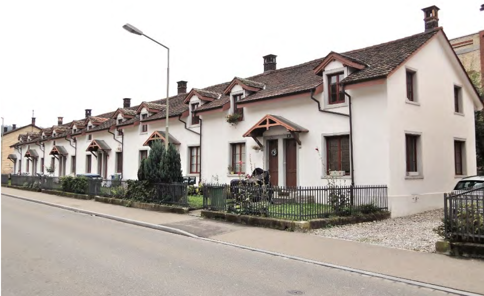
Arbeiterhäuser Jägerstrasse, Hausreihe der 1. Bauetappe 1873–1874 (vorne rechts Vers. Nr. 00919), 09.10.2013 (Bild Nr. D101125_91).
