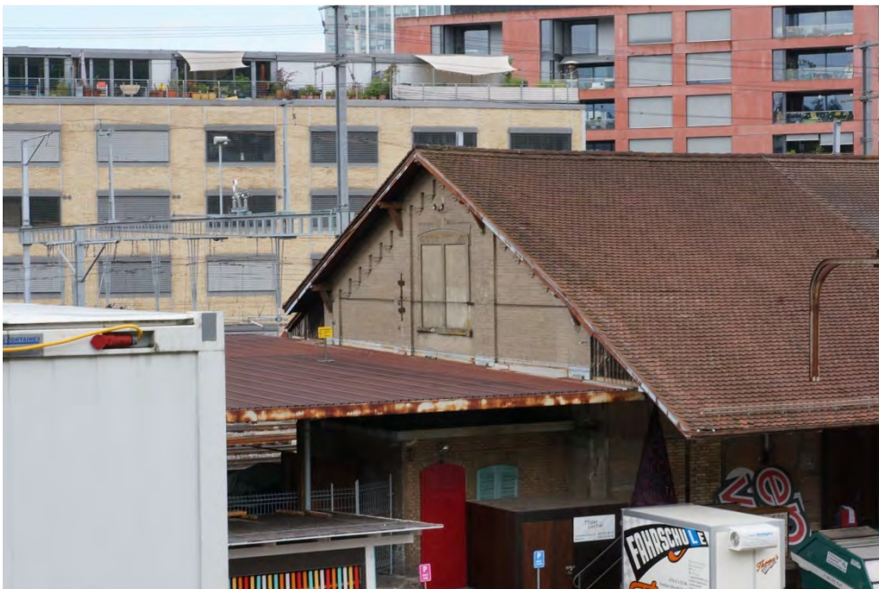
Bahninfrastrukturbauten zwischen Wylandbrücke und Lindspitz, Güterschuppen (Vers. Nr. 00467), Südwestfassade, 20.07.2017 (Bild Nr. D101146_63).
