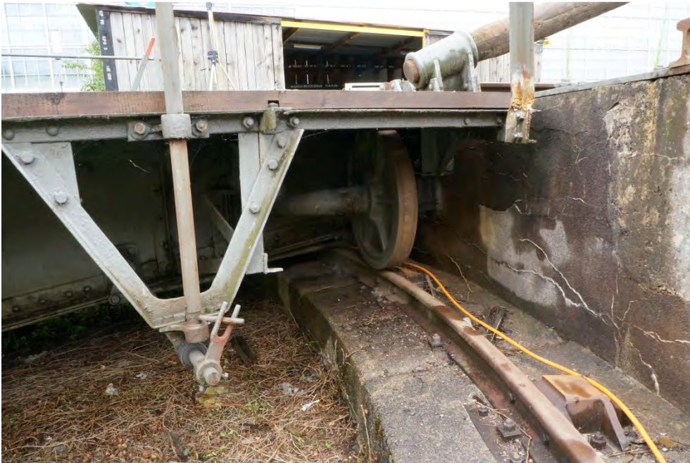
Bahninfrastrukturbauten zwischen Wylandbrücke und Lindspitz, Drehscheibe (237DREH01043), Fahrgestell der Vollwandstahlträger auf kreisförmigem Gleis, 20.07.2017 (Bild Nr. D101146_90).
