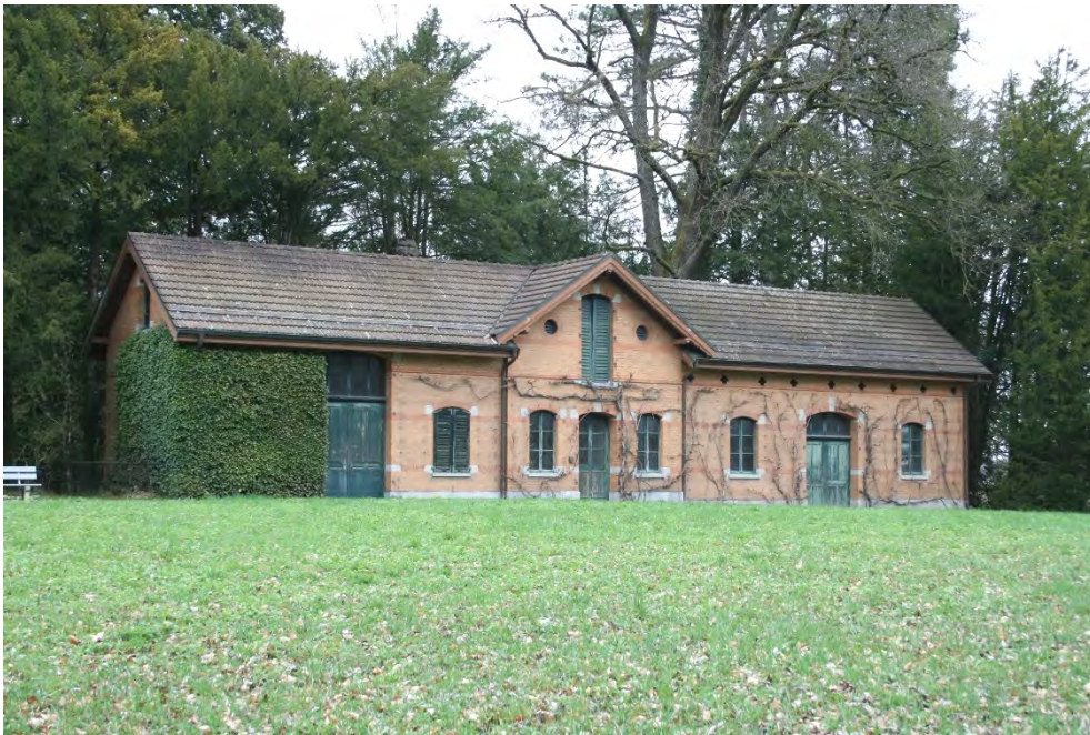
Ensemble «Sonnenberg», Nebengebäude (Vers. Nr. 02406), Ansicht von SW, 21.03.2017 (Bild Nr. D101130_35).
