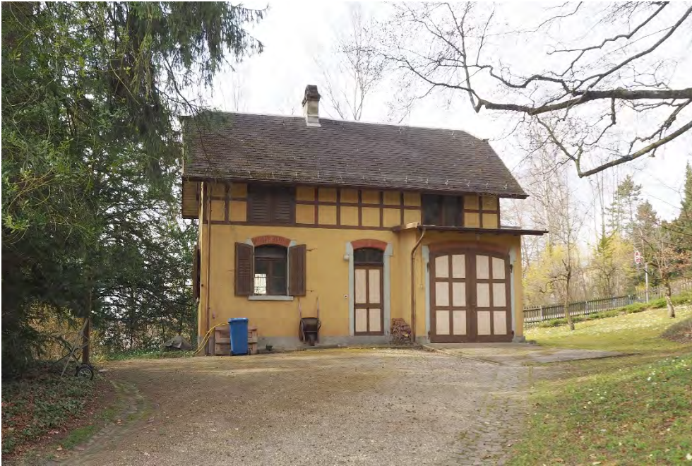
Ensemble Villa «Bühlhalde», Gerätehaus (Vers. Nr. 02419), Ansicht von SO, 21.03.2017 (Bild Nr. D101130_42).
