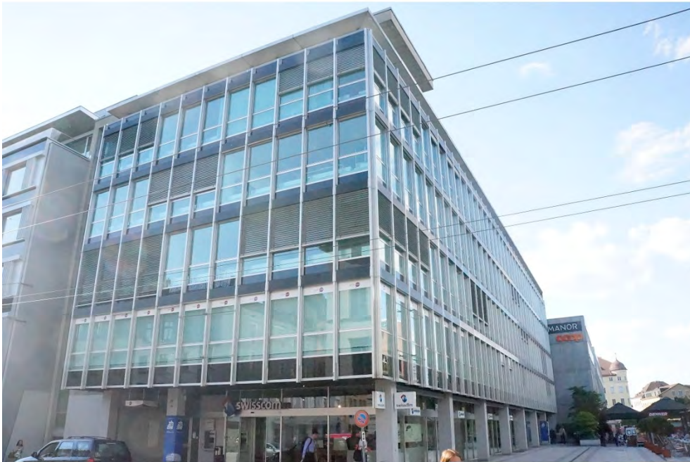
Geschäftshaus, ehem. Bankgebäude, Ansicht von SO, 19.05.2014 (Bild Nr. D100646_04).
