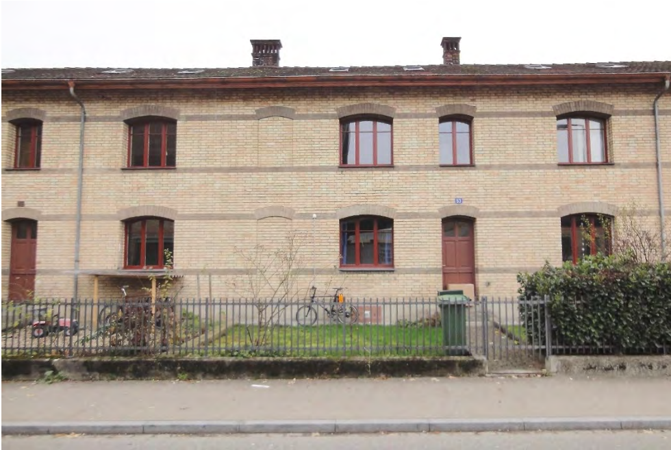
Arbeiterhäuser Jägerstrasse, Wohnhäuser für Arbeiter, 2. Bauetappe 1890–1891 (Vers. Nr. 01633), Nordostfassaden, 09.10.2013 (Bild Nr. D101125_96).
