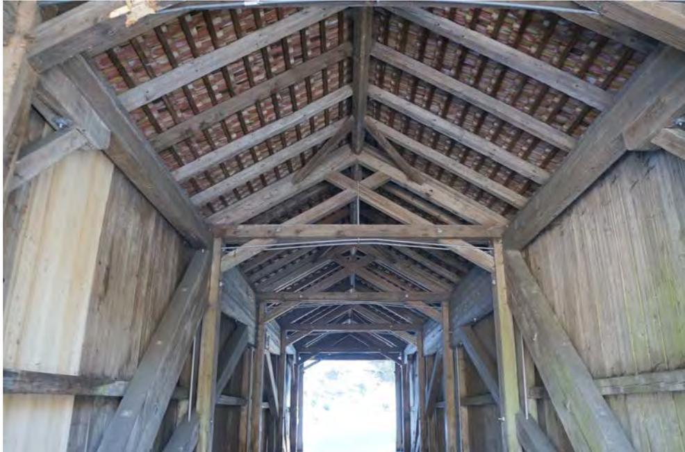
Gedeckte Holzbrücke, Dachkonstruktion, Wände und Sprengwerk sowie drei Doppelhängesäulen, Blick Richtung S, 03.10.2014 (Bild Nr. D101112\_65).
