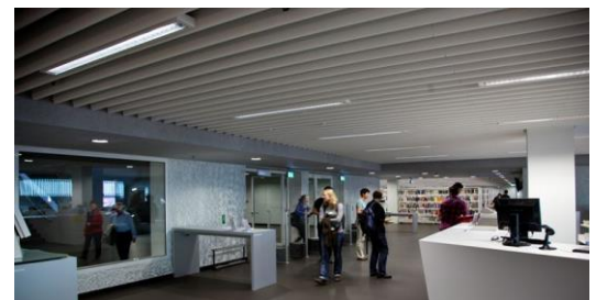
Abbildung 5: Bibliothek ZHB Luzern, UNI/PH-Gebäude, Akustikmassnahmen mit sog. Baffles an der Decke
