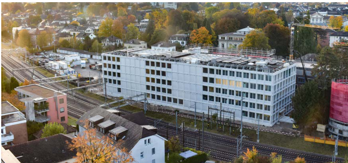
Die sanierte Winterthurer Bezirksanlage. Die Mitarbeitenden der Staatsanwaltschaft Winterthur/Unterland werden Mitte 2024 ins Gebäude zurückkehren.
