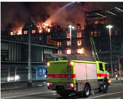
Eine der grössten Feuersbrünste der letzten Jahre in der Stadt Zürich: Im August 2018 richtete ein Brand im historischen «Du-Pont-Gebäude» enormen Schaden an.
